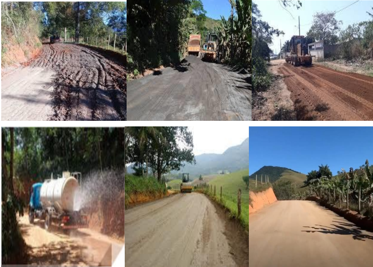
Reprodução de imagens de aplicação do revsol nas estradas rurais.
