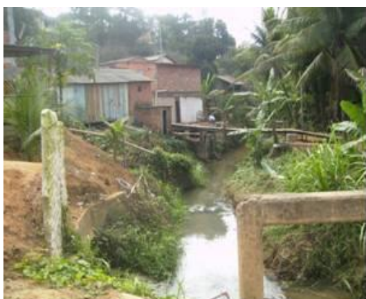
Figura 3-10 - Área de padrão precário e alagamento – Margens Rio São Domingos.
