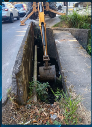
DESOBSTRUÇÃO DE GALERIA DE ÁGUAS PLUVIAIS Chácara do Paraíso
