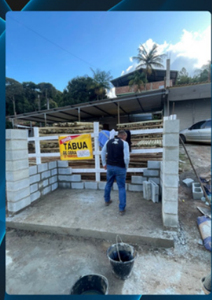
CONSTRUÇÃO DE PONTO DE ÔNIBUS Av. Antônio Mário de Azevedo, Campo do Coelho
