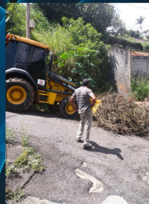
RECOLHIMENTO DE ENTULHO São Geraldo
