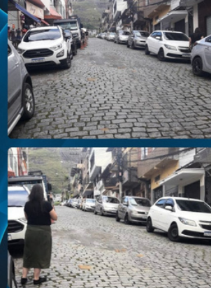
RECUPERAÇÃO DE CALÇAMENTO R. São Roque, Olaria
