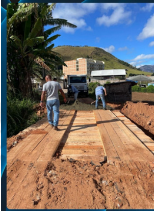
CONSTRUÇÃO DE PONTE Loteamento Almeida, Conquista
