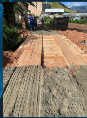
CONSTRUÇÃO DE PONTE Loteamento Almeida, Conquista
