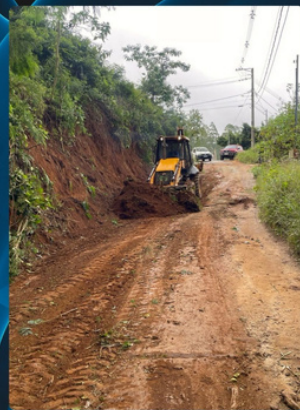
RECUPERAÇÃO DE ESTRADA Córrego Frio, Campo do Coelho
