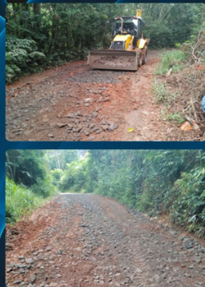
MANUTENÇÃO DE ESTRADA Morro das Contas, Amparo
