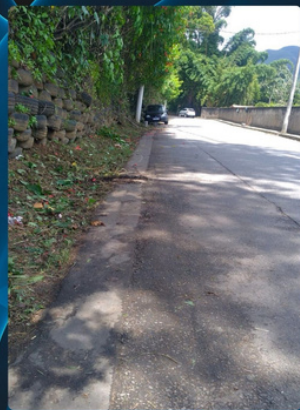
ROÇADA E CAPINA Av. Nossa Sra. do Amparo
