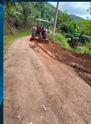
LIMPEZA E MANUTENÇÃO Estrada Duas Barras, Campo do Coelho
