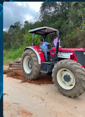
RECUPERAÇÃO DE ESTRADA R. Duas Barras, Campo do Coelho
