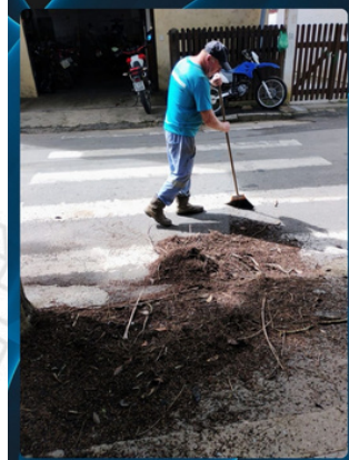
LIMPEZA DE TELHADO E CALHAS E. M. Acyr Spitz, Lúmiar
