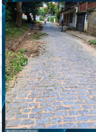
ROÇADA, CAPINA E LIMPEZA Ponte da Saudade
