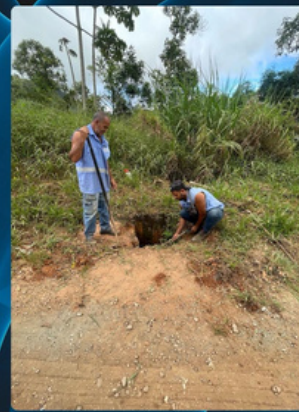
DESOBSTRUÇÃO DE BUEIROS R. Sebastião Rosa, Campo do Coelho
