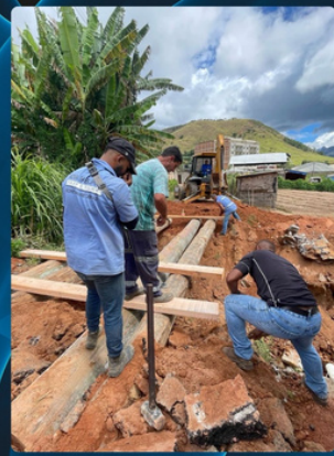
CONSTRUÇÃO DE PONTE Loteamento Almeida, Conquista
