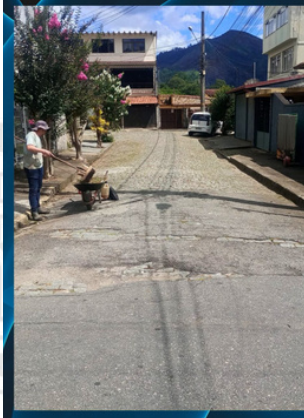
ROÇADA, CAPINA E LIMPEZA Perissê
