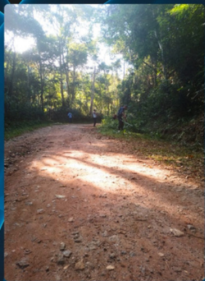
ROÇADA Estrada Velha, Toledo
