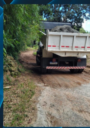
RECUPERAÇÃO DE ESTRADA Rua dos Gravinos, São Lourenço
