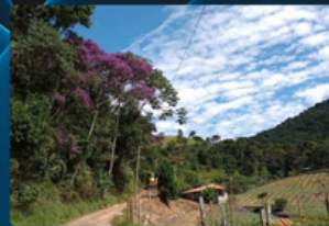
RECUPERAÇÃO DE ESTRADA Estrada da Granja Spinelli
