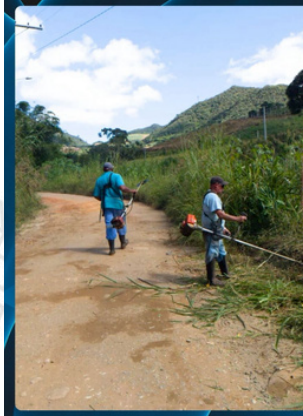
MANUTENÇÃO DE ESTRADA Estrada Floresta Mendes, Campo do Coelho
