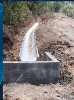
INSTALAÇÃO DE 80 CALHAS Invernada, Conselheiro Paulino
