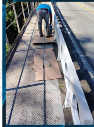
PINTURA DE PONTE Ponte da Saudade
