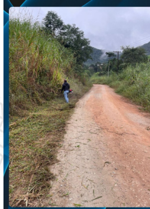
ROÇADA, CAPINA E LIMPEZA Estrada Floresta Mendes
