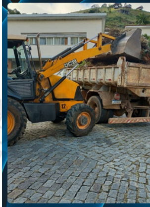
RETIRADA DE ENTULHO IRREGULAR Ponte da Saudade
