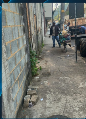
RECOLHIMENTO DE ENTULHO IRREGULAR Rua Carlos Éboli, Centro
