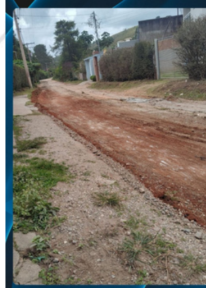
RECUPERAÇÃO DE ESTRADA Rua Saquarema, Campo do Coelho
