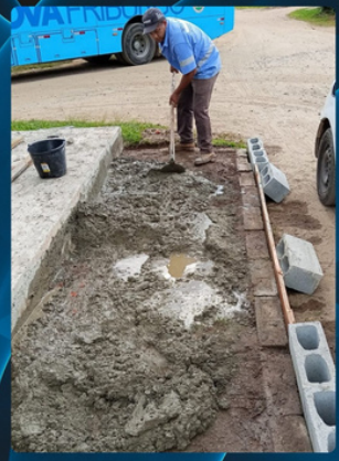
CONSTRUÇÃO DE PISO EM PONTO DE ÔNIBUS Toledo, Amparo
