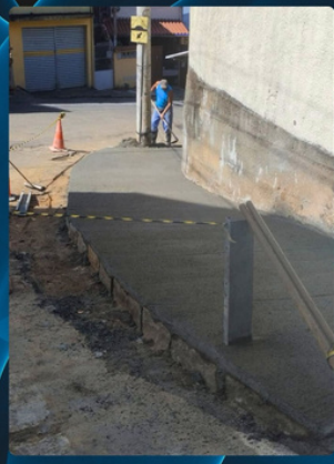
CONSTRUÇÃO DE CALÇADA E.M. Helio Gonçalves Correa, Jardimlândia
