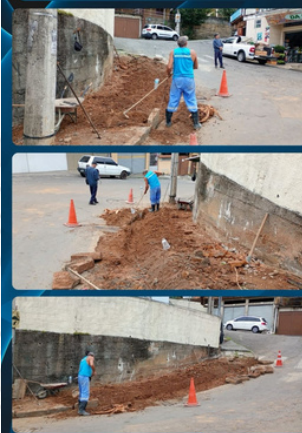
CONSTRUÇÃO DE CALÇADA Jardimlândia, Jd. Ouro Preto
