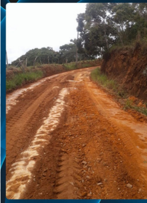
RECUPERAÇÃO DE ESTRADA Estrada do Barro Branco, Riograndina
