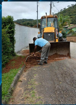
RECOLHIMENTO DE RESÍDUOS DE CAPINA Bairro Suíço
