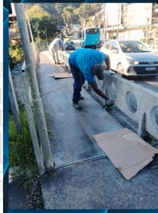
PINTURA DE PONTE Ponte da Saudade
