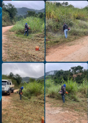
ROÇADA, CAPINA E LIMPEZA Estrada Floresta Mendes
