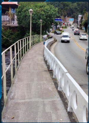
PINTURA DE PONTE Ponte da Saudade
