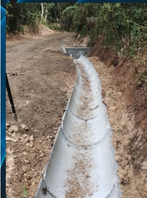
INSTALAÇÃO DE 80 CALHAS Invernada, Conselheiro Paulino
