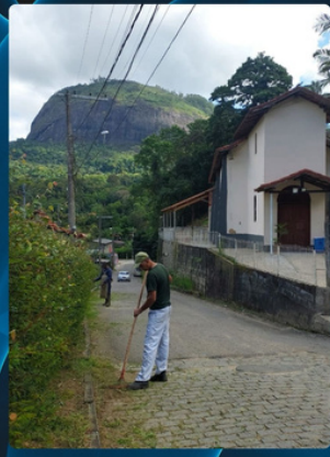
ROÇADA, CAPINA E LIMPEZA Loteamento Opção, Amparo
