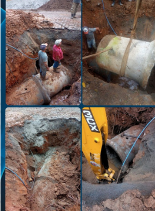
RECUPERAÇÃO DE REDE PLUVIAL Alameda Visconde de Inhaúma, Pq. São Clemente
