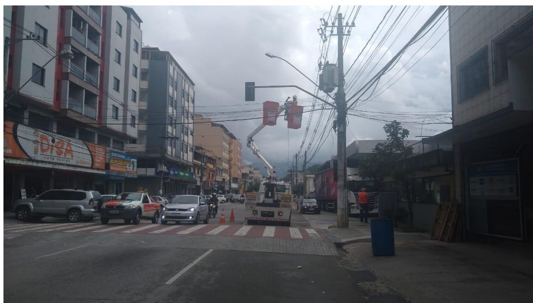
Instalação do Semáforo.
