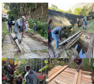
REFORMA DE PONTE
