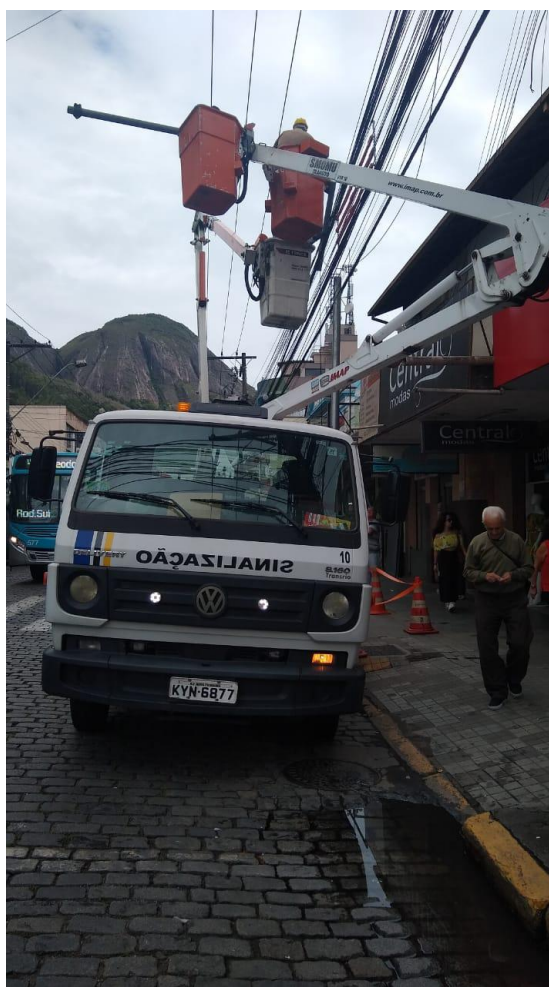
Instalação do Semáforo.
