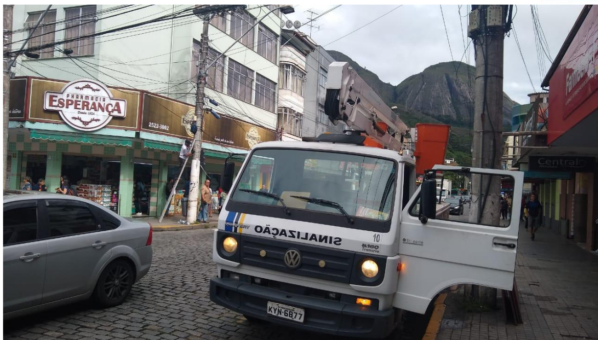
Instalação do Semáforo.
