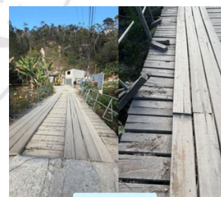
REFORMA DE PONTE Rio Grandina
