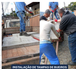
INSTALAÇÃO DE TAMPAS DE BUEIROS Amparo
