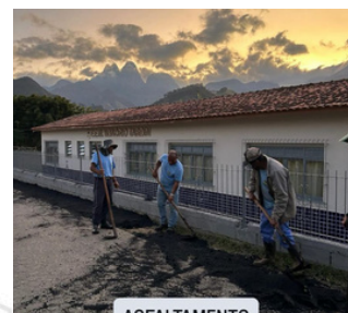
ASFALTAMENTO Baixada De Salinas
