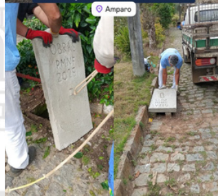
INSTALAÇÃO DE TAMPAS DE BUEIROS Amparo
