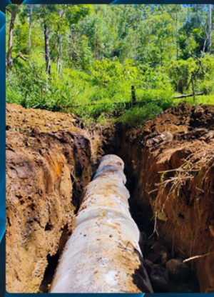
CONSTRUÇÃO DE BUEIRO Estrada João Heringer, Vargem Alta
