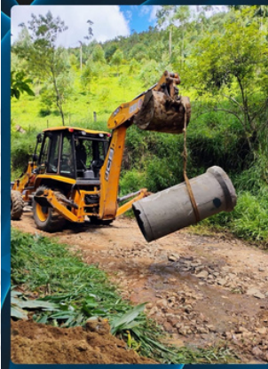
CONSTRUÇÃO DE BUEIRO Estrada João Heringer, Vargem Alta
