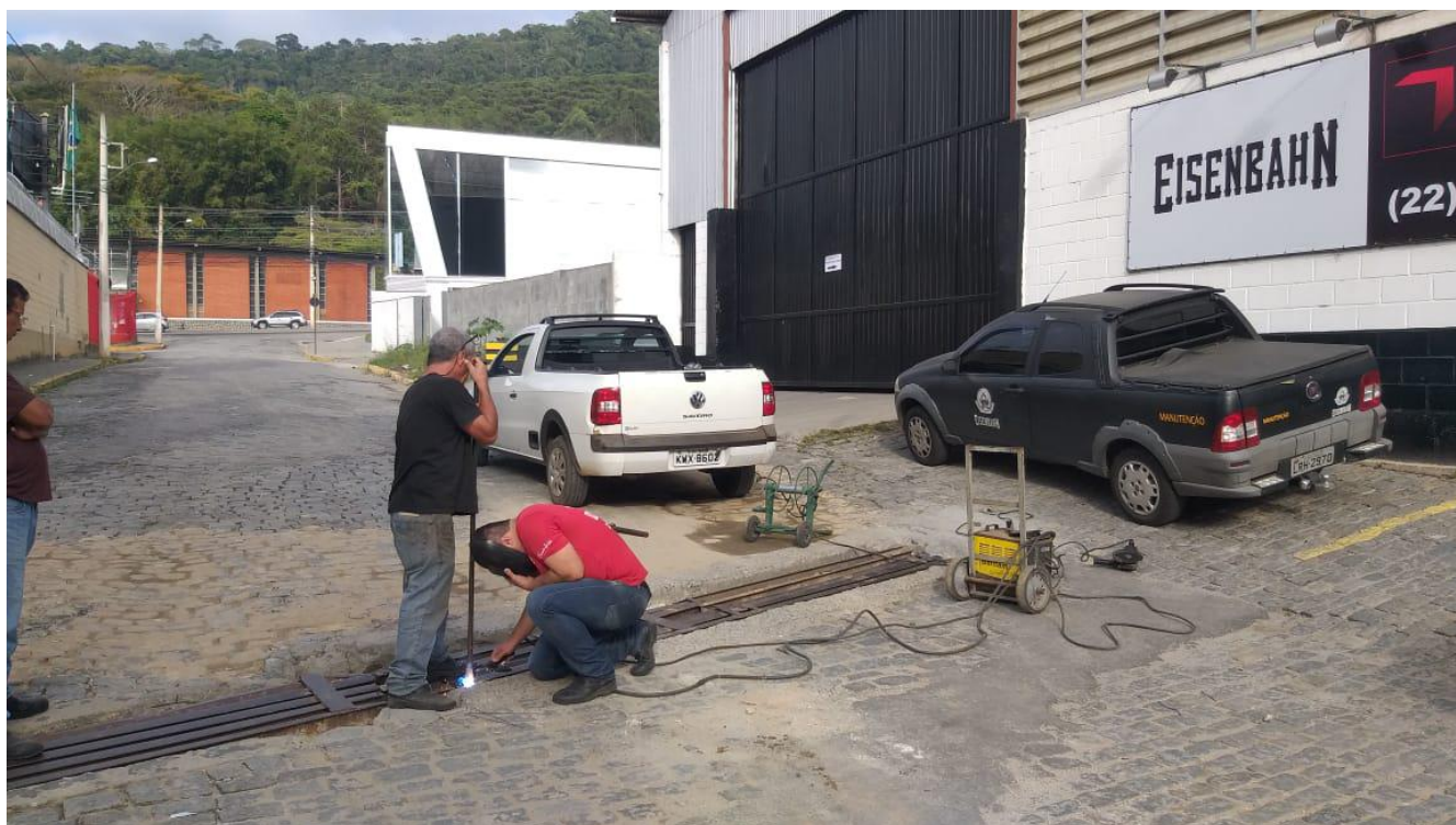
Recuperação da Grade “Mata Burro” na Rua Padre Vicente Próspero - Duas Pedras
