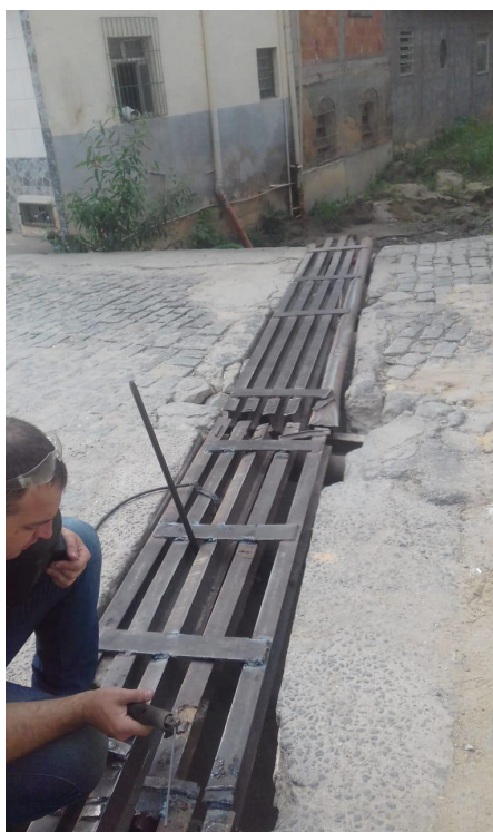
Recuperação da Grade “Mata Burro” na Rua Padre Vicente Próspero - Duas Pedras
