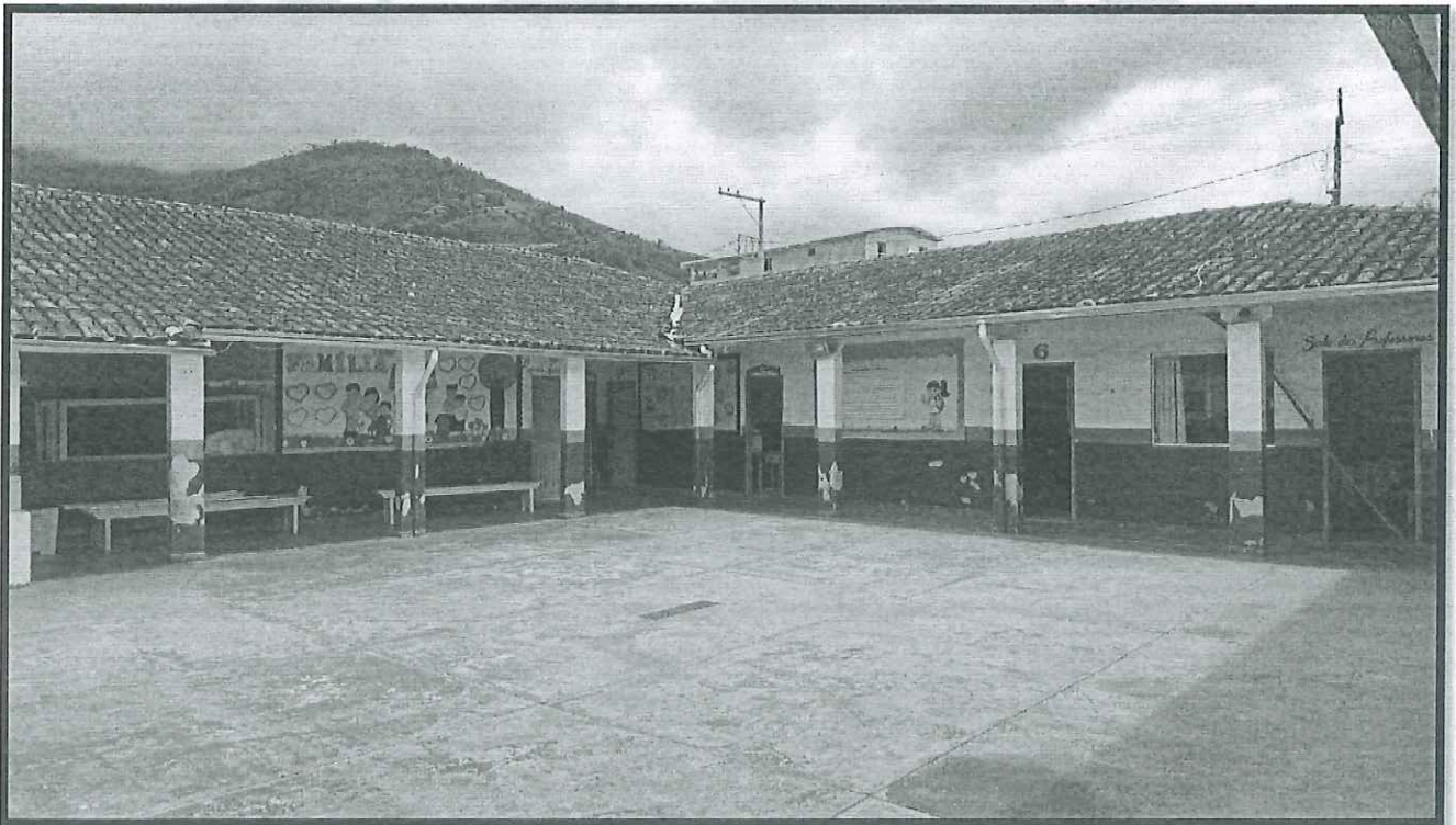
Figura 2- Escola Municipal Eni Alves Nogueira Fonte: Divisão de Meio Ambiente, 2024
