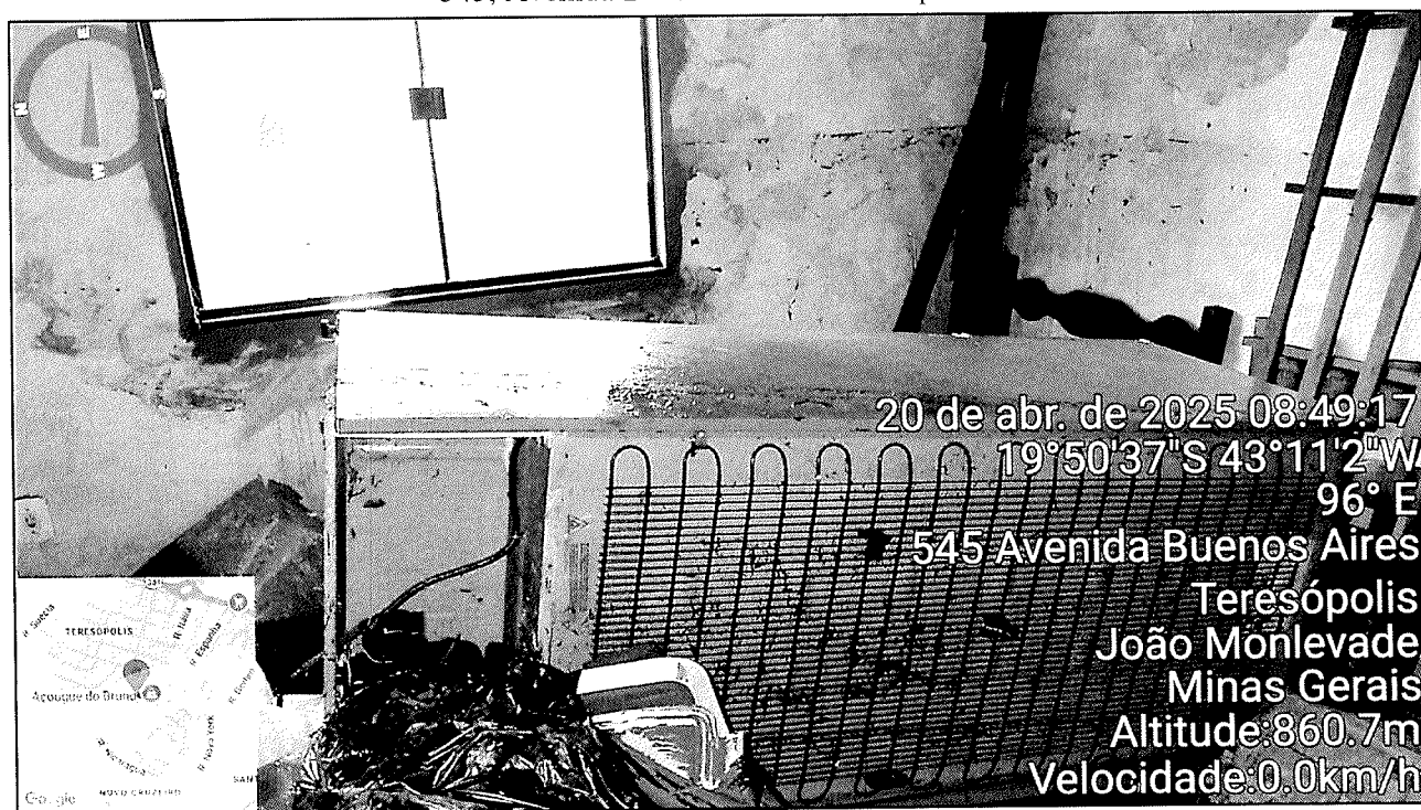
Foto 04 – Equipamento de refrigeração danificado e tombado devido à inundação ocorrida no interior da residência nº 545, Avenida Buenos Aires – Teresópolis.
