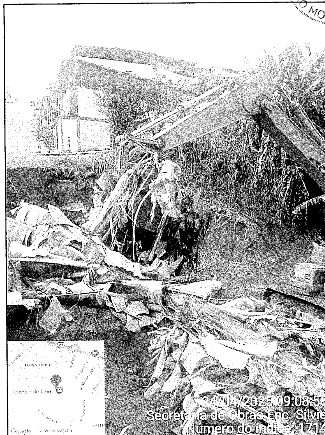
Foto 03 – Cratera com acúmulo de água na Avenida Buenos Aires, resultante do colapso da drenagem pluvial e escavações emergenciais realizadas para tentativa de desobstrução do canal.
