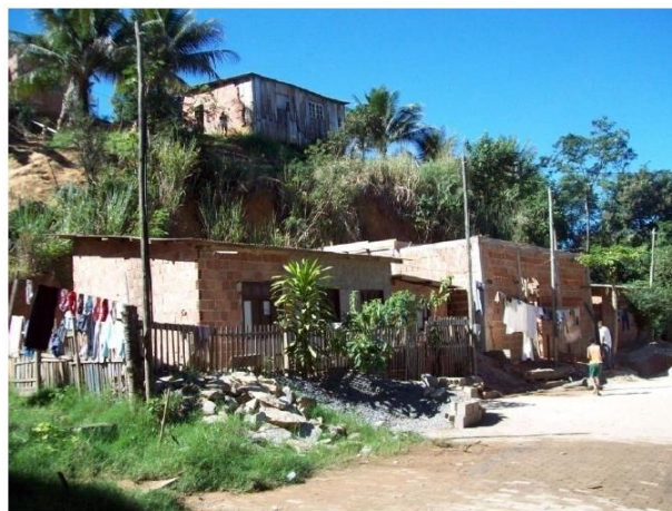
Figura 3-26 - Casas ameaçadas por outras devido ao talude mal executado. Bom Pastor, Viana-ES.
