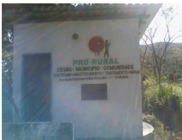
Figura 3-55 - Instalações do Pró-Rural de Perobas.
