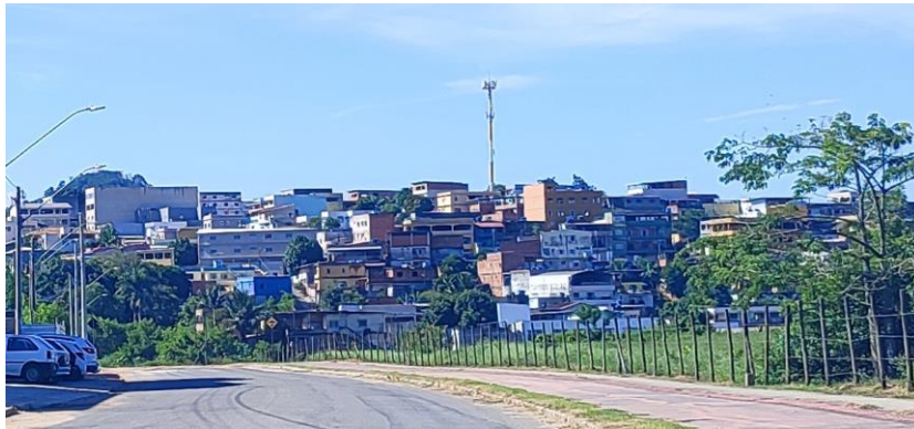
Figura 14 - Exemplo da tipologia "Residencial", com vista para Vila Bethânia.
