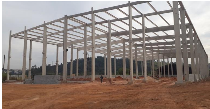
Figura 8 – Exemplo de estrutura pré-moldada a ser utilizada no galpão projetado.
