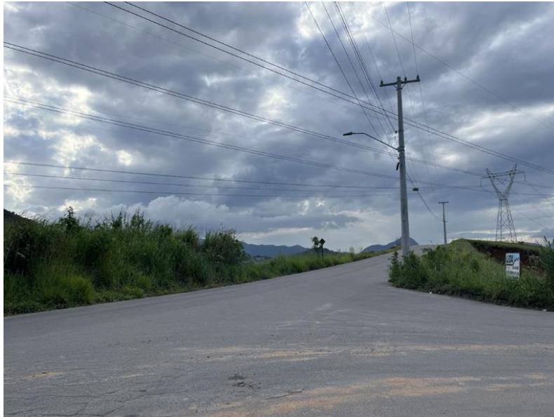
Figura 26 – Estrada de Furnas, via de acesso ao empreendimento.
