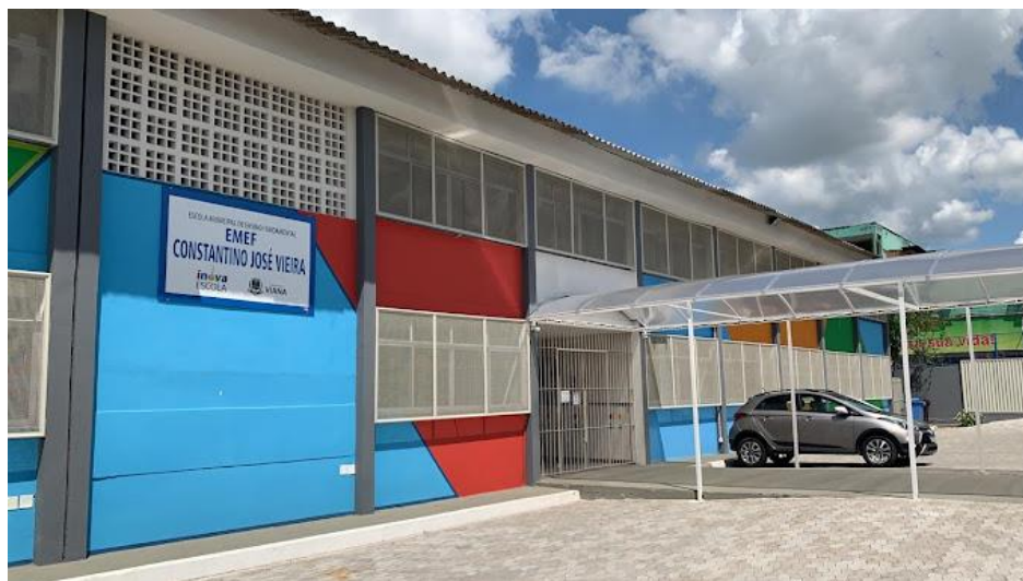
Figura 23 – EMEF Constantino José Vieira no bairro Marcílio de Noronha.
