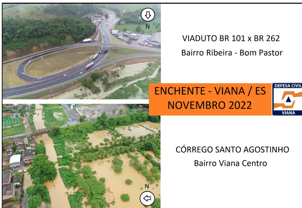
Figura 44: Imagens aéreas de Viana em decorrência das enchentes que afligiram o município no mês de novembro de 2022. Fontes: @GazetaOnline ES e PMV.
