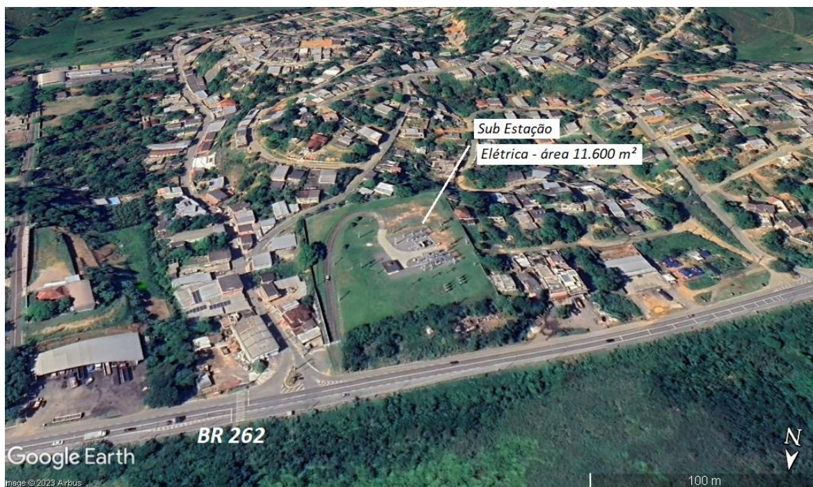
Figura 9: Sub Estação de Energia no Bairro Bom - Pastor, Viana - ES.
