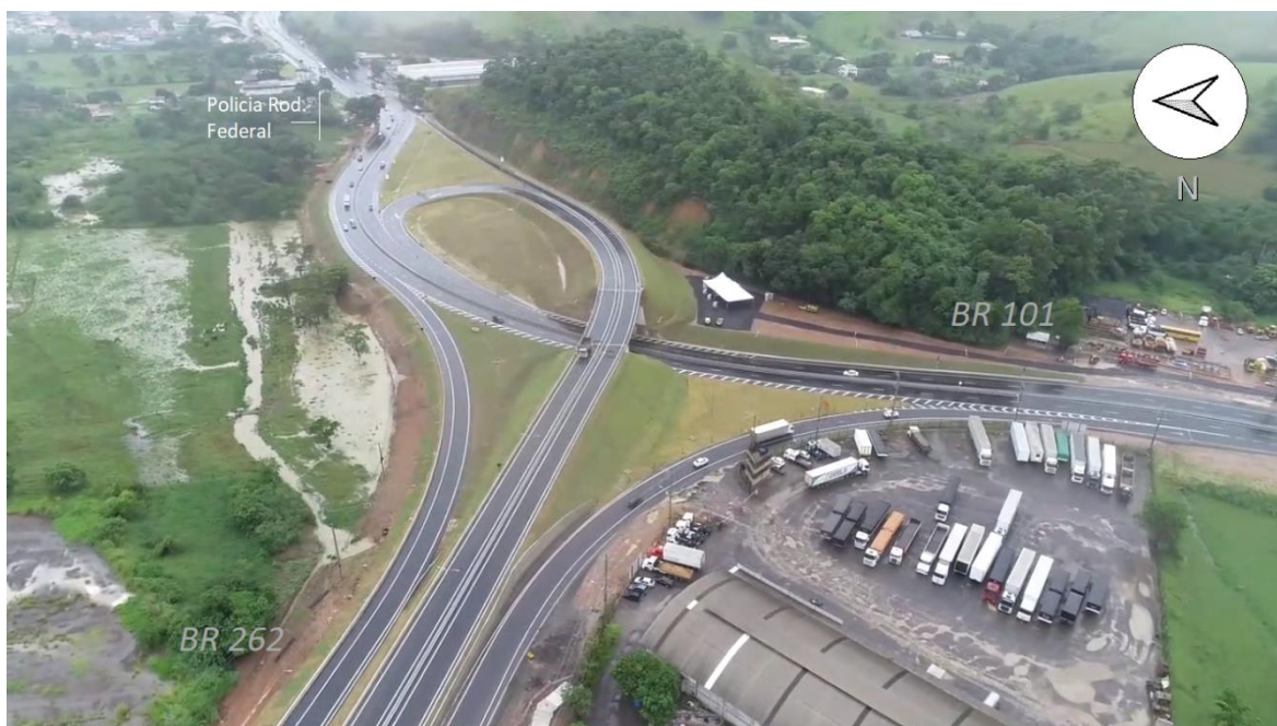
Figura 12: Imagem aérea do viaduto que liga as BRs 262 e BR 101, Viana/ES.
