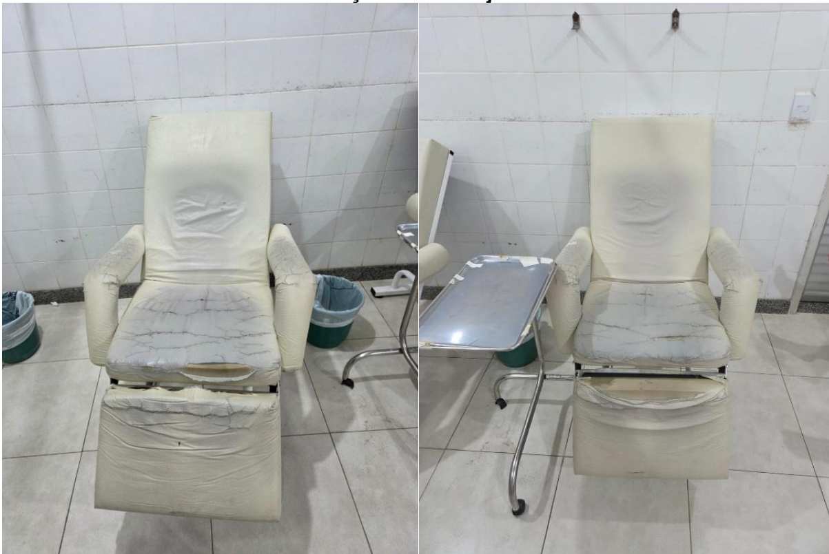
Foto 13 – Poltronas da sala de reidratação rasgadas – Cachoeiro de Itapemirim
