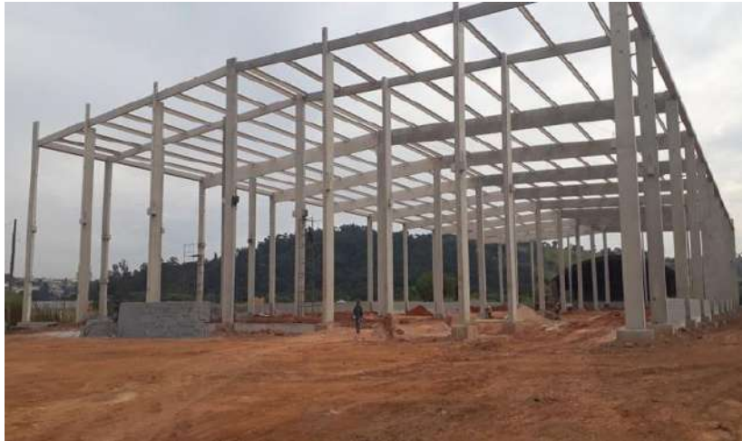
Figura 8 – Exemplo de estrutura pré-moldada a ser utilizada no galpão projetado.
