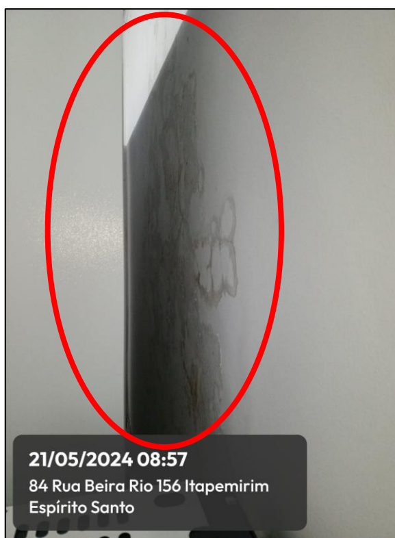
Imagem 17 – Mofo atrás da câmara de refrigeração de vacinas (Central Municipal de Itapemirim)
