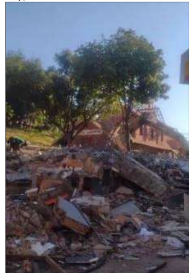
Apenas a cobertura do pátio, onde ficam as bombas permanecia no local, cercada por entulhos, no fim da tarde de ontem
