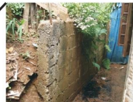
Água minando no talude
