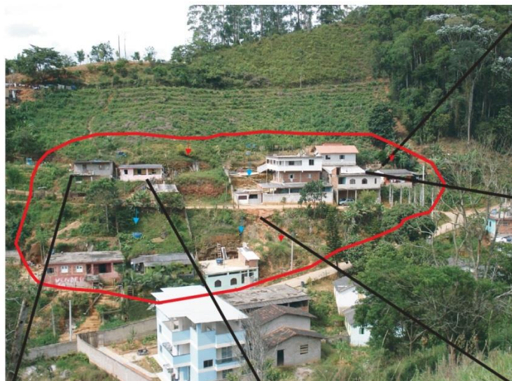
Água minando no talude
