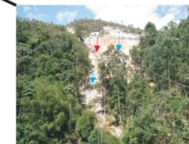
Movimentação de material na encosta, proveniente da atividade de extração (saibro) instalada no topo
