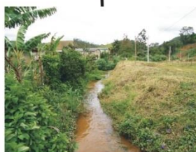
Trecho do rio onde não foi executada obra de dragagem
