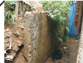
Água minando no talude
