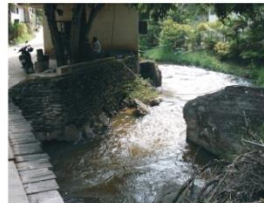
Estreitamento do rio, provocado por construção inadequada
