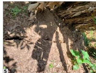
**Descrição:** Encosta de alta amplitude e declividade. Existe uma trinca no solo de grande proporção indicando que a encosta apresenta sinais de instabilidade e pode deslizar a qualquer momento.
