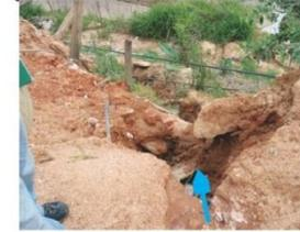
Erosão, proveniente do lançamento de aterro e da falta de drenagem na encosta
