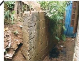
Água minando no talude
