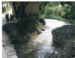
Estreitamento do rio, provocado por construção inadequada
