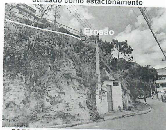
FOTO 04 – Erosão na base do pavimento, árvore caída devido à declividade do Talude de corte 02, além de diversos pontos de erosão e raízes expostas da vegetação existente no local
