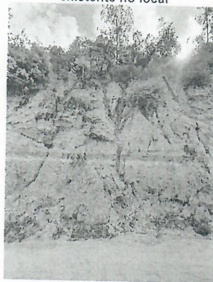
FOTO 06 – Indícios de erosão superficial na face do Talude de corte 03
