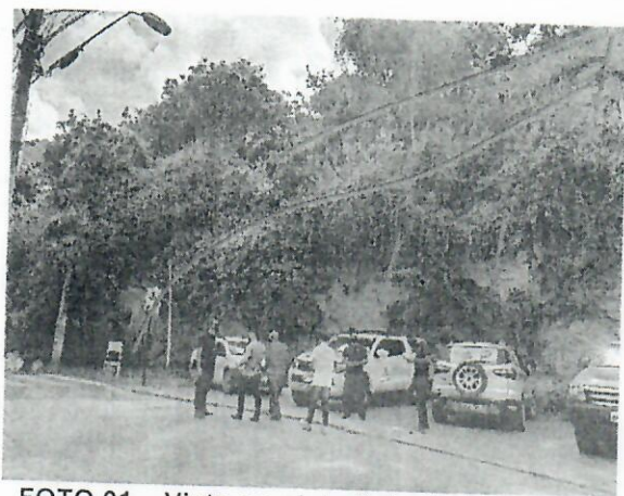
FOTO 01 – Vista geral do Talude de corte 01 que apresenta cicatrizes de escorregamentos e pontos de erosão, que deixam a inclinação do talude negativo em alguns pontos. Local utilizado como estacionamento
