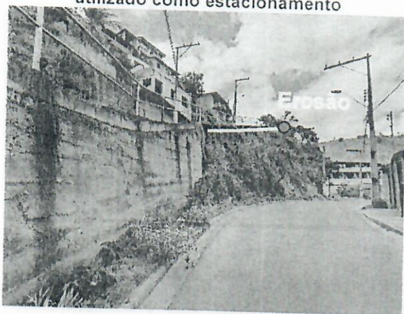
FOTO 03 – Vista do muro de contenção e Talude de corte 02 erodido
