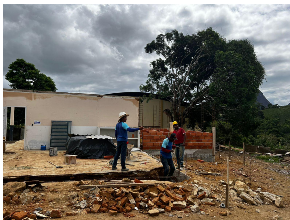
Reforma da EMUEF Ladir da Penha
