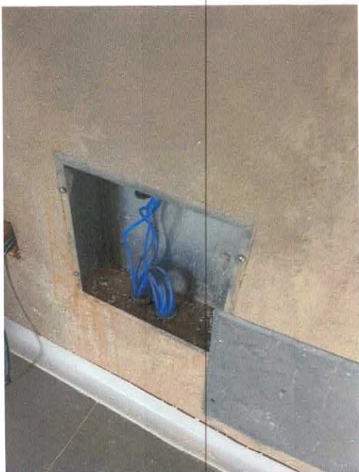
Item 16.3.6: Caixa de passagem 300x300x120mm
