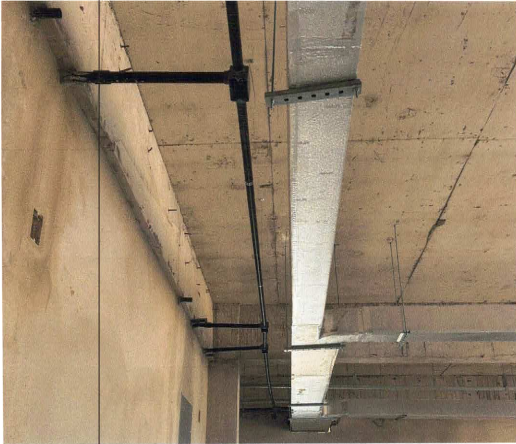
FOTO 06 – Suporte de eletroduto em fita metálica perfurada;
