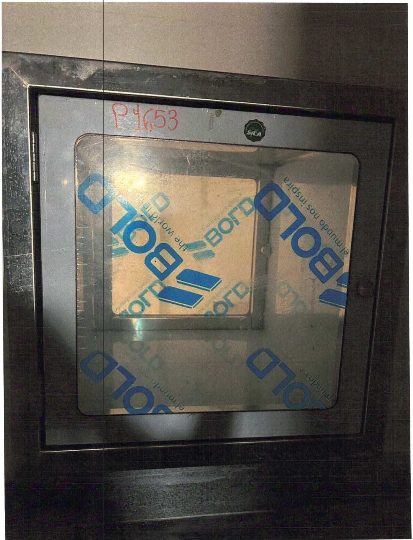
FOTO 05 – Pass through em aço inox e portas de abrir em vidro;
