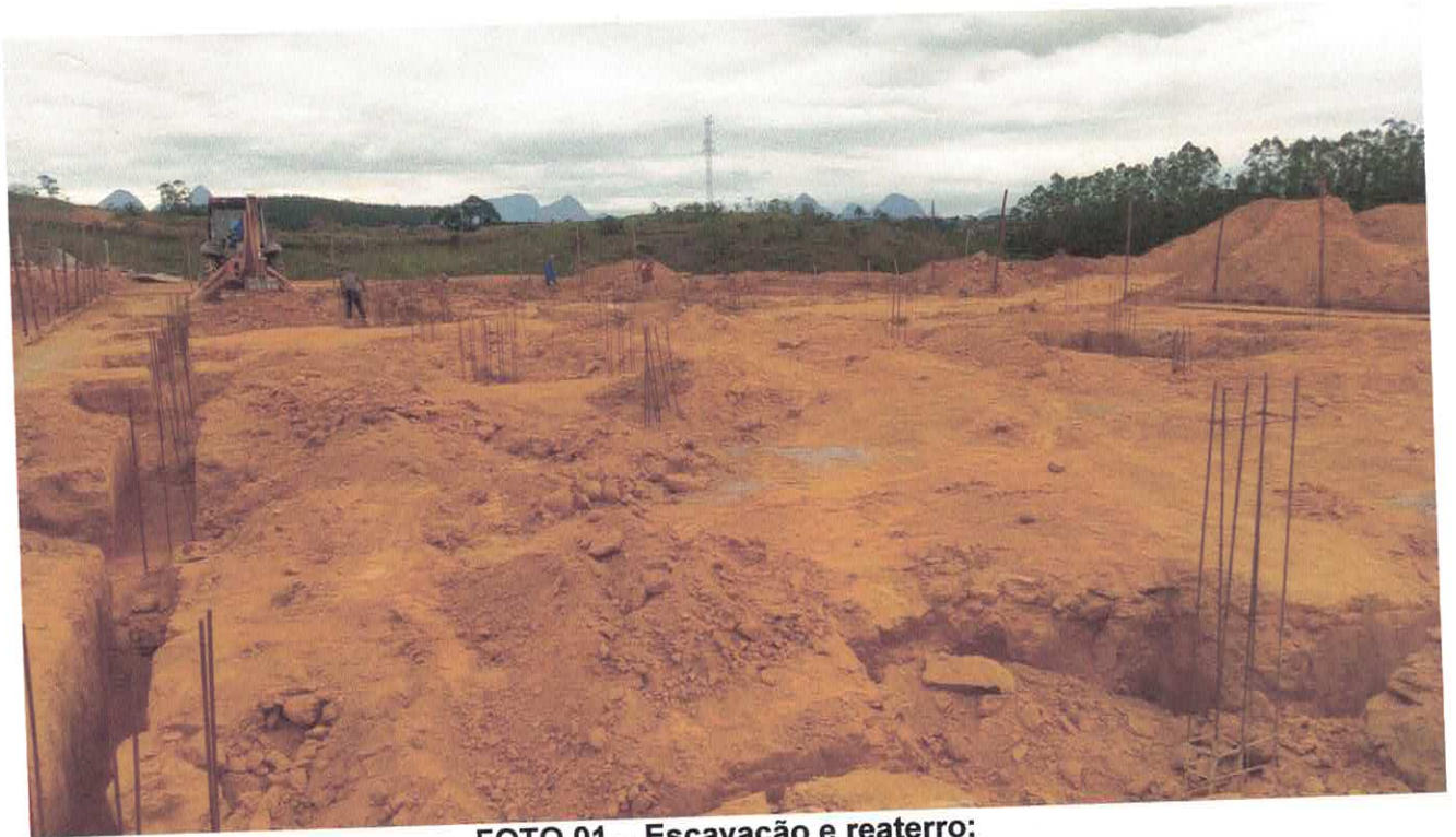
FOTO 01 – Escavação e reaterro;
