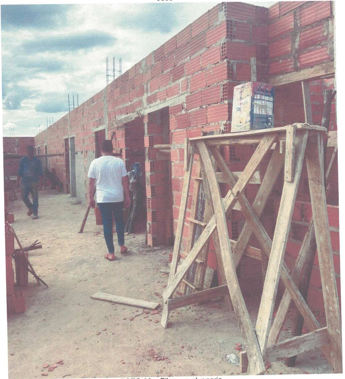
FOTO 02 – Pilares e alvenaria.
