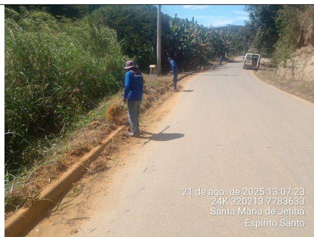
Foto 04: Serviço de roçagem e limpeza no Trecho 1
