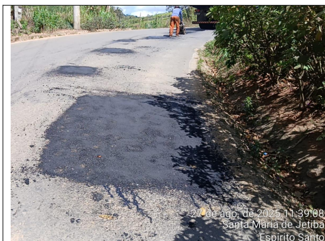
Foto 09: Serviço de tapa buraco no Trecho 5
