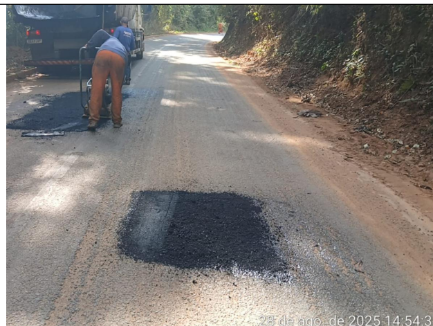
Foto 26: Serviço de tapa buraco no Trecho 3
