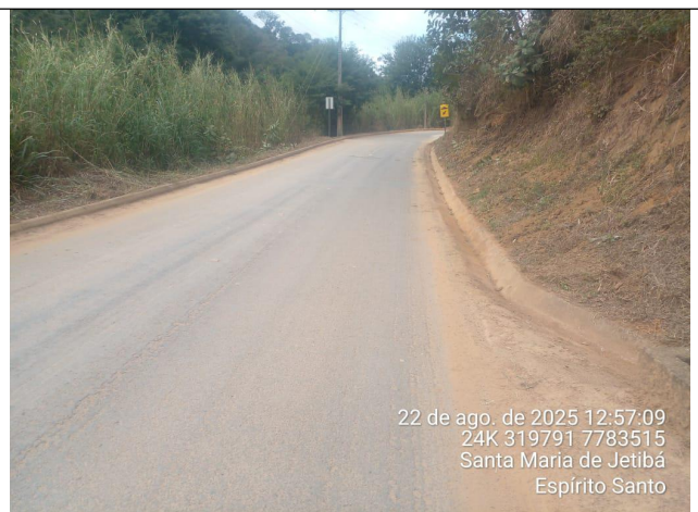
Foto 10: Serviço de roçagem e limpeza no Trecho 1
