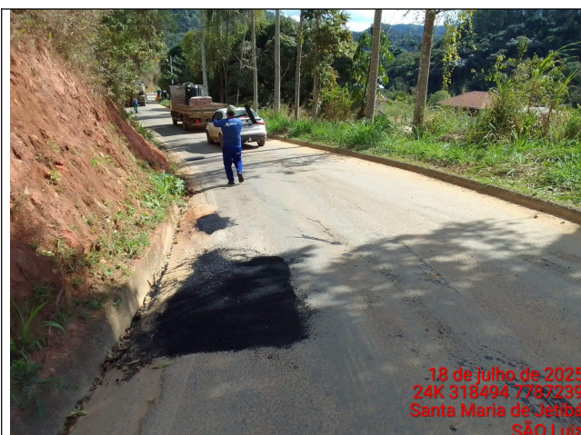
Foto 15: Serviço de tapa buraco no Trecho 11
