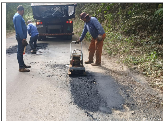
Foto 27: Serviço de tapa buraco no Trecho 3
