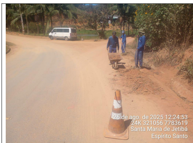
Foto 15: Serviço de roçagem e limpeza no Trecho 6
