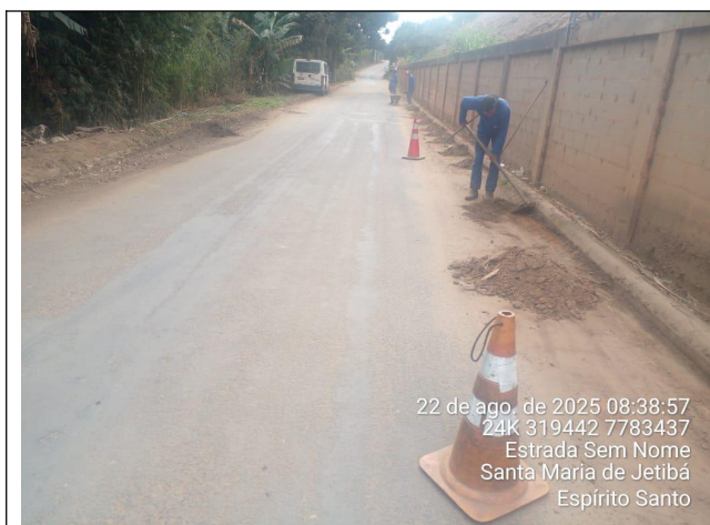
Foto 13: Serviço de roçagem e limpeza no Trecho 6
