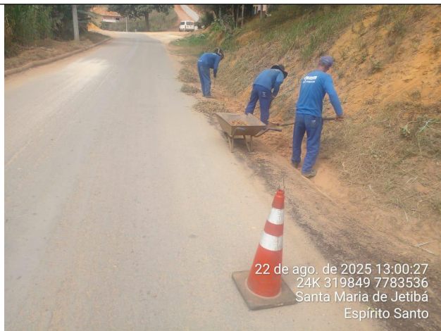
Foto 07: Serviço de roçagem e limpeza no Trecho 1
