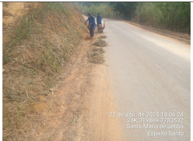
Foto 08: Serviço de roçagem e limpeza no Trecho 1
