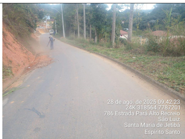
Foto 20: Serviço de roçagem e limpeza no Trecho 7
