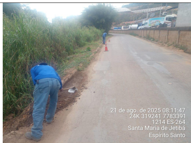
Foto 02: Serviço de roçagem e limpeza no Trecho 1
