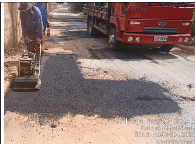
Foto 03: Serviço de tapa buraco no Trecho 1
