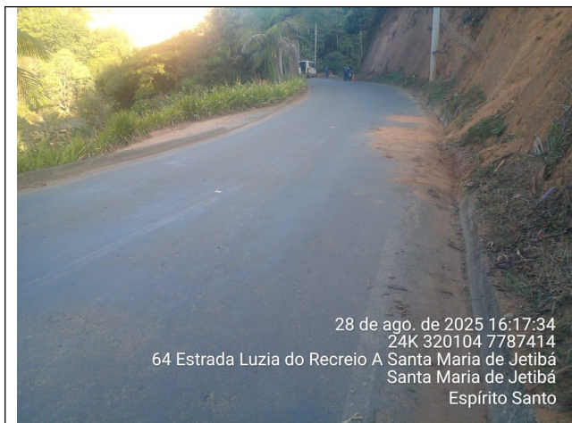
Foto 17: Serviço de roçagem e limpeza no Trecho 7
