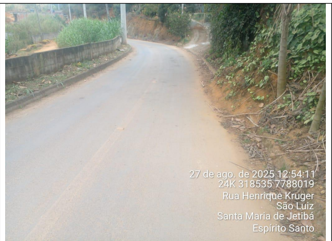
Foto 32: Serviço de roçagem e limpeza no Trecho 12
