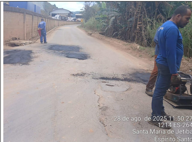
Foto 01: Serviço de tapa buraco no Trecho 1
