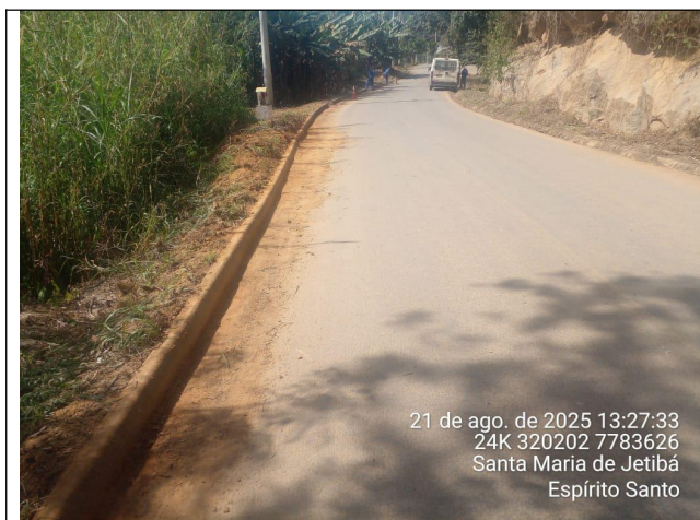
Foto 03: Serviço de roçagem e limpeza no Trecho 1
