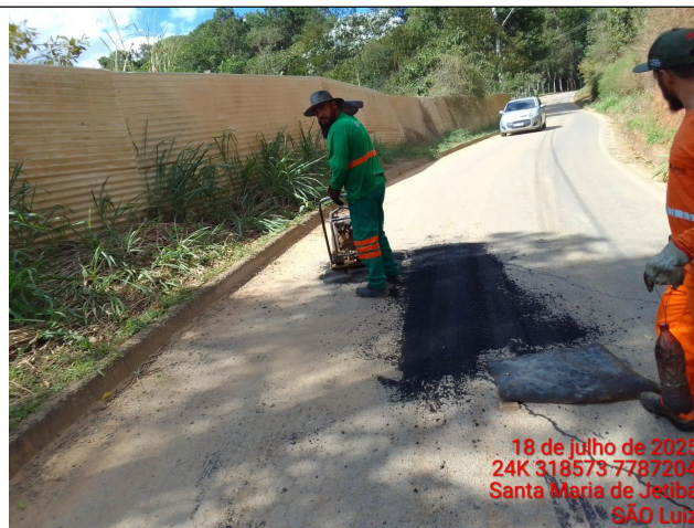
Foto 14: Serviço de tapa buraco no Trecho 11
