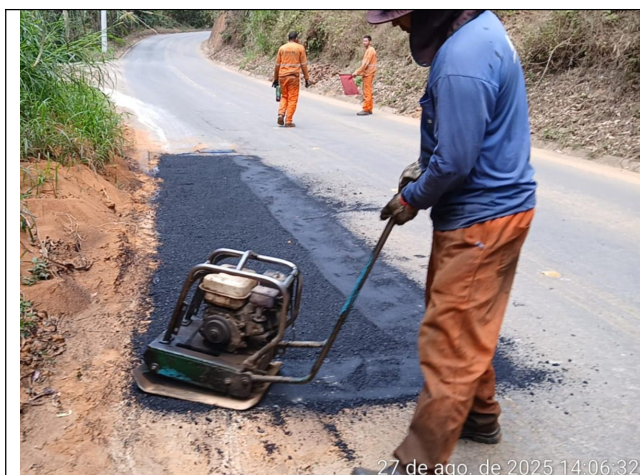
Foto 11: Serviço de tapa buraco no Trecho 5
