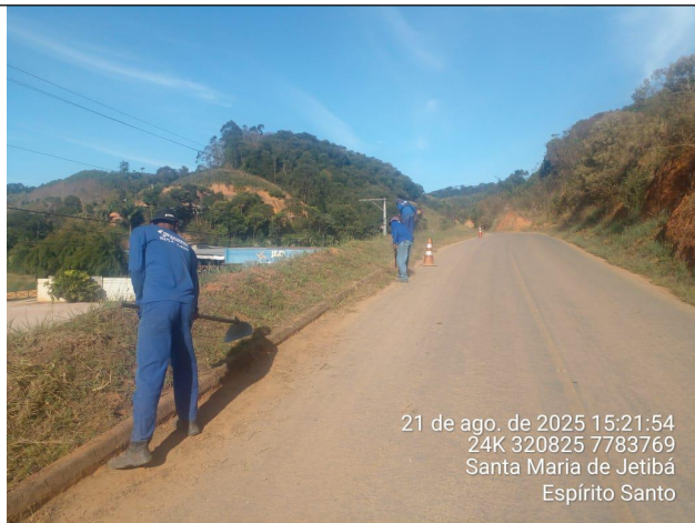
Foto 05: Serviço de roçagem e limpeza no Trecho 1
