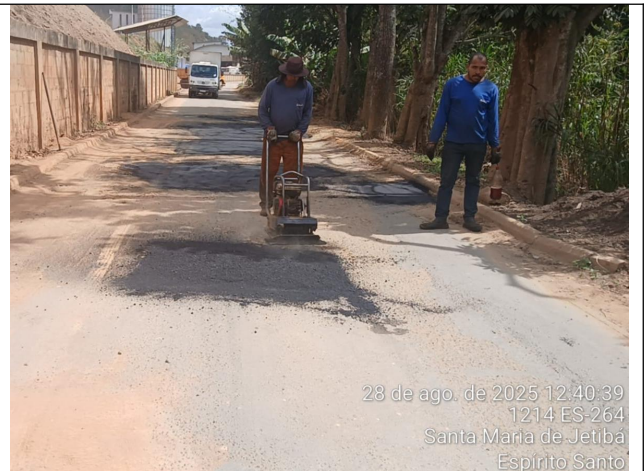
Foto 02: Serviço de tapa buraco no Trecho 1
