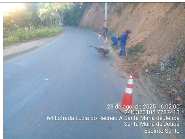
Foto 18: Serviço de roçagem e limpeza no Trecho 7
