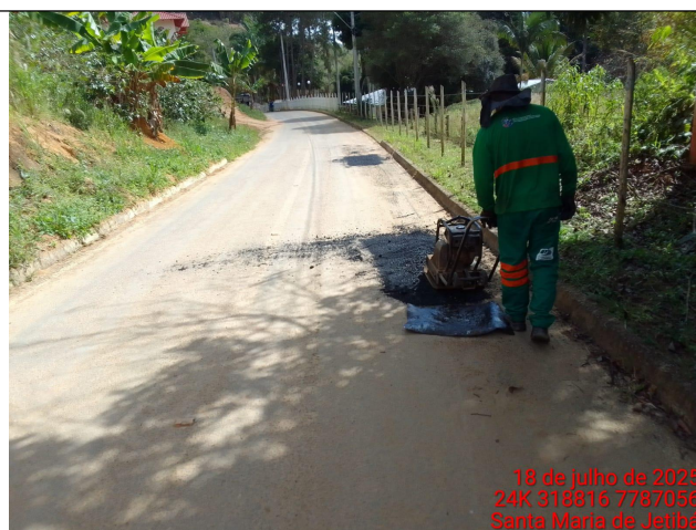
Foto 16: Serviço de tapa buraco no Trecho 11
