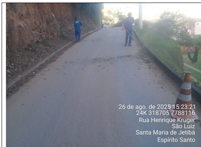
Foto 27: Serviço de roçagem e limpeza no Trecho 12
