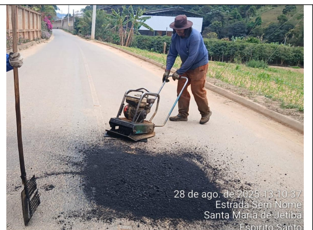
Foto 06: Serviço de tapa buraco no Trecho 1
