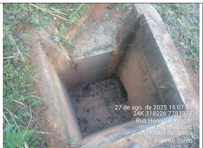
Foto 34: Serviço de roçagem e limpeza no Trecho 12
