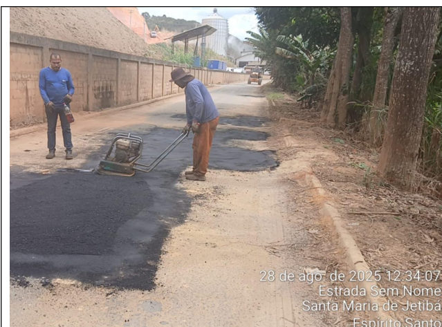
Foto 05: Serviço de tapa buraco no Trecho 1
