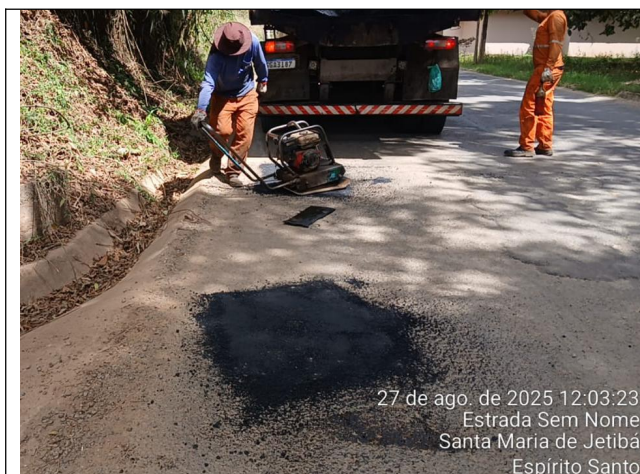
Foto 07: Serviço de tapa buraco no Trecho 5
