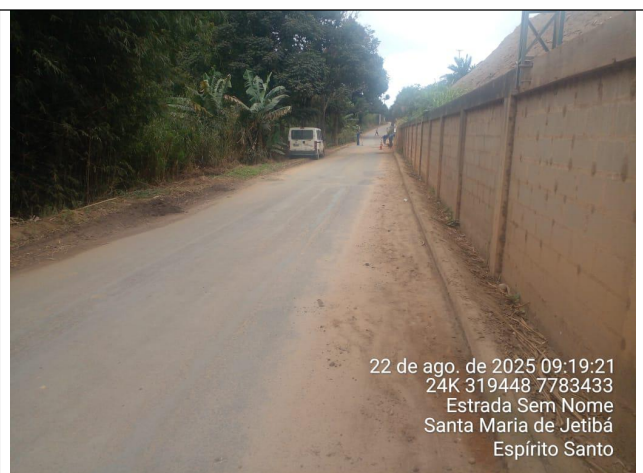
Foto 14: Serviço de roçagem e limpeza no Trecho 6
