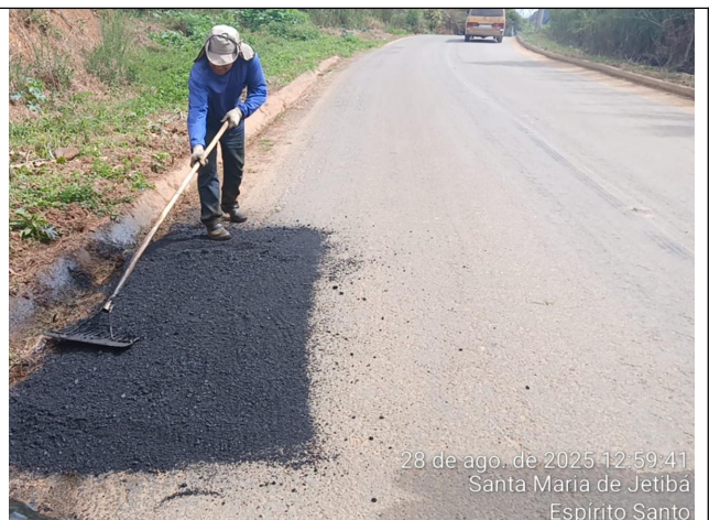
Foto 04: Serviço de tapa buraco no Trecho 1
