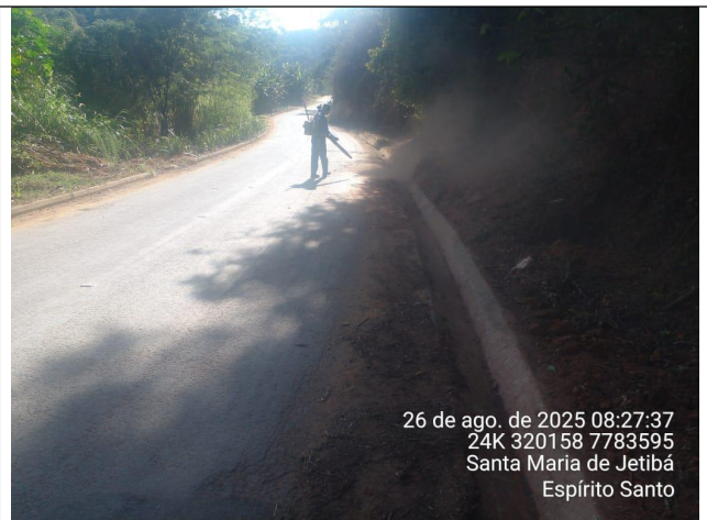
Foto 12: Serviço de roçagem e limpeza no Trecho 6
