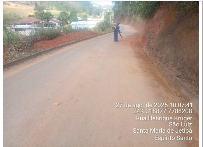
Foto 30: Serviço de roçagem e limpeza no Trecho 12
