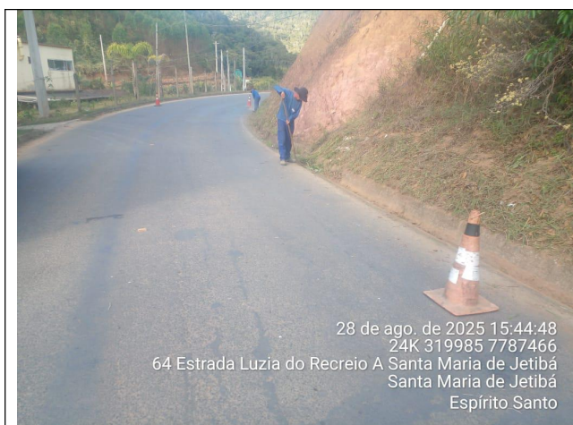
Foto 19: Serviço de roçagem e limpeza no Trecho 7
