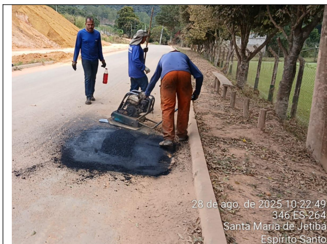
Foto 19: Serviço de tapa buraco no Trecho 8
