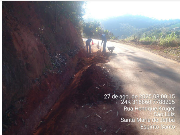
Foto 29: Serviço de roçagem e limpeza no Trecho 12
