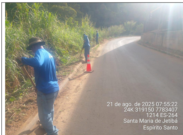
Foto 01: Serviço de roçagem e limpeza no Trecho 1
