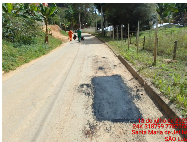
Foto 18: Serviço de tapa buraco no Trecho 11
