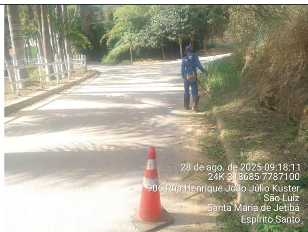
Foto 24: Serviço de roçagem e limpeza no Trecho 10
