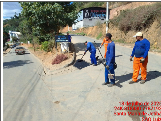
Foto 13: Serviço de tapa buraco no Trecho 11
