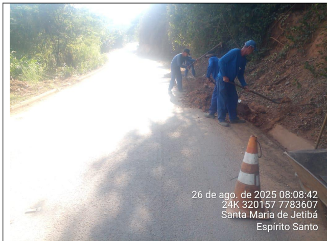
Foto 11: Serviço de roçagem e limpeza no Trecho 6
