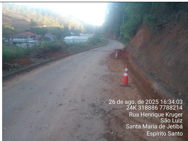
Foto 31: Serviço de roçagem e limpeza no Trecho 12
