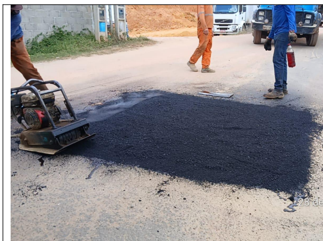
Foto 21: Serviço de tapa buraco no Trecho 8
