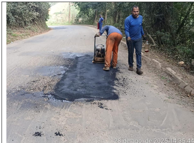
Foto 25: Serviço de tapa buraco no Trecho 3
