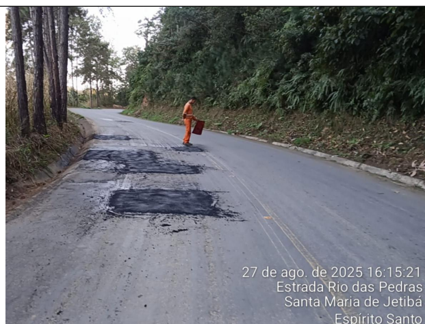
Foto 08: Serviço de tapa buraco no Trecho 5
