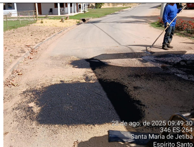
Foto 22: Serviço de tapa buraco no Trecho 8
