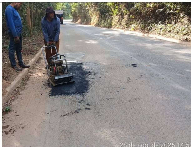
Foto 32: Serviço de tapa buraco no Trecho 3
