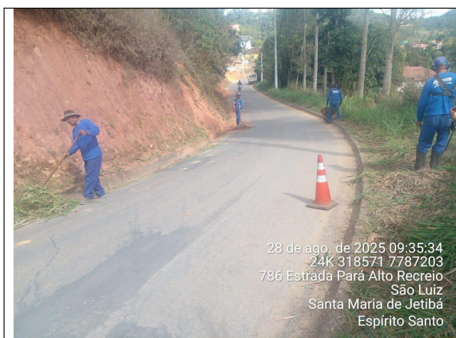
Foto 21: Serviço de roçagem e limpeza no Trecho 7
