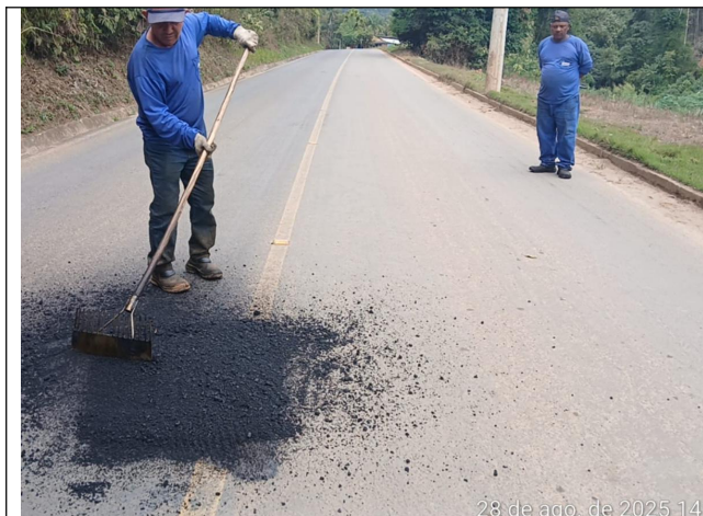
Foto 31: Serviço de tapa buraco no Trecho 3
