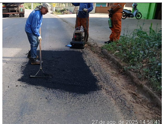
Foto 10: Serviço de tapa buraco no Trecho 5
