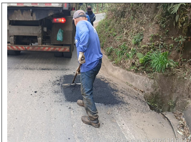
Foto 29: Serviço de tapa buraco no Trecho 3
