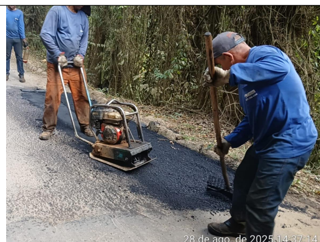
Foto 28: Serviço de tapa buraco no Trecho 3
