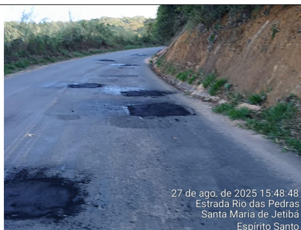
Foto 12: Serviço de tapa buraco no Trecho 5
