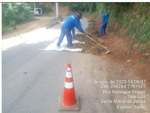
Foto 33: Serviço de roçagem e limpeza no Trecho 12
