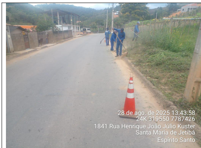
Foto 23: Serviço de roçagem e limpeza no Trecho 10
