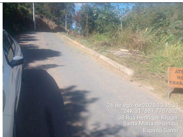
Foto 28: Serviço de roçagem e limpeza no Trecho 12
