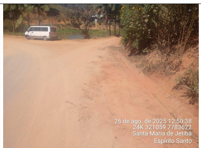
Foto 16: Serviço de roçagem e limpeza no Trecho 6
