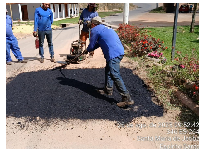
Foto 23: Serviço de tapa buraco no Trecho 8
