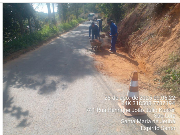
Foto 26: Serviço de roçagem e limpeza no Trecho 10
