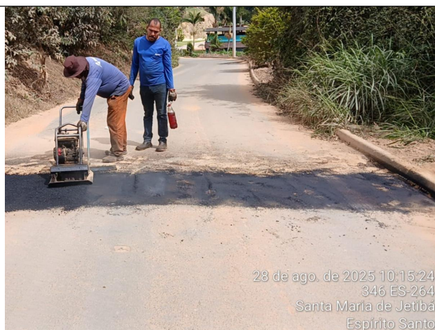
Foto 20: Serviço de tapa buraco no Trecho 8
