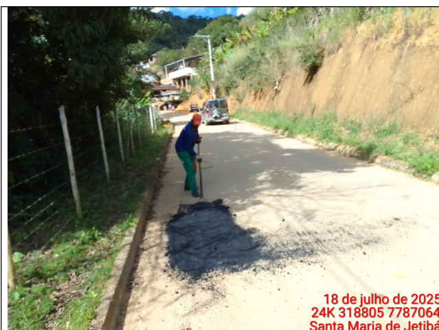
Foto 17: Serviço de tapa buraco no Trecho 11
