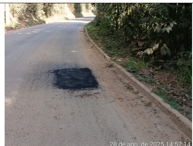
Foto 30: Serviço de tapa buraco no Trecho 3
