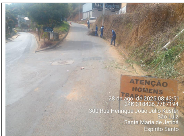
Foto 25: Serviço de roçagem e limpeza no Trecho 10
