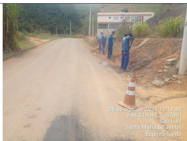
Foto 22: Serviço de roçagem e limpeza no Trecho 7
