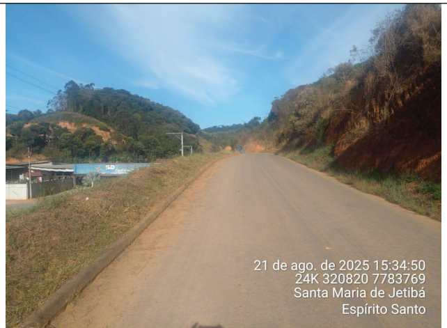
Foto 06: Serviço de roçagem e limpeza no Trecho 1
