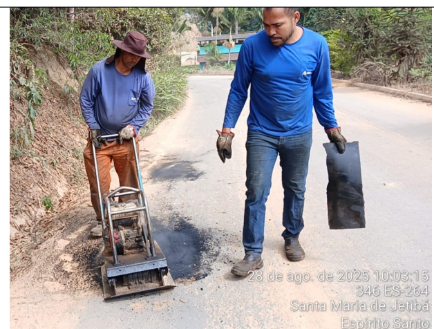
Foto 24: Serviço de tapa buraco no Trecho 8
