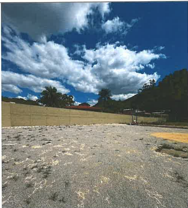
Foto 15 - Muro novo / Pintura Muro
