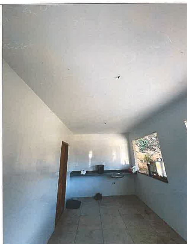
Foto 02 - Forro de gesso
