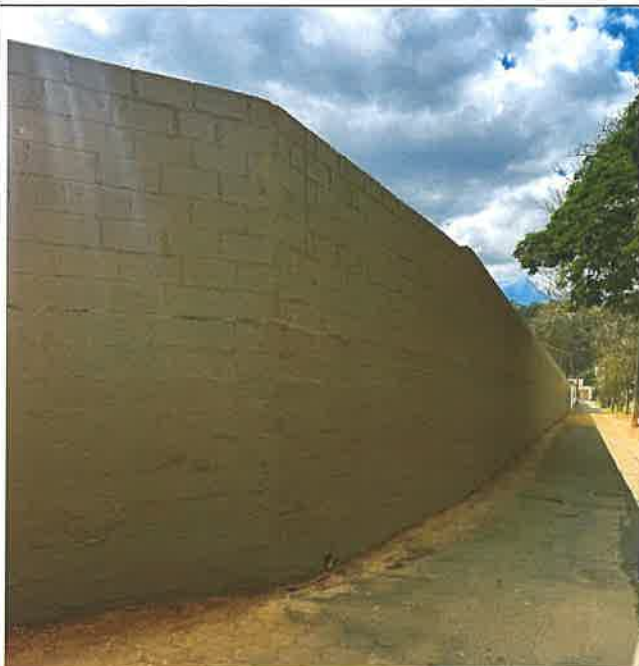
Foto 13 - Aumento do muro / Pintura do muro
