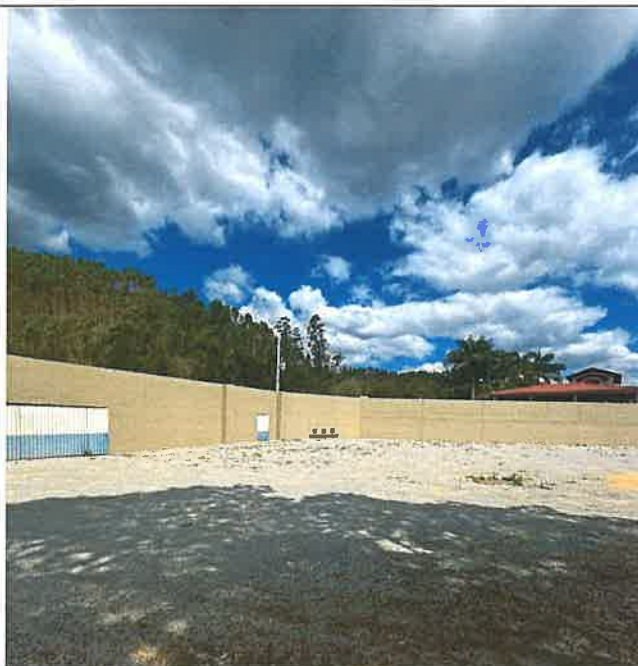
Foto 14 - Aumento do muro / Pintura do muro
