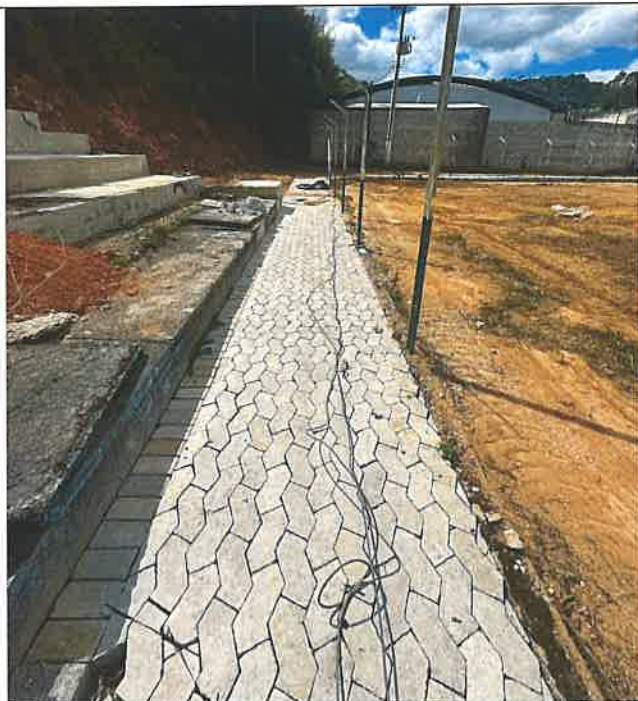
Foto 19 - Pavimentação de blocos pré-moldados e Meio-fio
