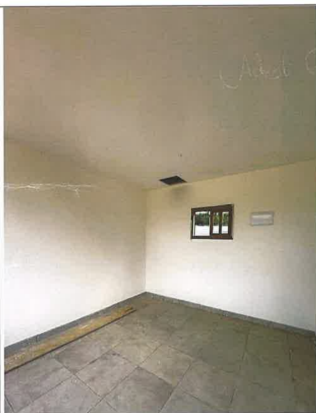
Foto 01 - Emassamento de paredes e forro de gesso
