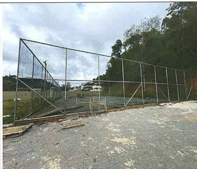
Foto 25 - Remoção de pintura antiga, retirada de grama sintética
