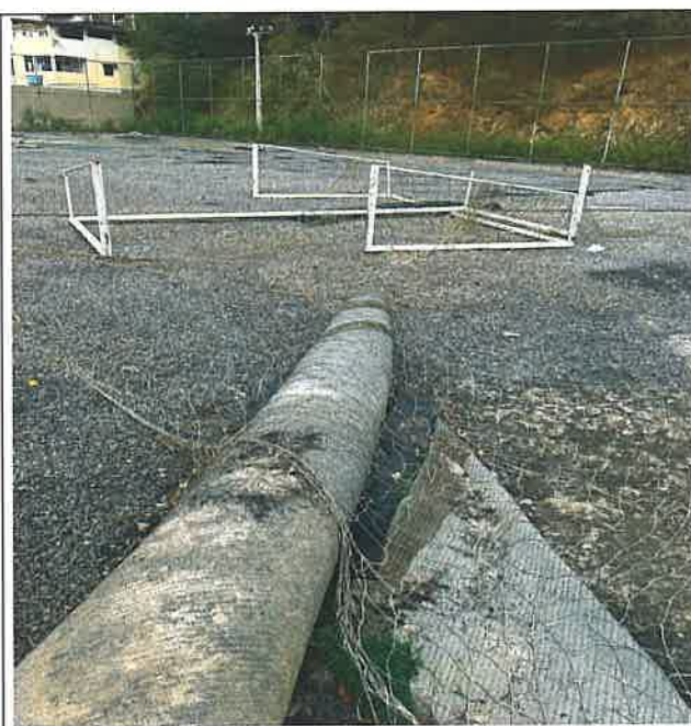
Foto 22 - Remoção de pintura antiga, retirada de grama sintética
