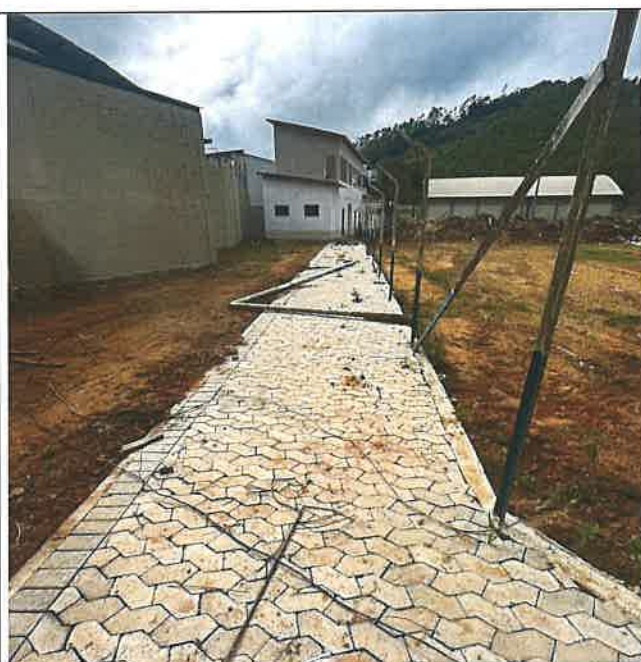
Foto 17 - Pavimentação de blocos pré-moldados e Meio-fio
