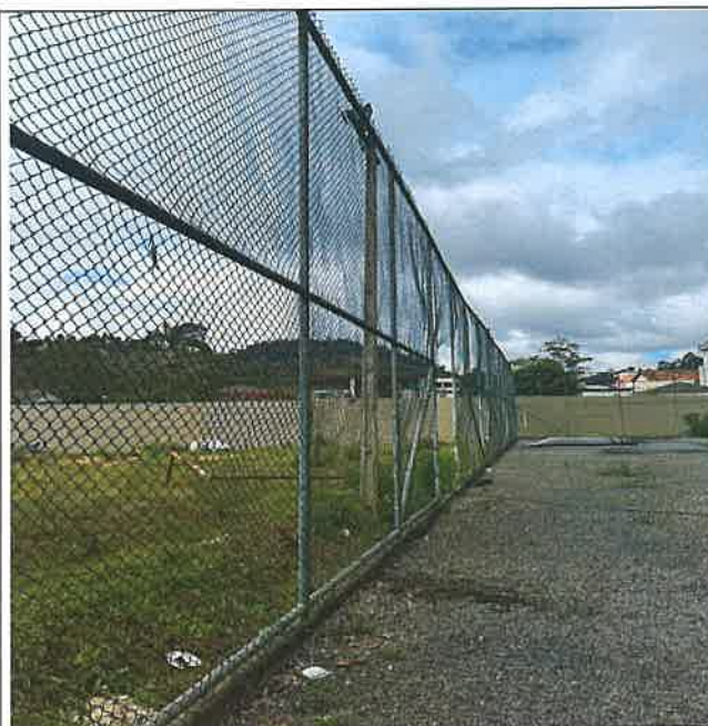
Foto 21 - Remoção de pintura antiga, retirada de grama sintética
