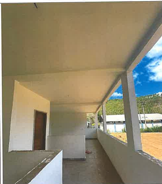
Foto 04 - Emassamento de paredes e forro de gesso
