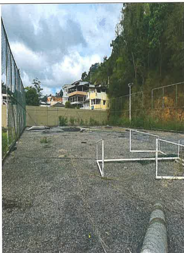
Foto 24 - Remoção de pintura antiga, retirada de grama sintética
