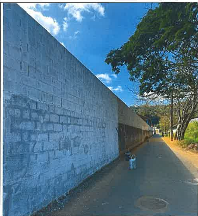
Foto 09 - Aumento do muro / Pintura do muro
