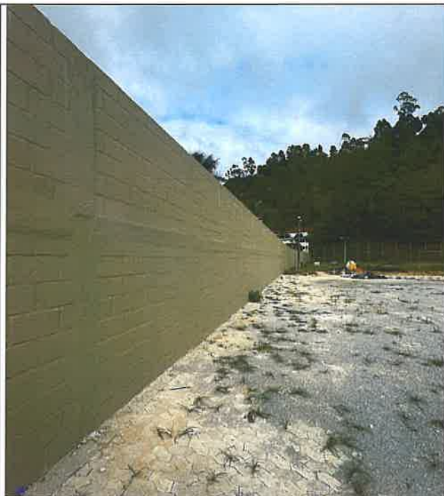
Foto 11 - Aumento do muro / Pintura do muro
