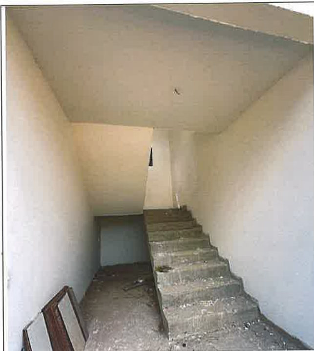
Foto 03 - Emassamento de paredes e forro de gesso
