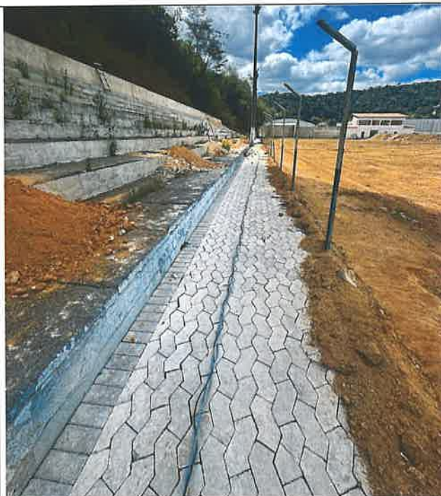
Foto 20 - Pavimentação de blocos pré-moldados e Meio-fio
