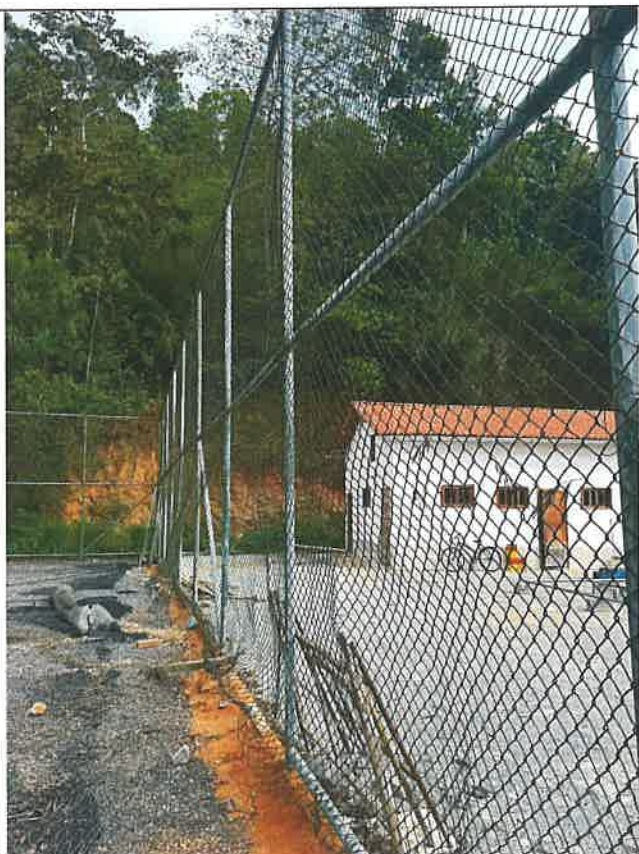
Foto 23 - Remoção de pintura antiga, retirada de grama sintética
