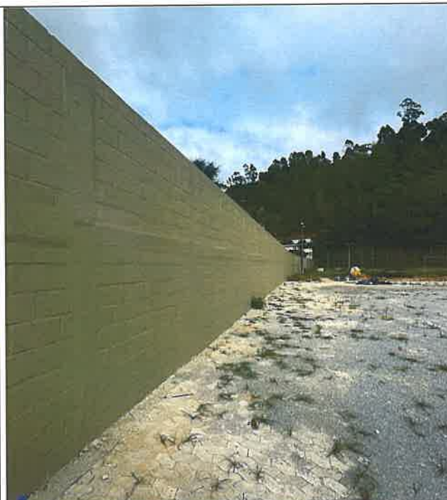
Foto 16 - Muro novo / Pintura Muro
