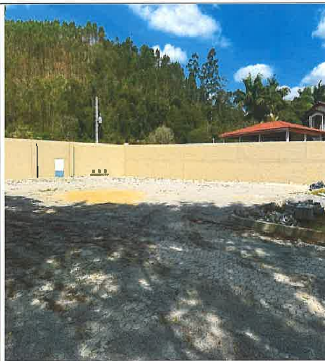
Foto 10 - Aumento do muro / Pintura do muro
