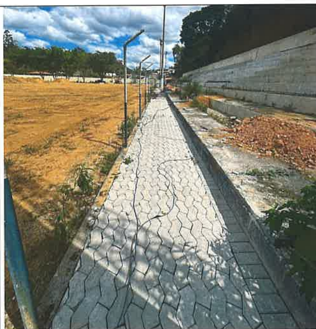
Foto 18 - Pavimentação de blocos pré-moldados e meio-fio
