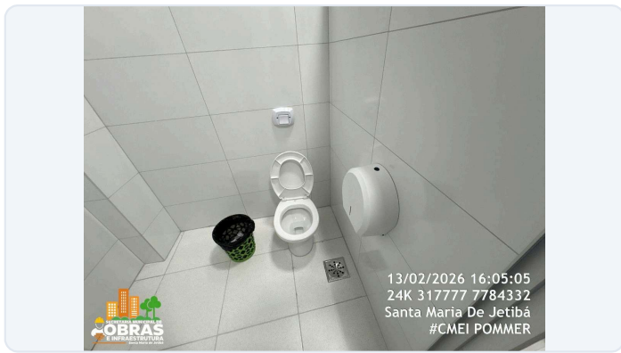
FOTO 49: ITEM 18.13 E 18.14 DA PLANILHA - FORNECIMENTO E INSTALAÇÃO DE SABONETEIRAS E PAPELEIRAS, VALVULAS DE DESCARGA E TAMPA DE RALO INOX
