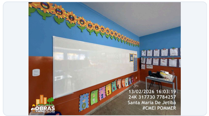
FOTO 8: ITEM 4.8 DA PLANILHA - QUADRO BRANCO PINCEL NOVO INSTALADO.
