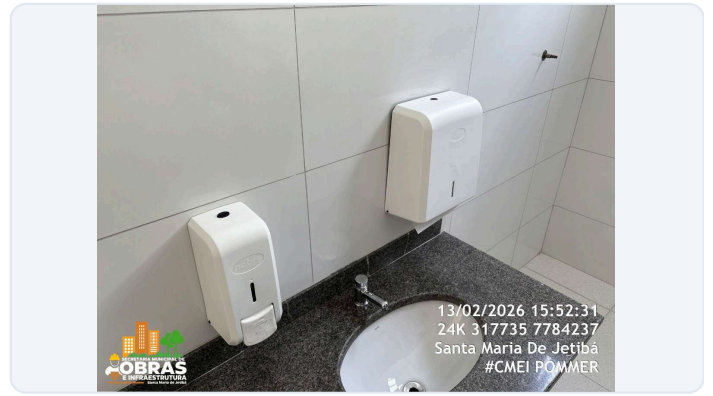
FOTO 42: ITEM 18.13 E 18.14 DA PLANILHA - FORNECIMENTO E INSTALAÇÃO DE SABONETEIRAS E PAPELEIRAS
