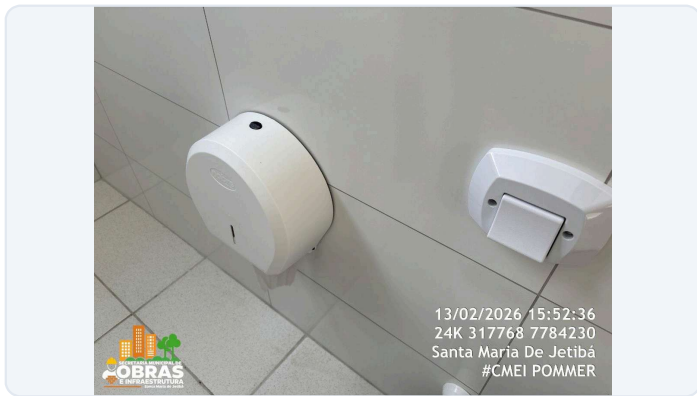
FOTO 43: ITEM 18.13 E 18.14 DA PLANILHA - FORNECIMENTO E INSTALAÇÃO DE SABONETEIRAS E PAPELEIRAS E VÁLVULA DE DESCARAGA
