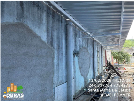
FOTO 25: ITEM 14.2, 18.20 E 18.21 DA PLANILHA - EXECUÇÃO DE COBERTURA COM PERFIS METÁLICOS , TRAMAS DE AÇO E TELHAS DE ALUMINIO TRAPEZOIDAL.
