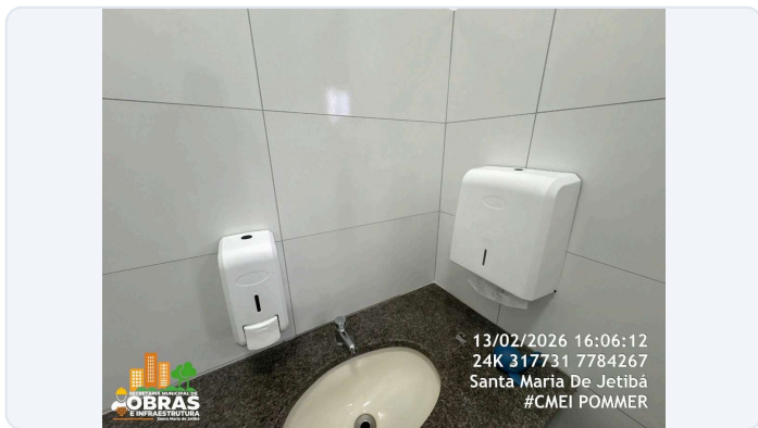
FOTO 51: ITEM 18.13 E 18.14 DA PLANILHA - FORNECIMENTO E INSTALAÇÃO DE SABONETEIRAS E PAPELEIRAS
