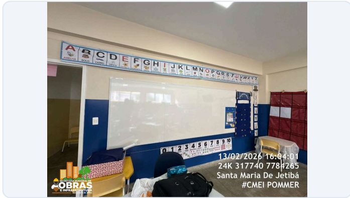
FOTO 9: ITEM 4.8 DA PLANILHA - QUADRO BRANCO PINCEL NOVO INSTALADO.
