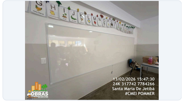
FOTO 2: ITEM 4.8 DA PLANILHA - QUADRO BRANCO PINCEL NOVO INSTALADO.
