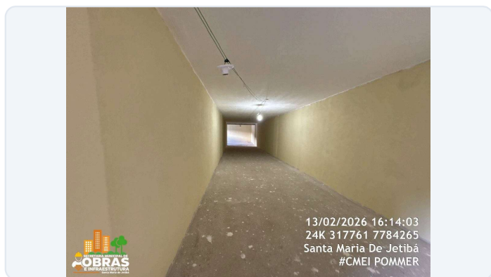
FOTO 60: ITEM 12.0 DA PLANILHA - PINTURA INTERNA E EXTERNA DA ÁREA DA RAMPA NOVA.
