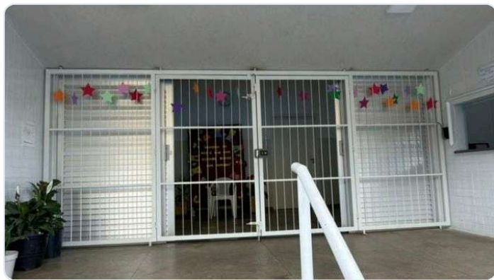
FOTO 17: ITEM 6.0 DA PLANILHA - INSTALAÇÃO E PINTURA DE ESMALTE SINTÉTICO DO ESQUADRIAS METÁLICAS, GRADES E PORTÕES.
