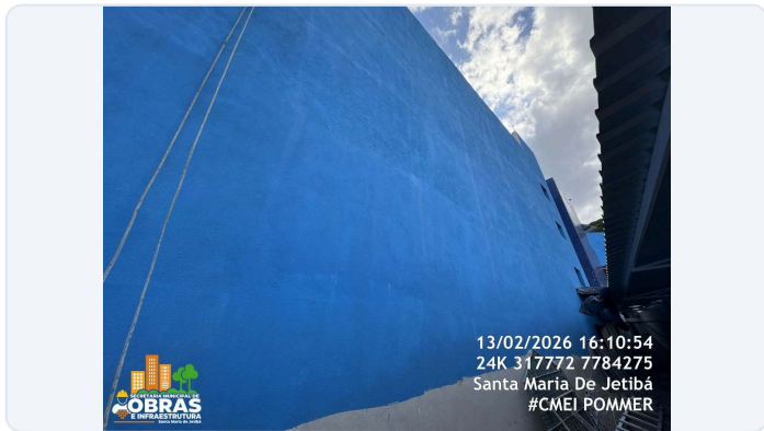
FOTO 53: ITEM 12.0 DA PLANILHA - PINTURA INTERNA E EXTERNA DA ÁREA DA RAMPA NOVA.
