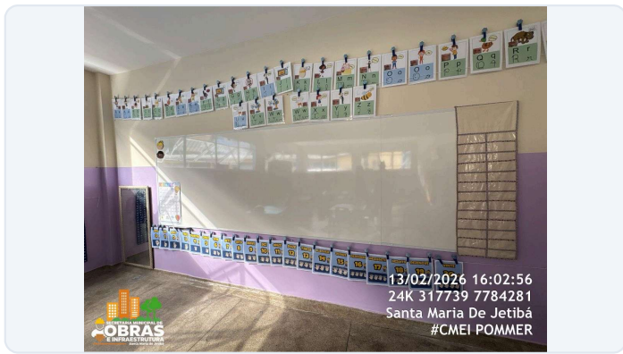
FOTO 7: ITEM 4.8 DA PLANILHA - QUADRO BRANCO PINCEL NOVO INSTALADO.
