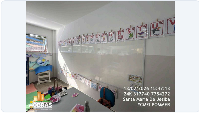
FOTO 1: ITEM 4.8 DA PLANILHA - QUADRO BRANCO PINCEL NOVO INSTALADO.
