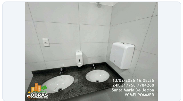
FOTO 52: ITEM 18.13 E 18.14 DA PLANILHA - FORNECIMENTO E INSTALAÇÃO DE SABONETEIRAS E PAPELEIRAS
