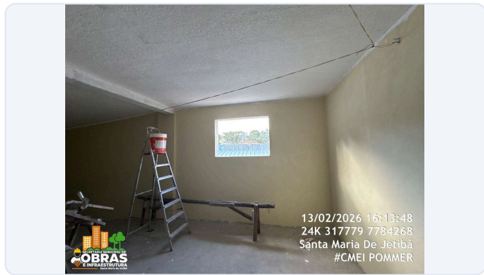
FOTO 58: ITEM 12.0 DA PLANILHA - PINTURA INTERNA E EXTERNA DA ÁREA DA RAMPA NOVA.
