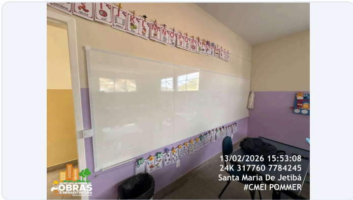
FOTO 3: ITEM 4.8 DA PLANILHA - QUADRO BRANCO PINCEL NOVO INSTALADO.
