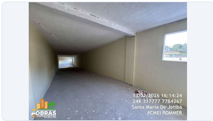
FOTO 63: ITEM 12.0 DA PLANILHA - PINTURA INTERNA E EXTERNA DA ÁREA DA RAMPA NOVA.
