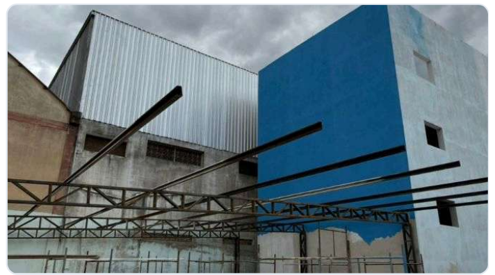
FOTO 64: ITEM 12.0 DA PLANILHA - PINTURA INTERNA E EXTERNA DA ÁREA DA RAMPA NOVA.
