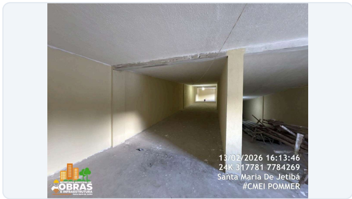
FOTO 57: ITEM 12.0 DA PLANILHA - PINTURA INTERNA E EXTERNA DA ÁREA DA RAMPA NOVA.
