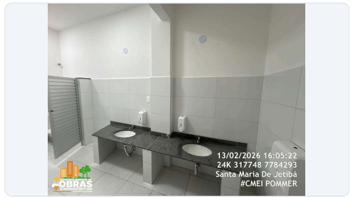
FOTO 50: ITEM 18.13 E 18.14 DA PLANILHA - FORNECIMENTO E INSTALAÇÃO DE SABONETEIRAS E PAPELEIRAS
