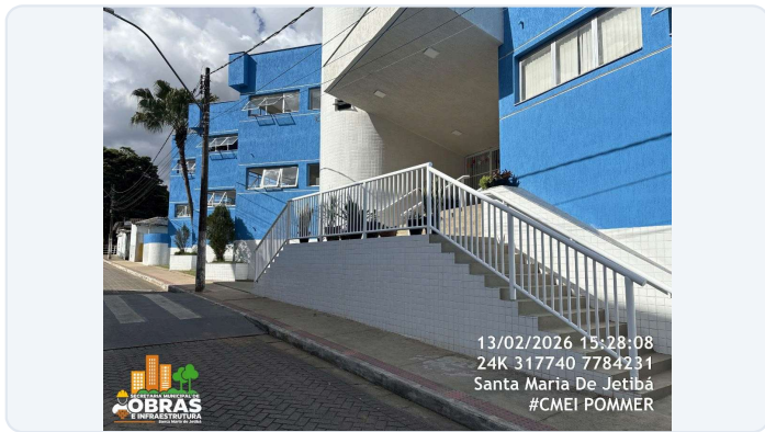
FOTO 11: ITEM 6.0 E 18.22 DA PLANILHA - INSTALAÇÃO E PINTURA DE ESMALTE SINTÉTICO DO GUARDA-CORPO.
