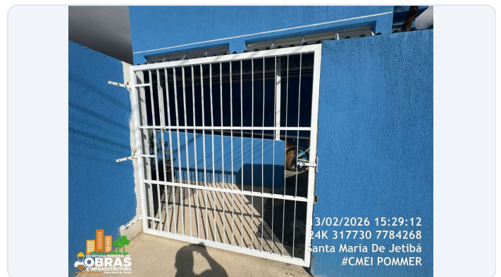
FOTO 14: ITEM 6.0 DA PLANILHA - INSTALAÇÃO E PINTURA DE ESMALTE SINTÉTICO DO ESQUADRIAS METÁLICAS, GRADES E PORTÕES.
