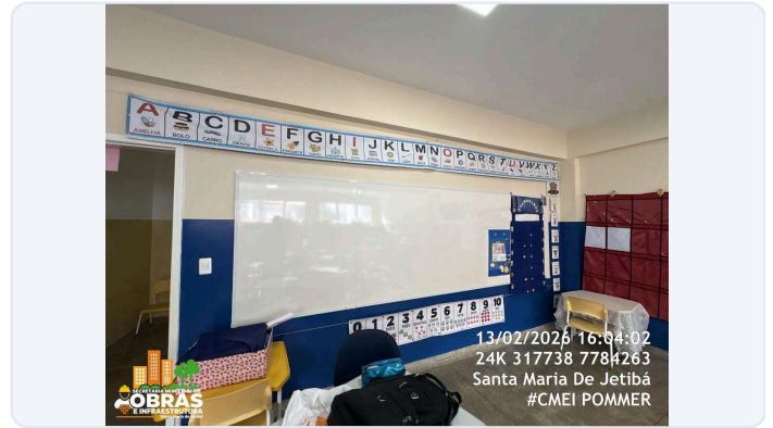
FOTO 10: ITEM 4.8 DA PLANILHA - QUADRO BRANCO PINCEL NOVO INSTALADO.
