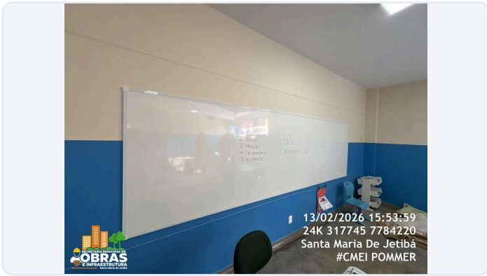
FOTO 5: ITEM 4.8 DA PLANILHA - QUADRO BRANCO PINCEL NOVO INSTALADO.
