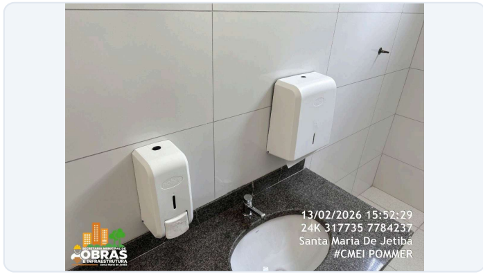
FOTO 41: ITEM 18.13 E 18.14 DA PLANILHA - FORNECIMENTO E INSTALAÇÃO DE SABONETEIRAS E PAPELEIRAS
