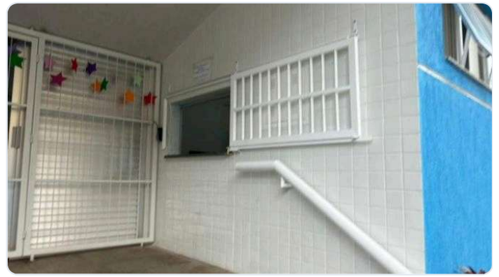
FOTO 16: ITEM 6.0 DA PLANILHA - INSTALAÇÃO E PINTURA DE ESMALTE SINTÉTICO DO ESQUADRIAS METÁLICAS, GRADES E PORTÕES.
