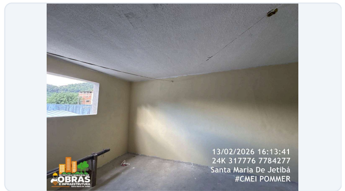
FOTO 56: ITEM 12.0 DA PLANILHA - PINTURA INTERNA E EXTERNA DA ÁREA DA RAMPA NOVA.
