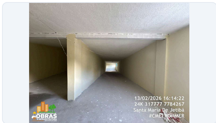
FOTO 62: ITEM 12.0 DA PLANILHA - PINTURA INTERNA E EXTERNA DA ÁREA DA RAMPA NOVA.
