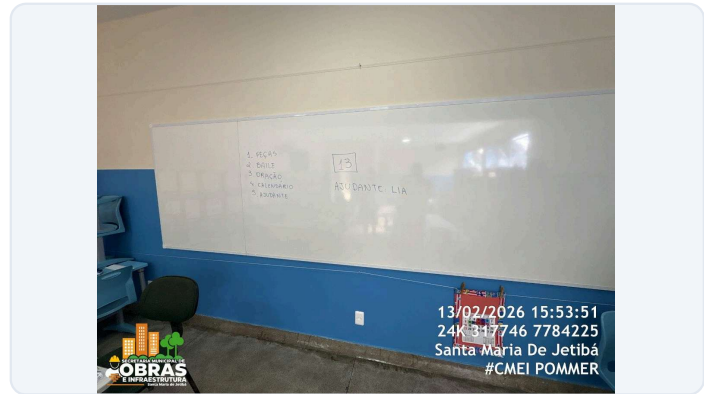
FOTO 4: ITEM 4.8 DA PLANILHA - QUADRO BRANCO PINCEL NOVO INSTALADO.
