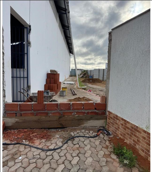
Foto 08 - Muro de fechamento
