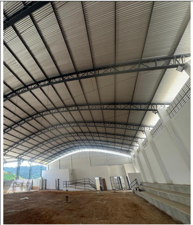
Foto 02 - Alvenaria arquivancada e rampa
