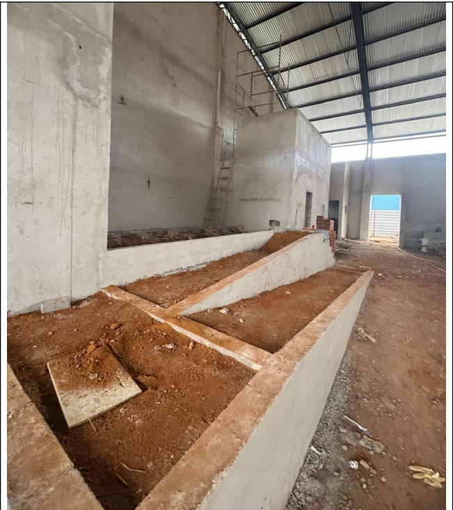
Foto 04 - Alvenaria e aterro rampa
