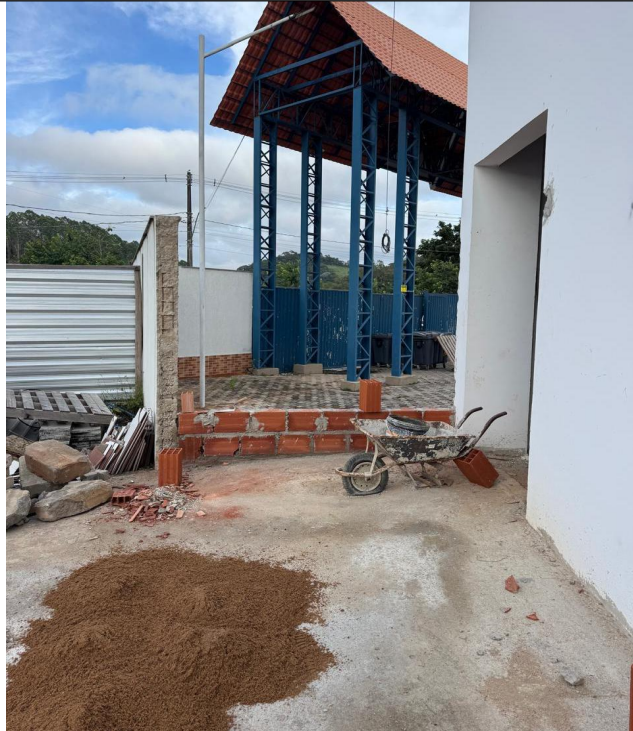
Foto 07 - Muro de fechamento
