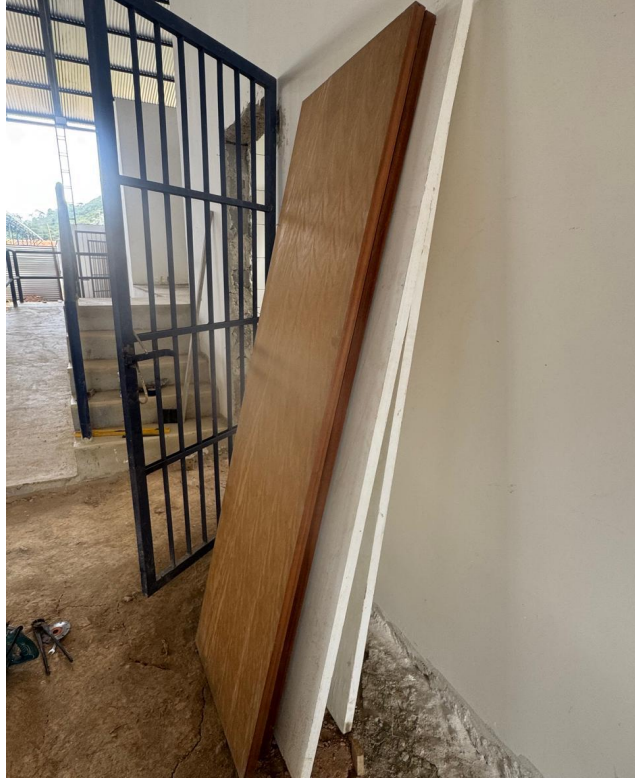
Foto 11 - Portas de madeira
