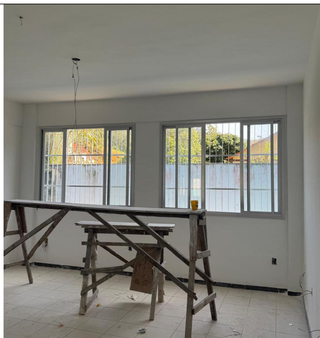
Foto 10 - Janela em alumínio com vidro
