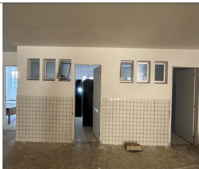
Foto 01 - Balcões em alumínio com vidro
