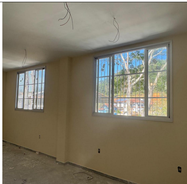
Foto 07 - Janela em alumínio com vidro
