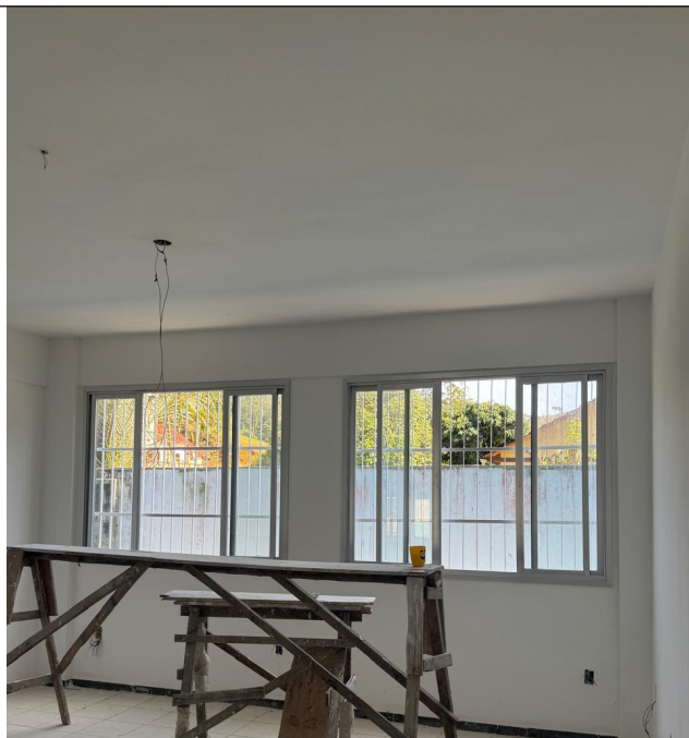
Foto 21 - Forro de Gesso
