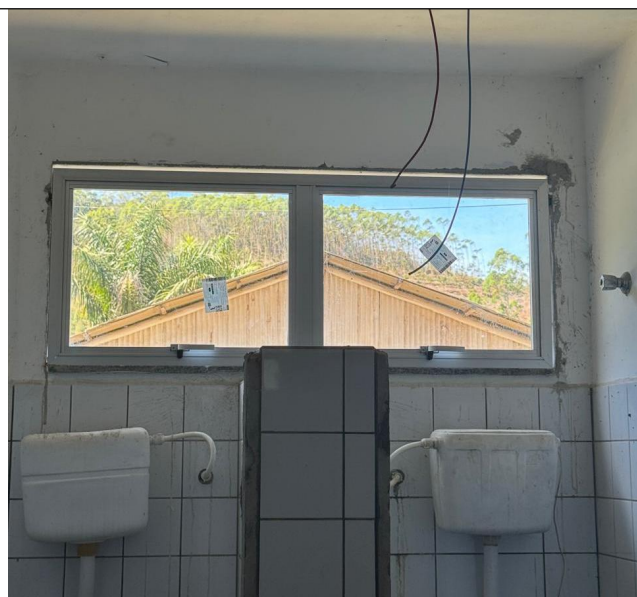
Foto 03 - Balcões em alumínio com vidro
