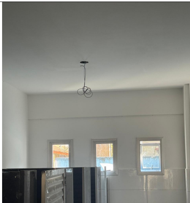
Foto 22 - Forro de Gesso
