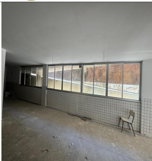
Foto 09 - Janela em alumínio com vidro
