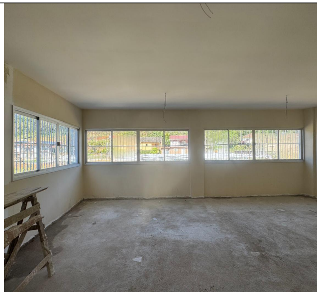
Foto 05 - Janela em alumínio com vidro
