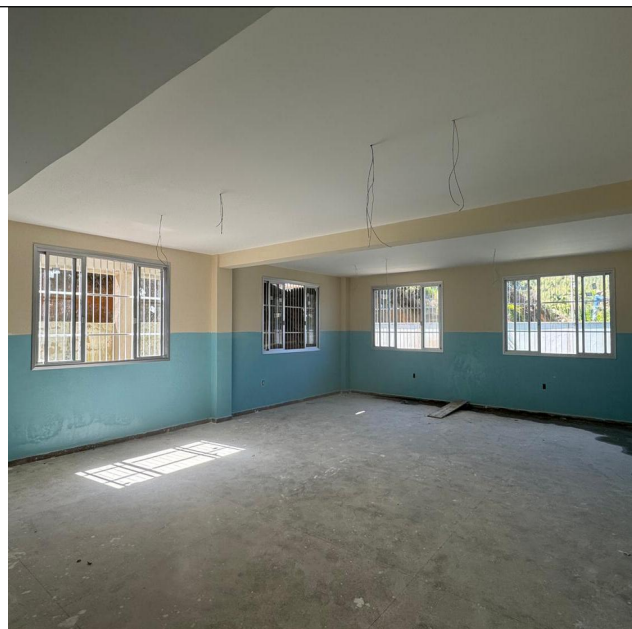
Foto 08 - Janela em alumínio com vidro
