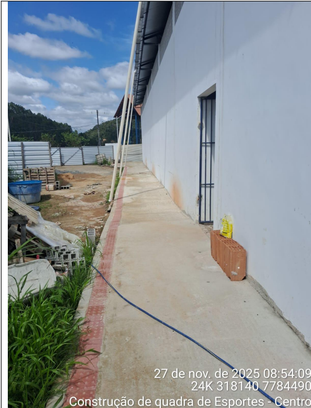
Instalação de Ladrilho Hidraulico
