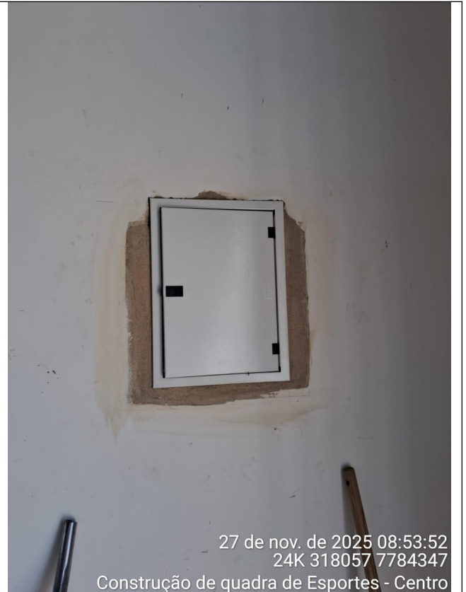
Instalação de quadro elétrico
