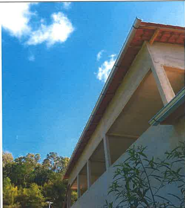
Foto 05 - Calha de Beiral Vestiários
