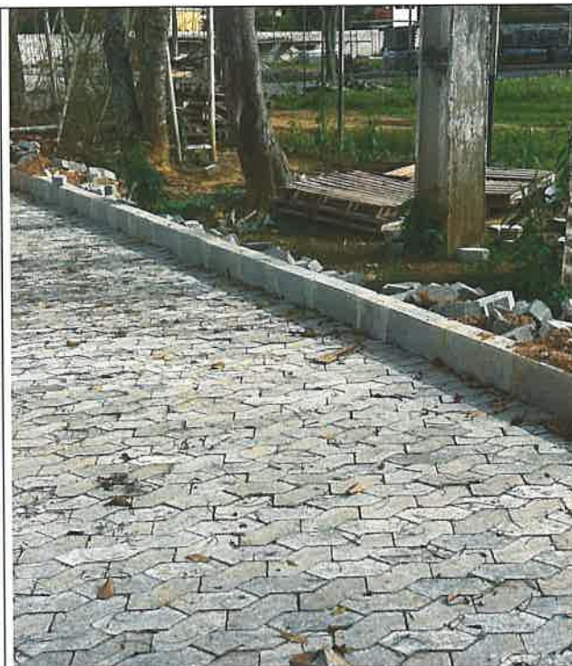
Foto 24 - Pavimentação de blocos pré-moldados e Meio-fio
