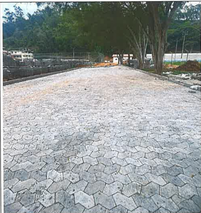
Foto 21 - Pavimentação de blocos pré-moldados e Meio-fio
