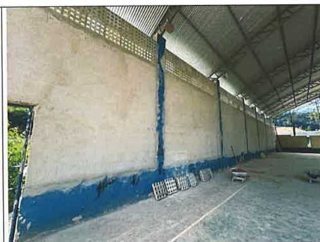
Foto 28 - Alvenaria / Chapisco / Reboco / Cobogó
