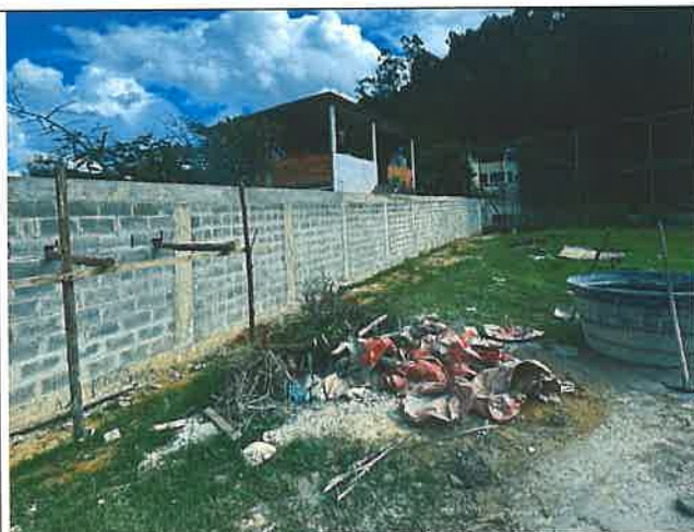
Foto 14 - Alvenaria e Fornecimento e Aplicação de Concreto
