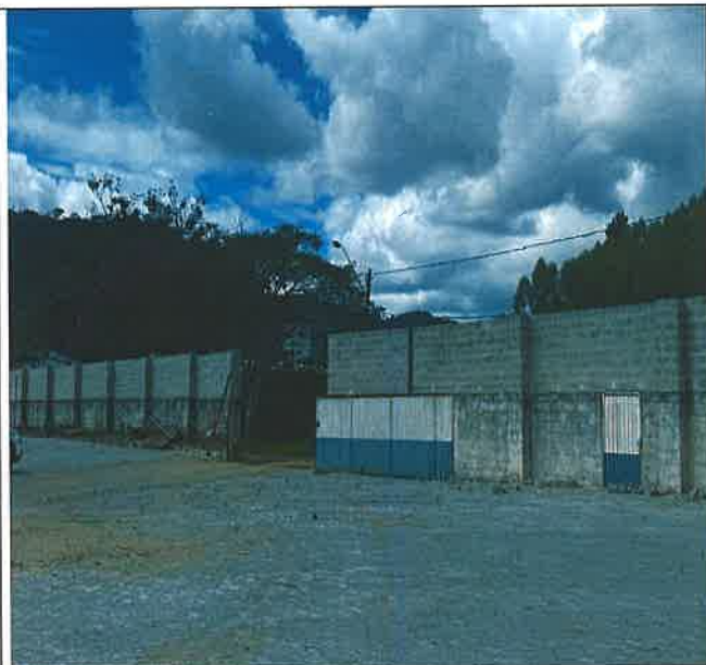
Foto 09 - Alvenaria de Blocos
