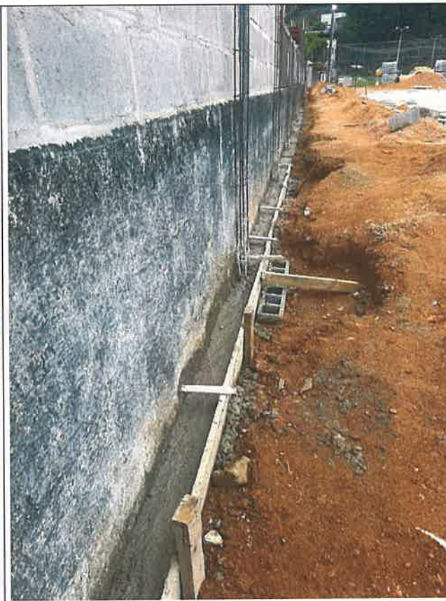
Foto 20 - Fornecimento e Colocação de Armadura e Fornecimento e Aplicação de Concreto
