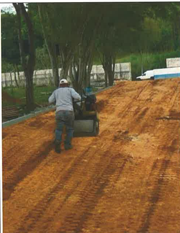
Foto 26 - Preparo, Regularização e Compactação do Terreno
