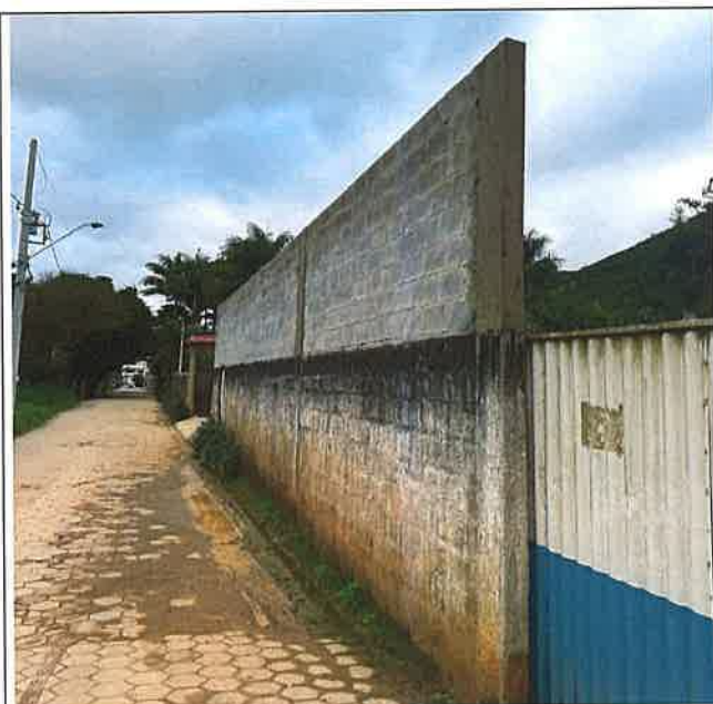
Foto 07 - Alvenaria, Forma de Tábua de Madeira e Fornecimento e Aplicação de Concreto
