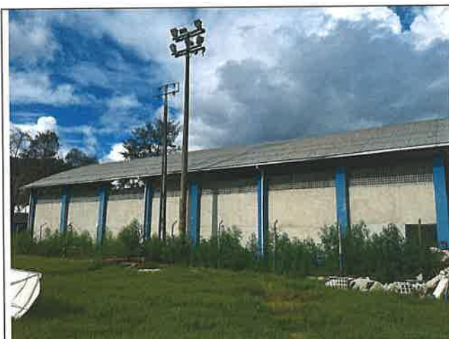
Foto 27 - Alvenaria / Chapisco / Reboco / Cobogó
