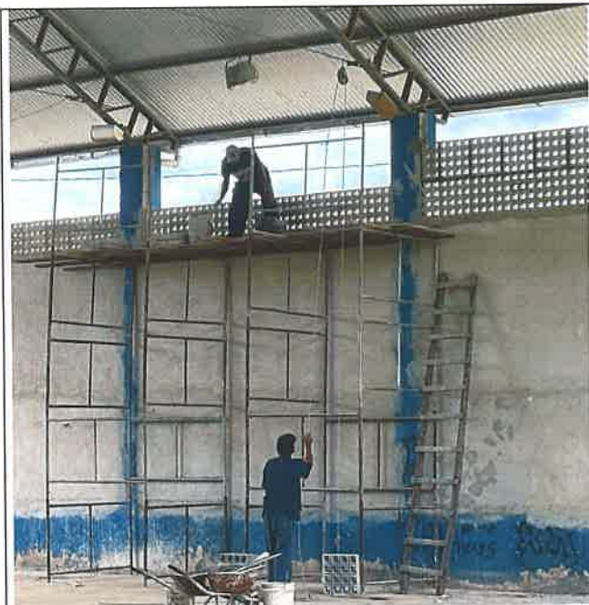
Foto 29 - Alvenaria / Chapisco / Reboco / Cobogó
