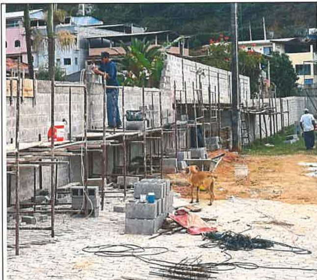
Foto 17 - Alvenaria, Forma de Tábua de Madeira e Fornecimento e Aplicação de Concreto
