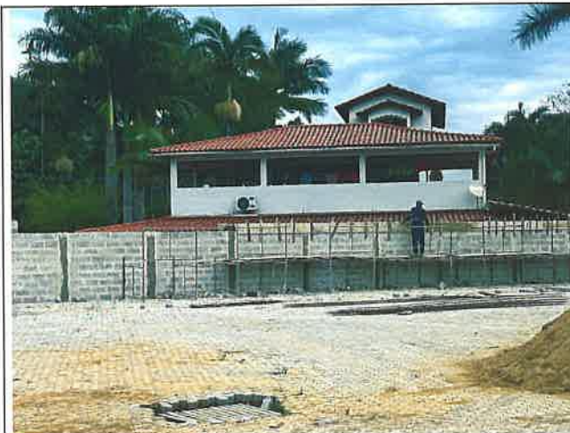
Foto 13 - Alvenaria, Forma de Tábua de Madeira e Fornecimento e Aplicação de Concreto
