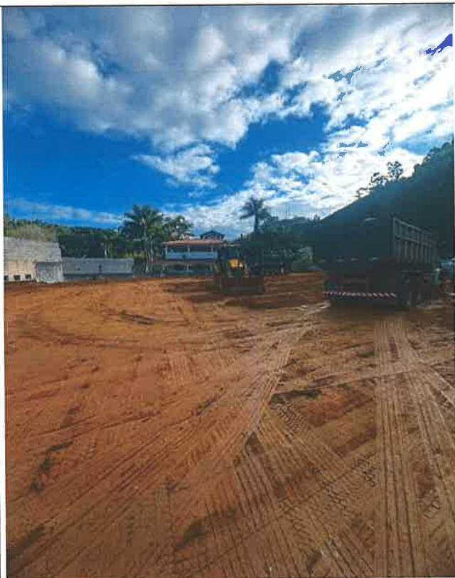
Foto 25 - Preparo, Regularização e Compactação do Terreno
