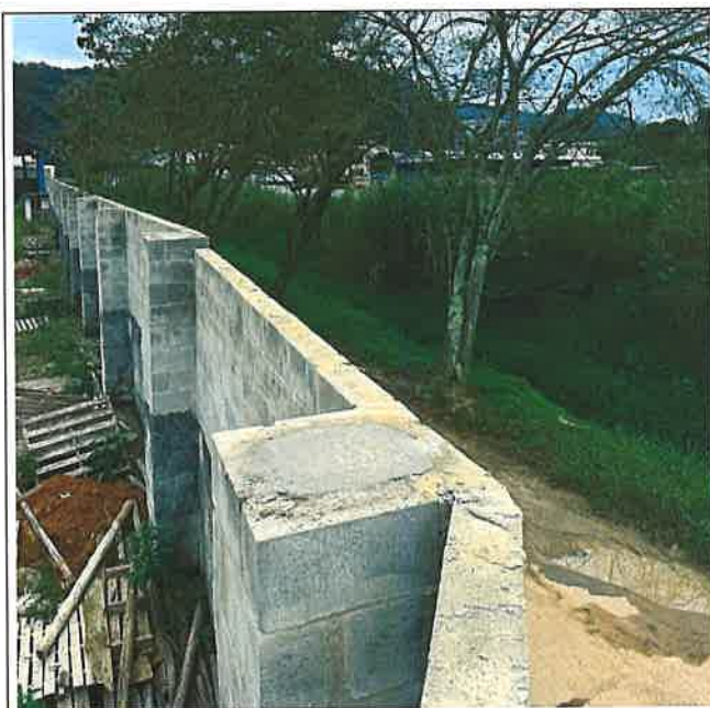
Foto 11 - Alvenaria e Fornecimento e Aplicação de Concreto
