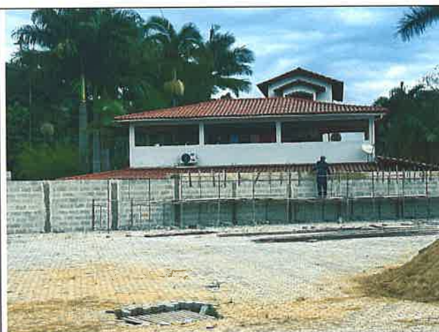
Foto 16 - Alvenaria, Forma de Tábua de Madeira e Fornecimento e Aplicação de Concreto
