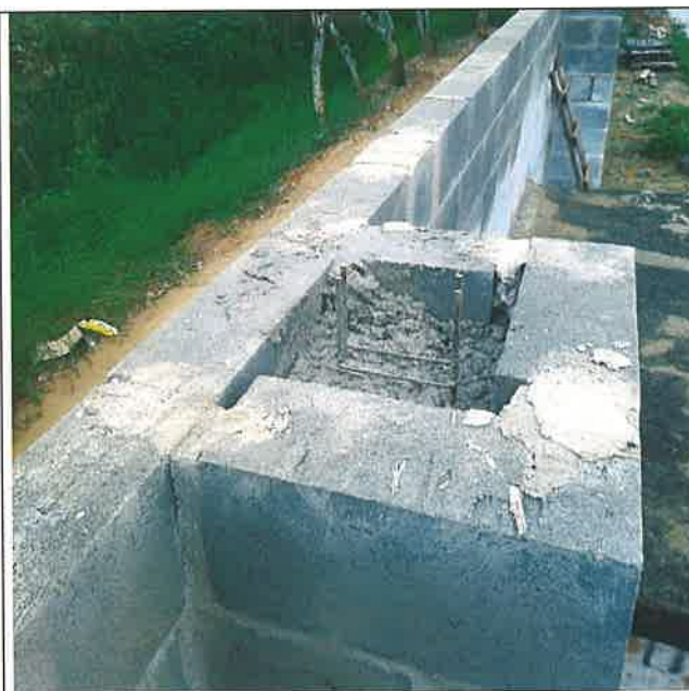
Foto 12 - Alvenaria, Fornecimento e Colocação de Armadura e Fornecimento e Aplicação de Concreto
