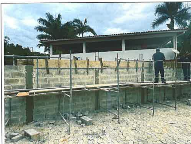
Foto 15 - Alvenaria, Forma de Tábua de Madeira e Fornecimento e Aplicação de Concreto
