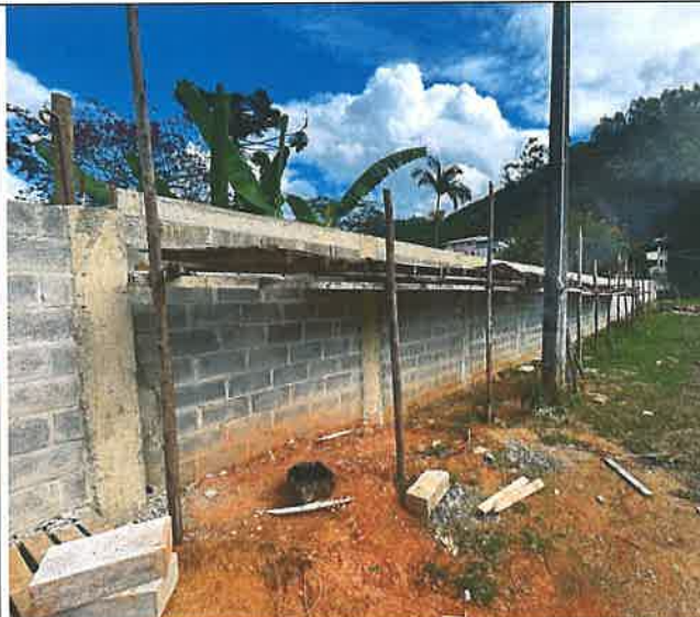
Foto 18 - Alvenaria e Fornecimento e Aplicação de Concreto
