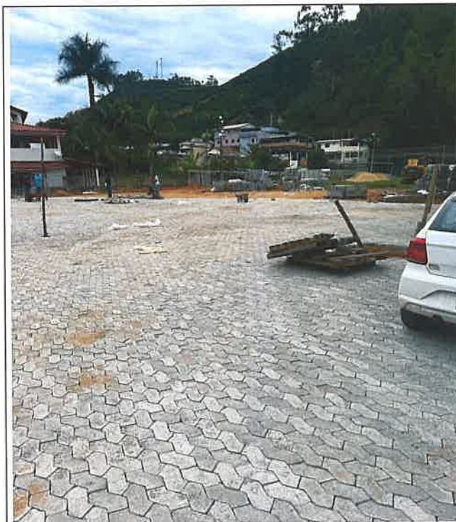
Foto 23 - Pavimentação de blocos pré-moldados
