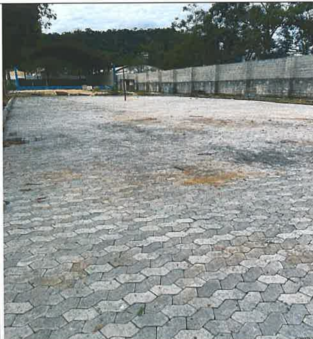
Foto 22 - Pavimentação de blocos pré-moldados
