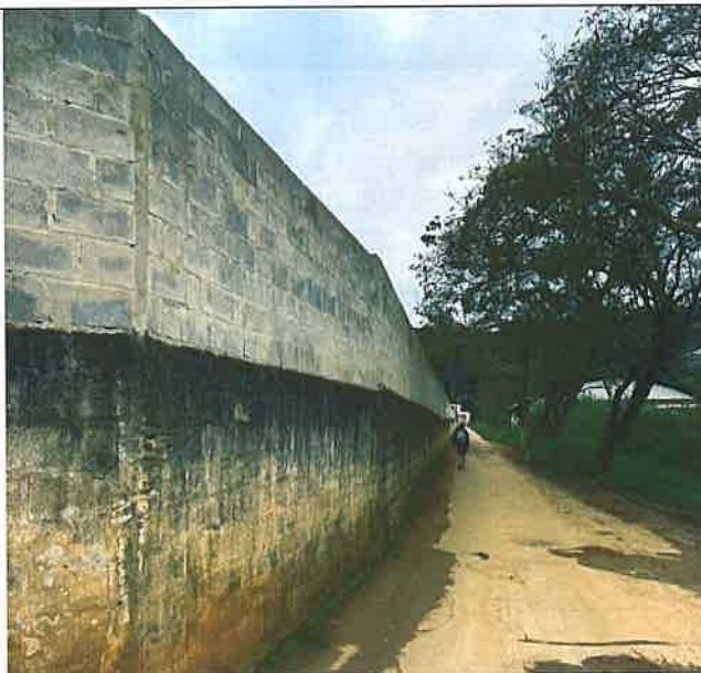
Foto 10 - Alvenaria de Blocos
