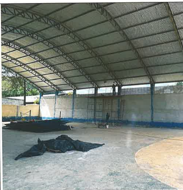
Foto 30 - Alvenaria / Chapisco / Reboco / Cobogó
