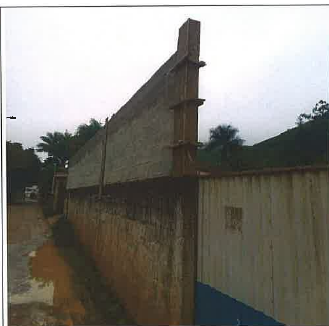
Foto 08 - Alvenaria, Forma de Tábua de Madeira e Fornecimento e Aplicação de Concreto
