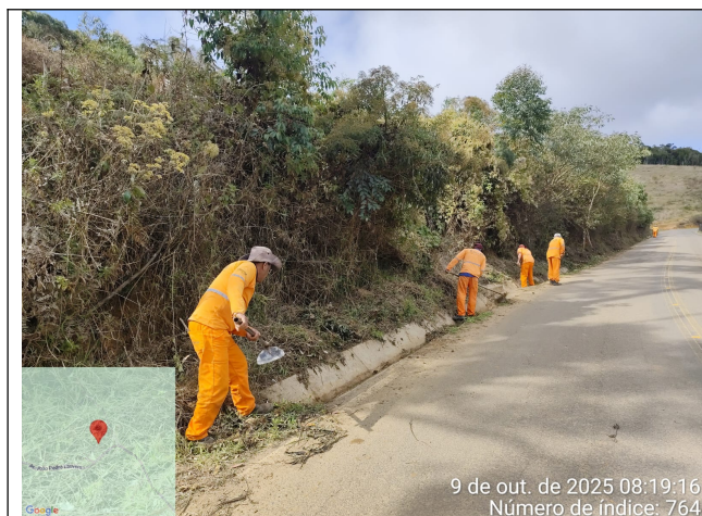
Foto 31: Serviço de roçagem e limpeza no Trecho 9
