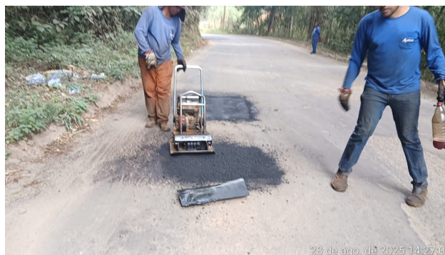
Foto 08: Serviço de tapa buraco nos Trechos 3 e 4
