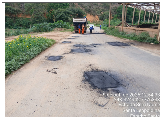
Foto 27: Serviço de tapa buraco no Trecho 9
