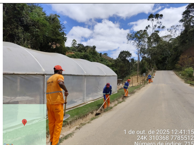
Foto 14: Serviço de roçagem e limpeza no Trecho 4
