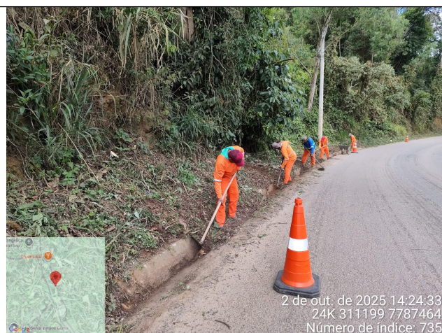
Foto 06: Serviço de roçagem e limpeza no Trecho 3
