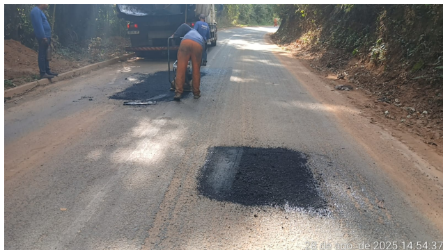
Foto 01: Serviço de tapa buraco nos Trechos 3 e 4
