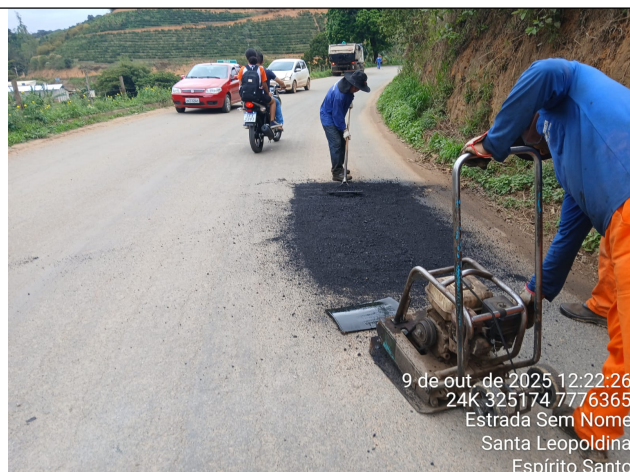
Foto 32: Serviço de tapa buraco no Trecho 9
