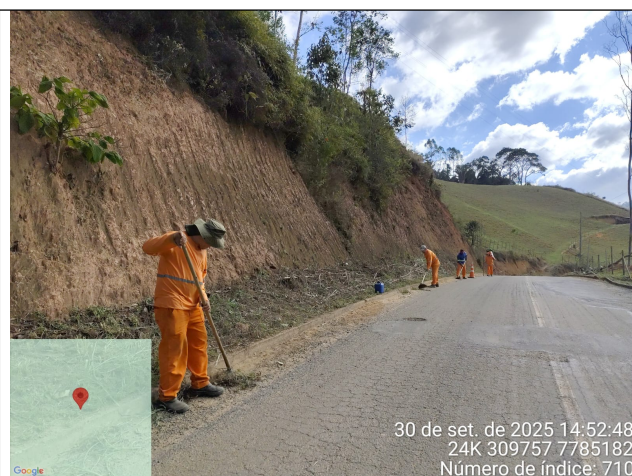
Foto 22: Serviço de roçagem e limpeza no Trecho 4
