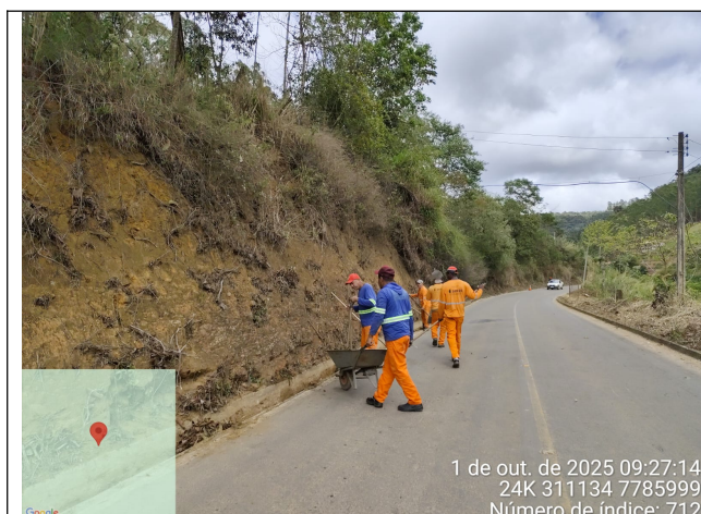
Foto 15: Serviço de roçagem e limpeza no Trecho 4
