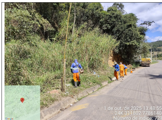
Foto 05: Serviço de roçagem e limpeza no Trecho 3
