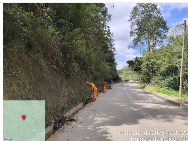
Foto 18: Serviço de roçagem e limpeza no Trecho 4
