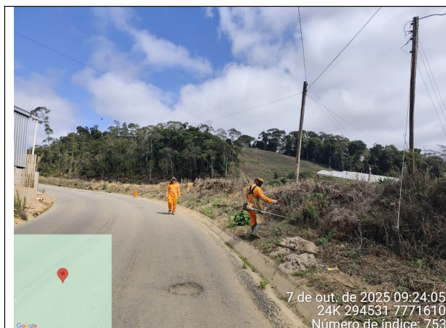
Foto 25: Serviço de roçagem e limpeza no Trecho 9
