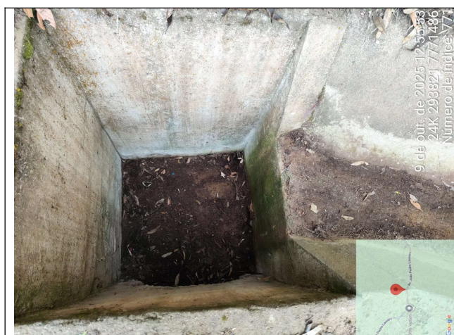
Foto 33: Serviço de roçagem e limpeza no Trecho 9
