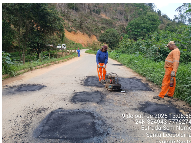
Foto 34: Serviço de tapa buraco no Trecho 9
