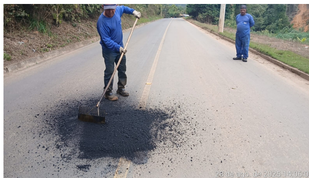
Foto 02: Serviço de tapa buraco nos Trechos 3 e 4
