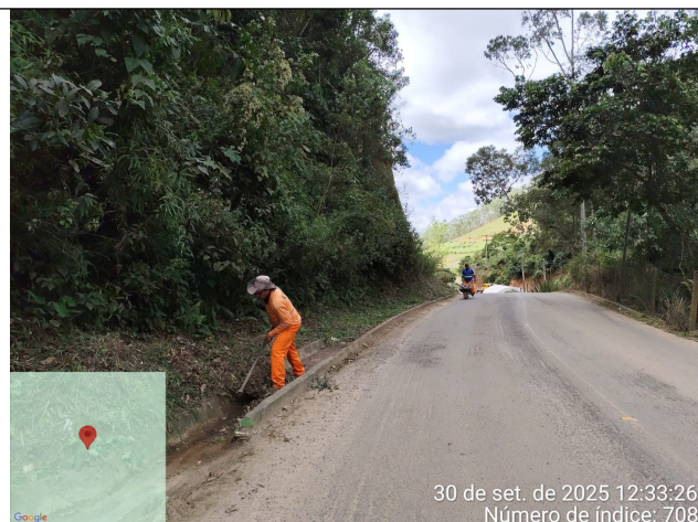
Foto 12: Serviço de roçagem e limpeza no Trecho 4
