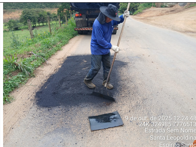
Foto 26: Serviço de tapa buraco no Trecho 9
