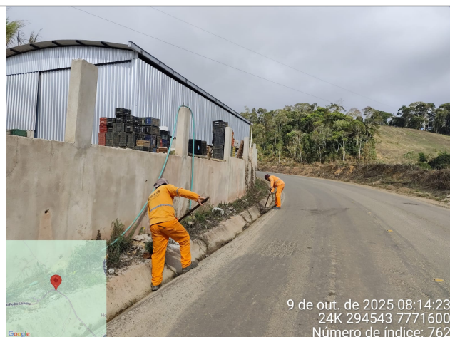
Foto 28: Serviço de roçagem e limpeza no Trecho 9
