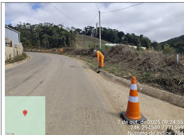
Foto 27: Serviço de roçagem e limpeza no Trecho 9
