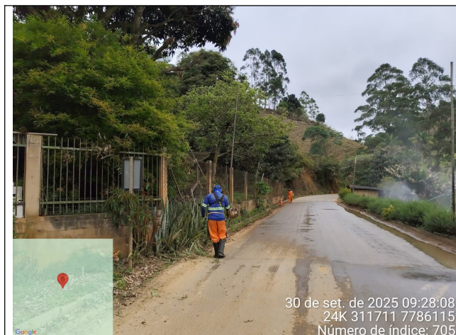
Foto 11: Serviço de roçagem e limpeza no Trecho 4
