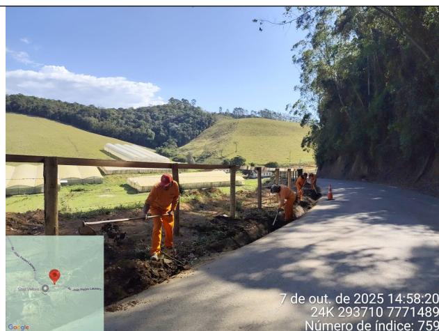
Foto 24: Serviço de roçagem e limpeza no Trecho 9
