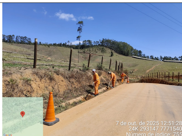
Foto 26: Serviço de roçagem e limpeza no Trecho 9
