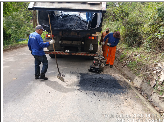
Foto 13: Serviço de tapa buraco nos Trechos 3 e 4
