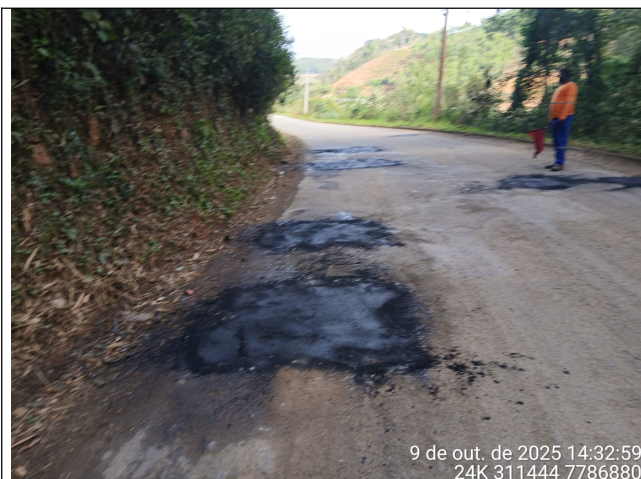
Foto 15: Serviço de tapa buraco nos Trechos 3 e 4
