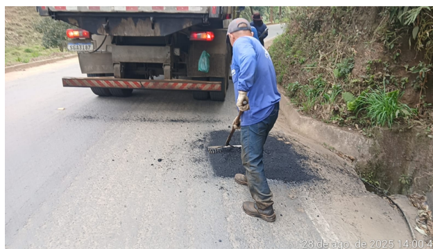
Foto 10: Serviço de tapa buraco nos Trechos 3 e 4
