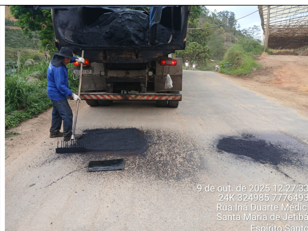
Foto 30: Serviço de tapa buraco no Trecho 9
