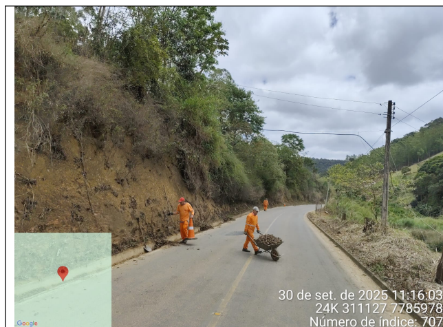
Foto 19: Serviço de roçagem e limpeza no Trecho 4
