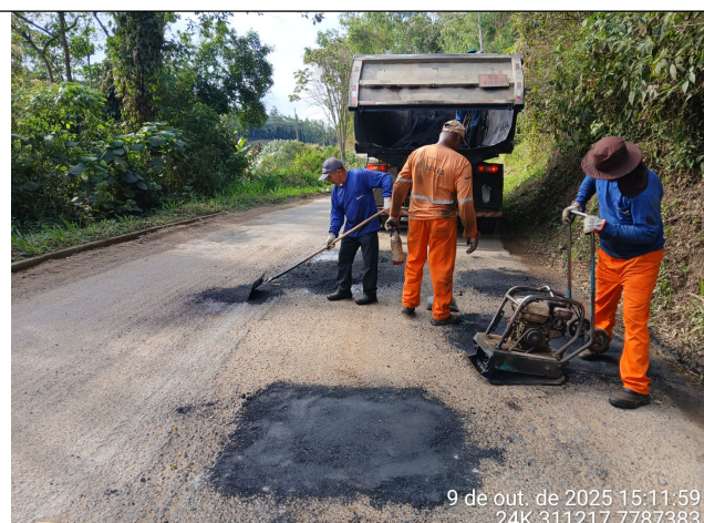
Foto 11: Serviço de tapa buraco nos Trechos 3 e 4
