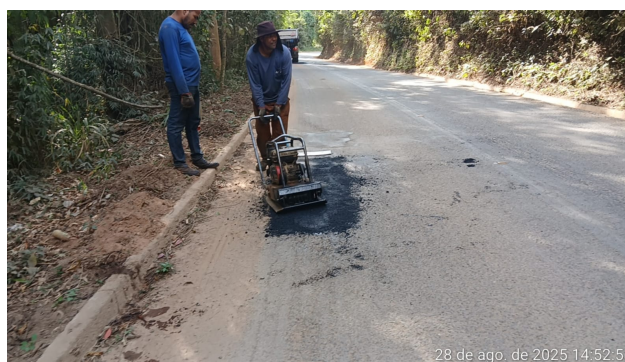
Foto 04: Serviço de tapa buraco nos Trechos 3 e 4
