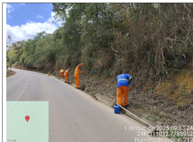
Foto 17: Serviço de roçagem e limpeza no Trecho 4
