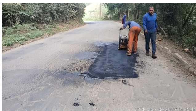
Foto 03: Serviço de tapa buraco nos Trechos 3 e 4
