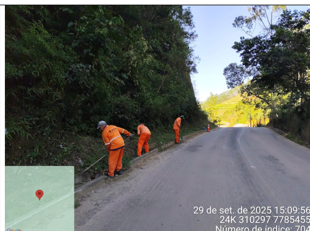
Foto 16: Serviço de roçagem e limpeza no Trecho 4
