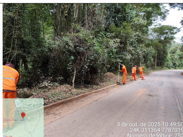
Foto 10: Serviço de roçagem e limpeza no Trecho 3
