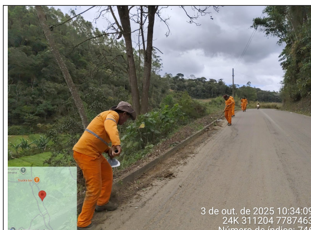
Foto 09: Serviço de roçagem e limpeza no Trecho 3
