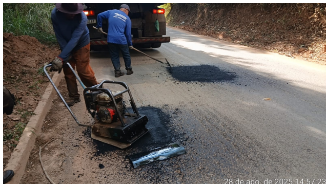
Foto 07: Serviço de tapa buraco nos Trechos 3 e 4
