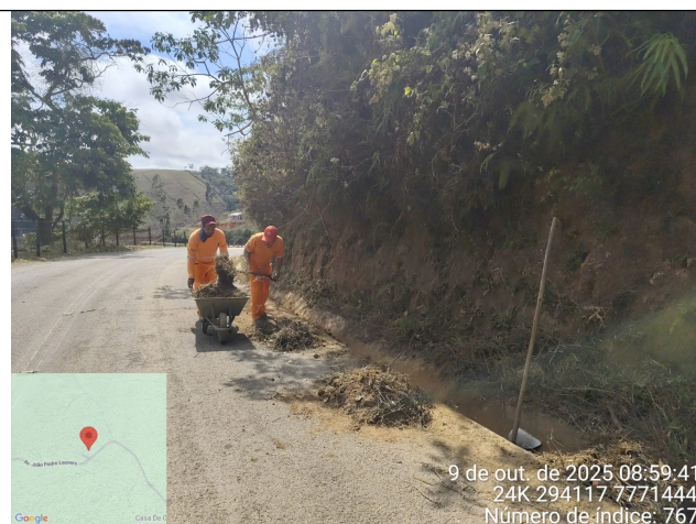
Foto 30: Serviço de roçagem e limpeza no Trecho 9
