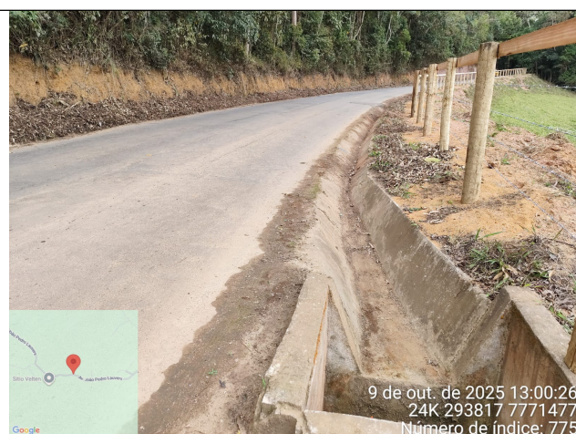
Foto 34: Serviço de roçagem e limpeza no Trecho 9
