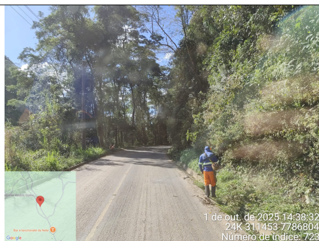
Foto 04: Serviço de roçagem e limpeza no Trecho 3
