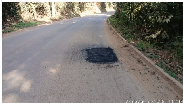
Foto 09: Serviço de tapa buraco nos Trechos 3 e 4
