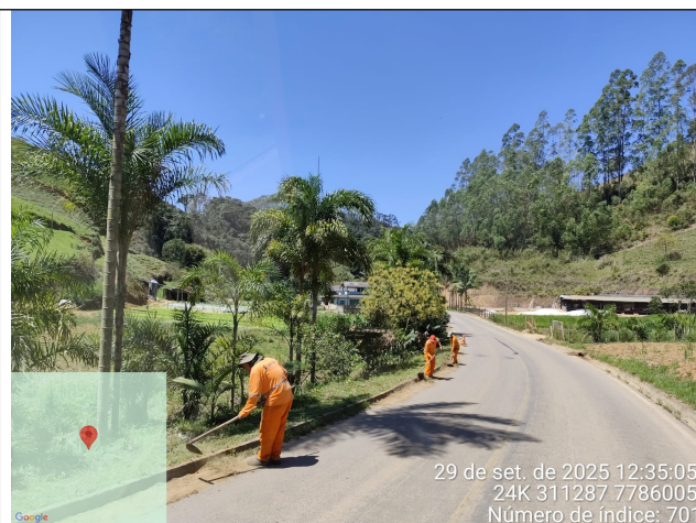
Foto 20: Serviço de roçagem e limpeza no Trecho 4
