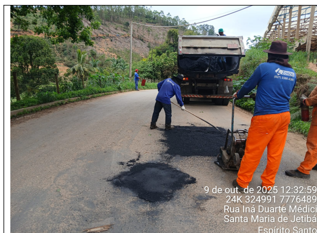
Foto 29: Serviço de tapa buraco no Trecho 9
