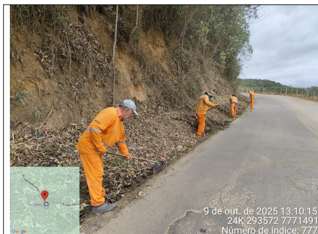
Foto 29: Serviço de roçagem e limpeza no Trecho 9
