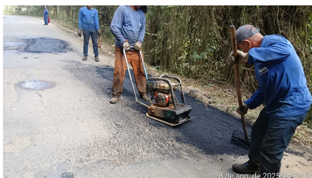
Foto 05: Serviço de tapa buraco nos Trechos 3 e 4
