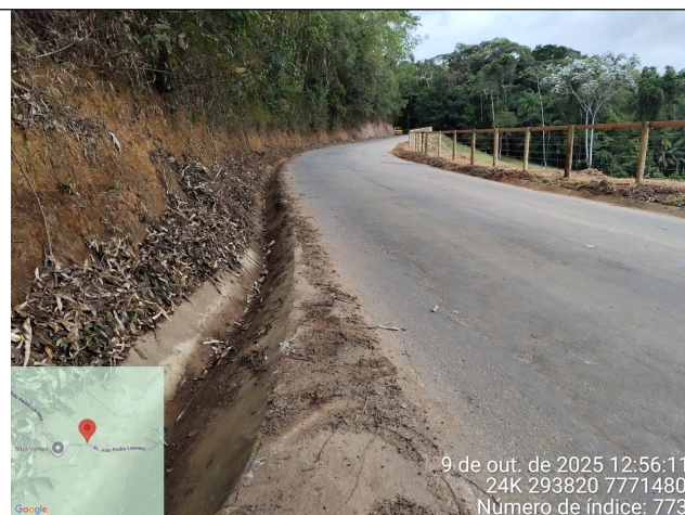
Foto 32: Serviço de roçagem e limpeza no Trecho 9
