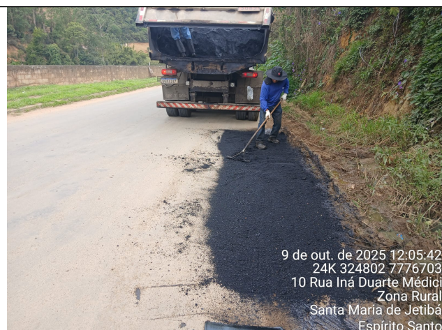
Foto 33: Serviço de tapa buraco no Trecho 9
