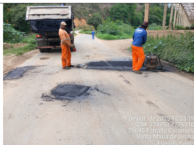
Foto 28: Serviço de tapa buraco no Trecho 9
