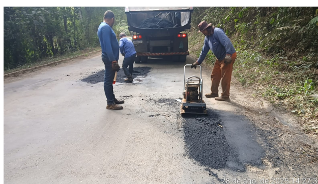
Foto 06: Serviço de tapa buraco nos Trechos 3 e 4
