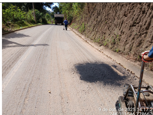
Foto 12: Serviço de tapa buraco nos Trechos 3 e 4
