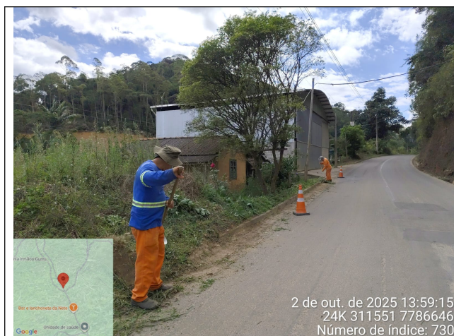
Foto 01: Serviço de roçagem e limpeza no Trecho 3
