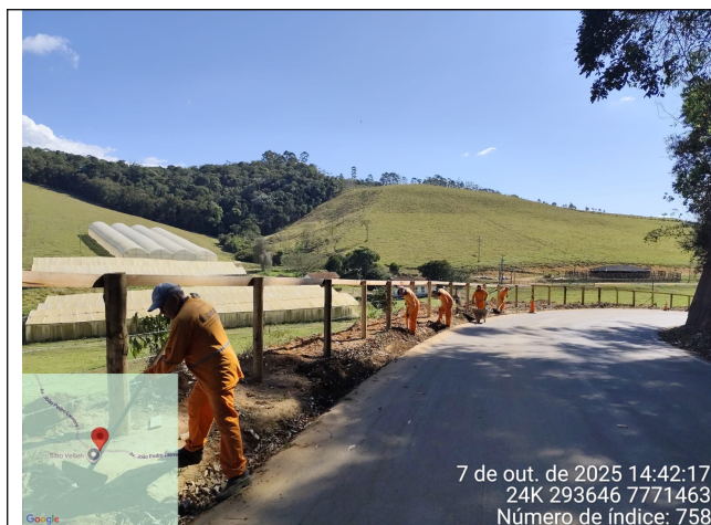
Foto 23: Serviço de roçagem e limpeza no Trecho 9
