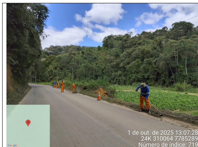
Foto 21: Serviço de roçagem e limpeza no Trecho 4
