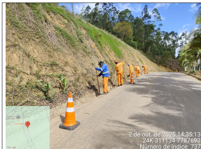
Foto 07: Serviço de roçagem e limpeza no Trecho 3
