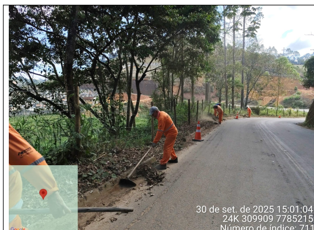
Foto 13: Serviço de roçagem e limpeza no Trecho 4
