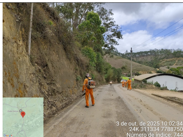
Foto 08: Serviço de roçagem e limpeza no Trecho 3
