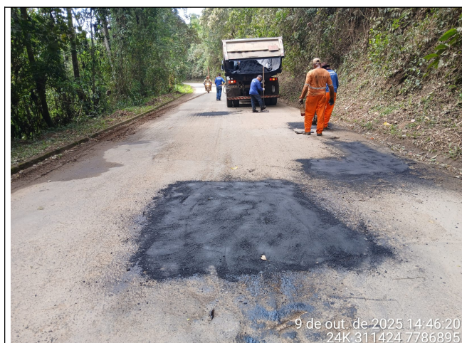
Foto 17: Serviço de tapa buraco nos Trechos 3 e 4
