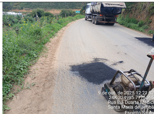
Foto 31: Serviço de tapa buraco no Trecho 9
