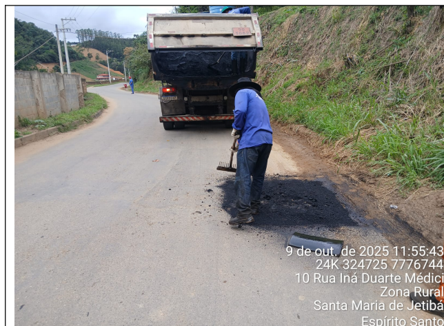
Foto 25: Serviço de tapa buraco no Trecho 9
