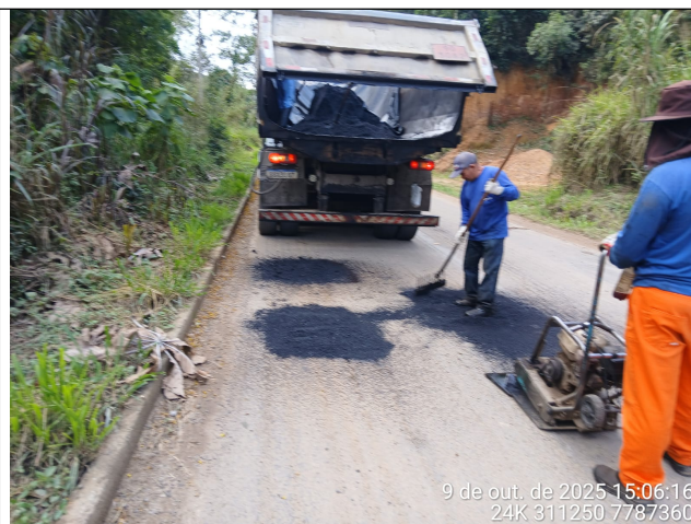
Foto 16: Serviço de tapa buraco nos Trechos 3 e 4
