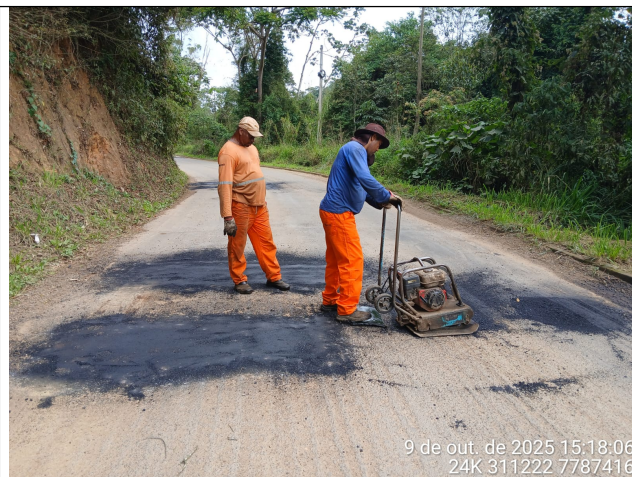
Foto 14: Serviço de tapa buraco nos Trechos 3 e 4
