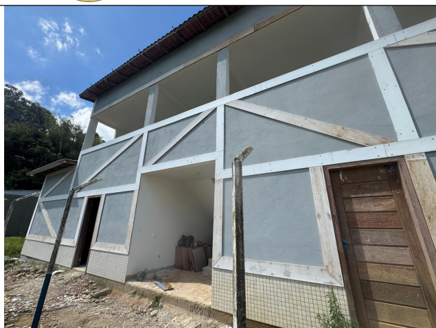
Foto 07 - Roda-parede de madeira de lei (enxaimel)
