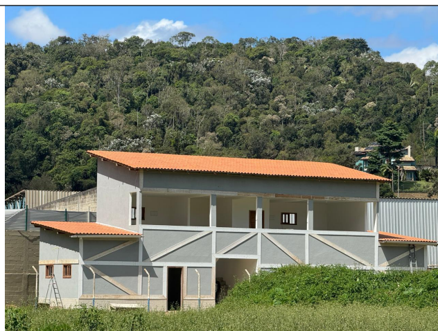
Foto 08 - Roda-parede de madeira de lei (enxaimel)
