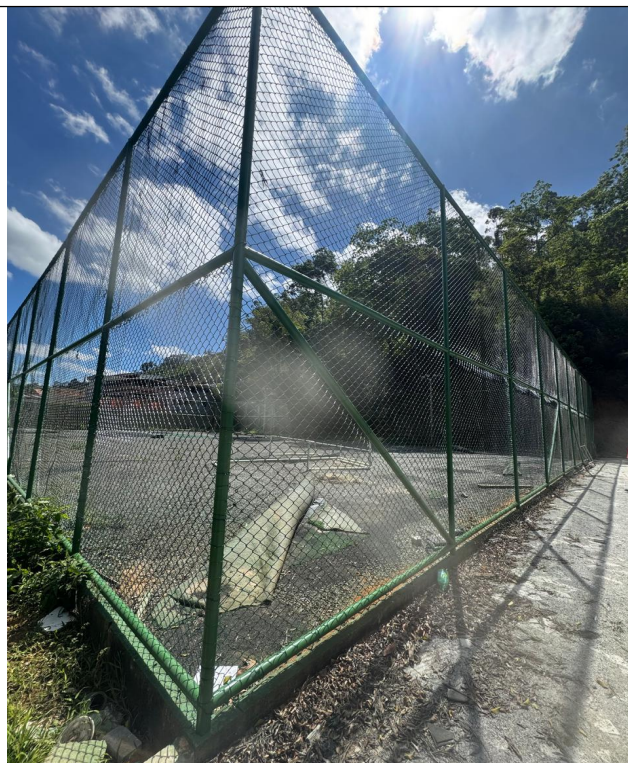
Foto 18 - Alamedado com tela / Pintura com tinta sintética
