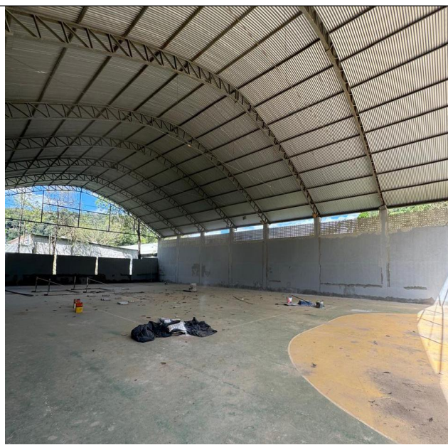
Foto 22 - Pintura da quadra
