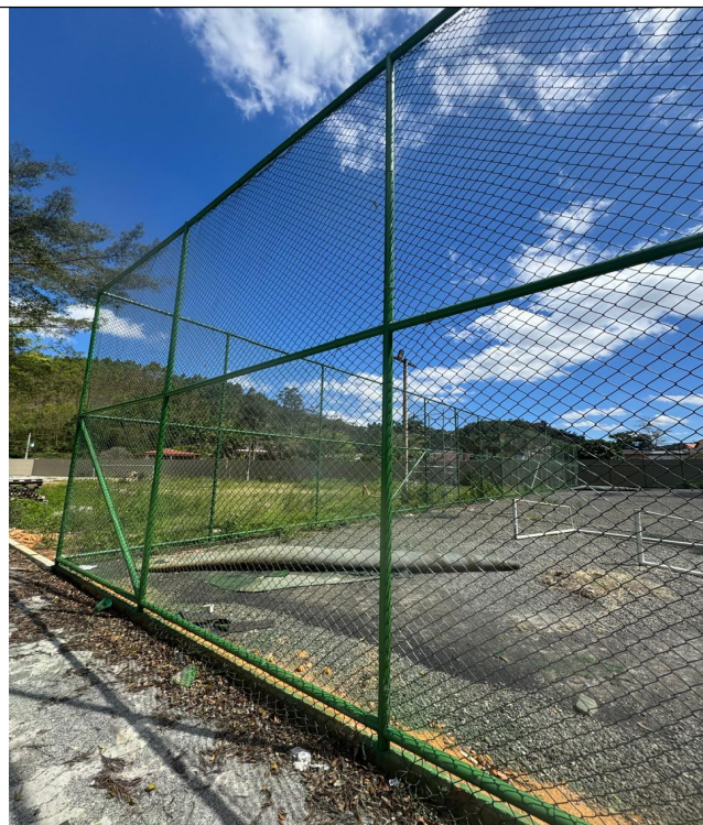
Foto 17 - Alamedado com tela / Pintura com tinta sintética
