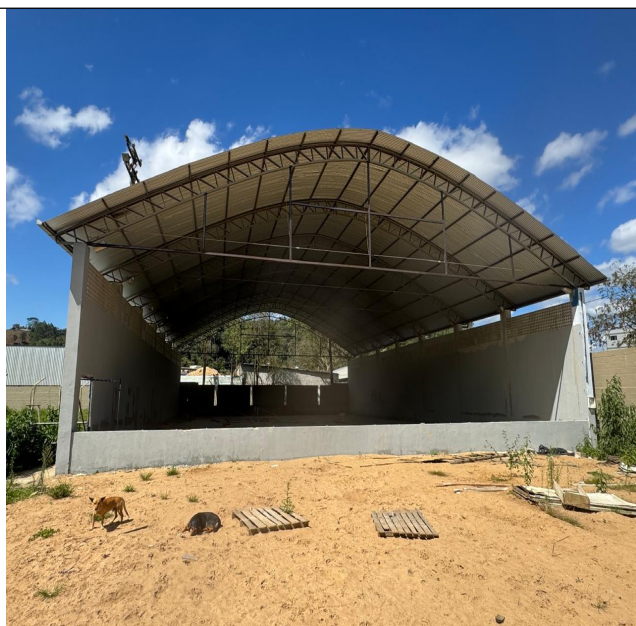
Foto 21 - Pintura da quadra
