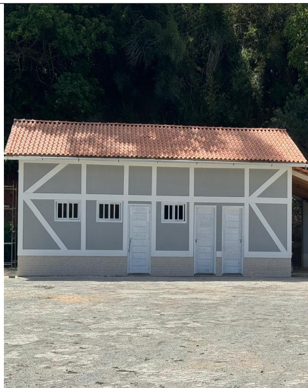
Foto 06 - Roda-parede de madeira de lei (enxaimel)
