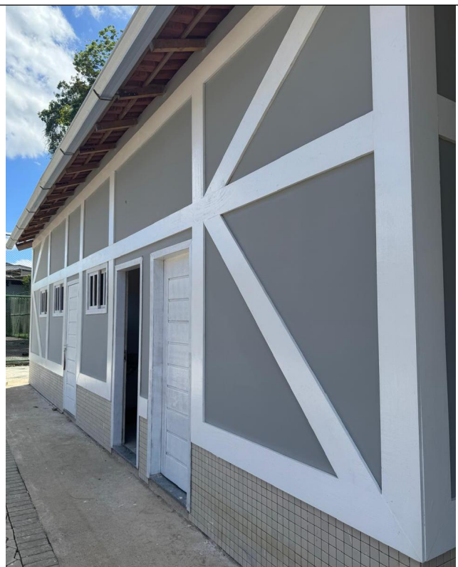
Foto 05 - Roda-parede de madeira de lei (enxaimel)
