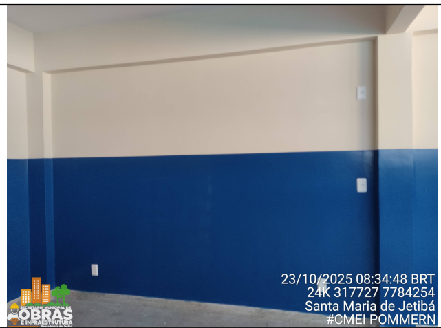
Foto 28: Pintura interna meia parede com esmalte sintético.
