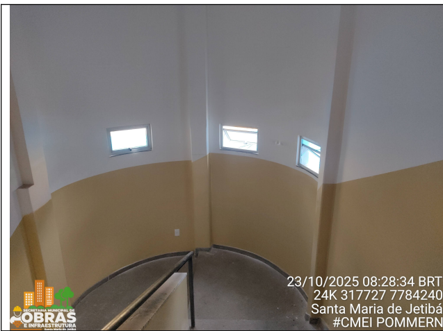
Foto 27: Pintura interna meia parede com esmalte sintético.
