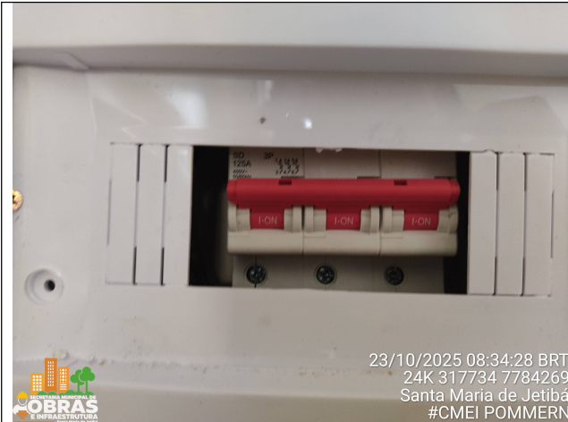
Foto 19: Quadro de distribuição com disjuntor.
