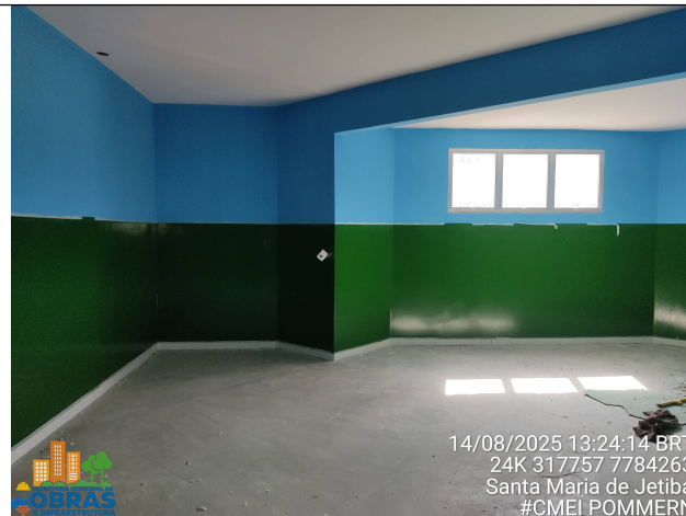
Foto 32: Pintura interna meia parede com esmalte sintético.
