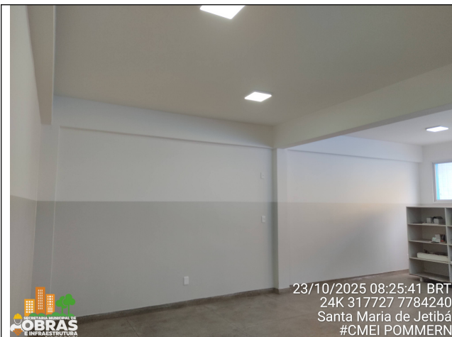
Foto 29: Pintura interna meia parede com esmalte sintético.
