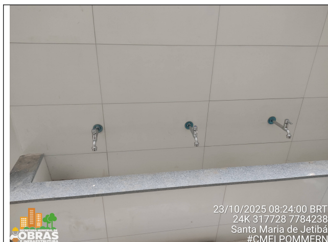
Foto 15: Fornecimento e Instalação de torneiras de parede
