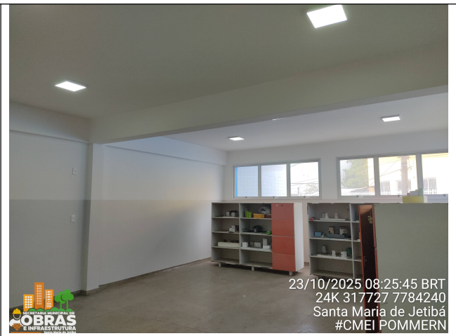
Foto 22: Instalação de luminárias plafon LED 25w, sobrepor.
