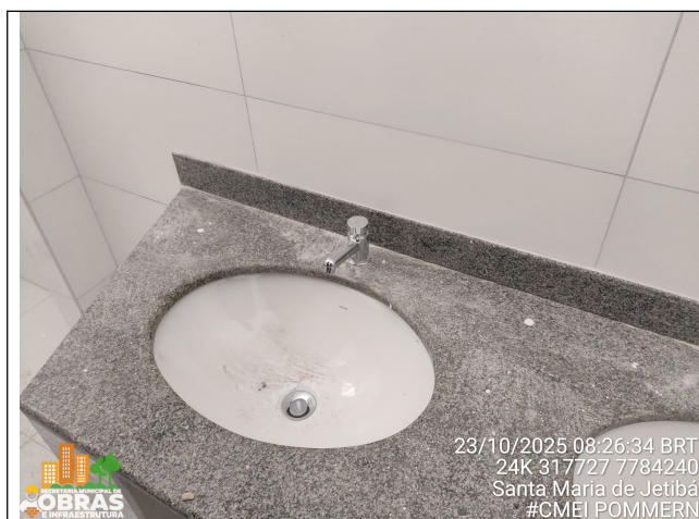
Foto 09: Fornecimento e instalação das cubas.
