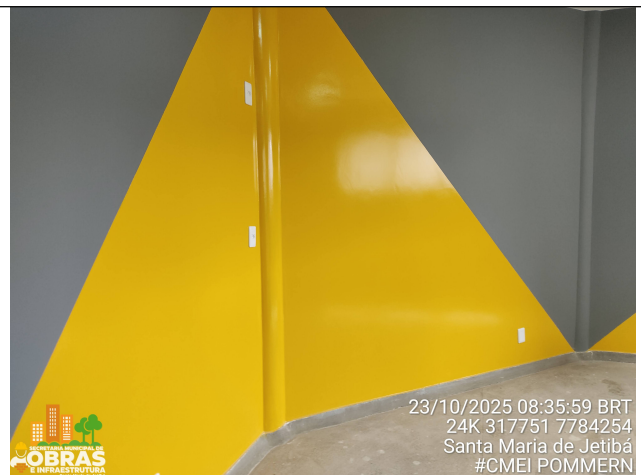
Foto 30: Pintura interna meia parede com esmalte sintético.
