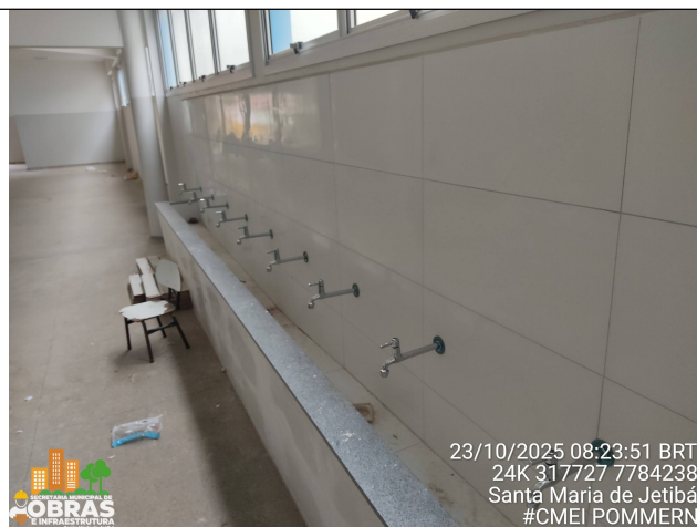
Foto 14: Fornecimento e Instalação de torneiras de parede
