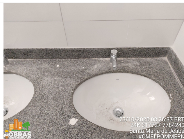
Foto 10: Fornecimento e instalação das cubas.
