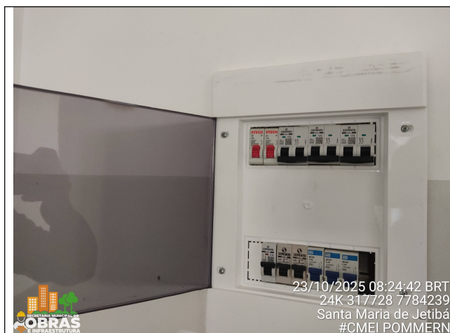
Foto 17: Quadro de distribuição instalado com disjuntores
