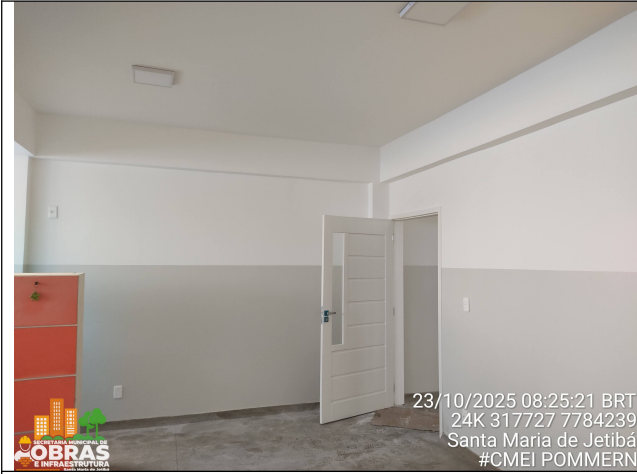
Foto 25: Pintura esmalte sintético, marcos e portas de madeira.
