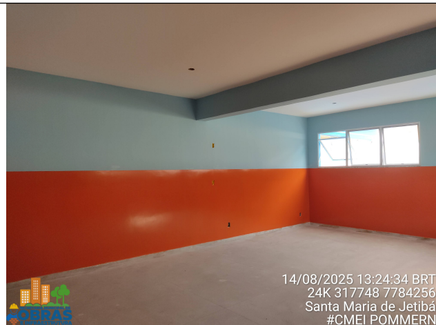
Foto 31: Pintura interna meia parede com esmalte sintético.
