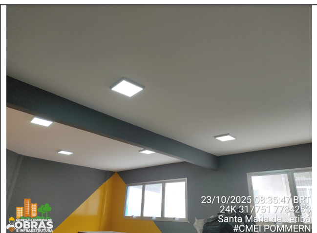
Foto 24: Instalação de luminárias plafon LED 25w, sobrepor.
