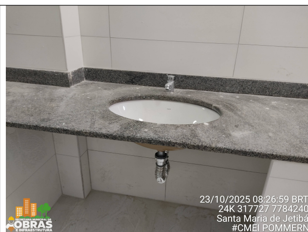
Foto 12: Fornecimento e instalação das cubas.
