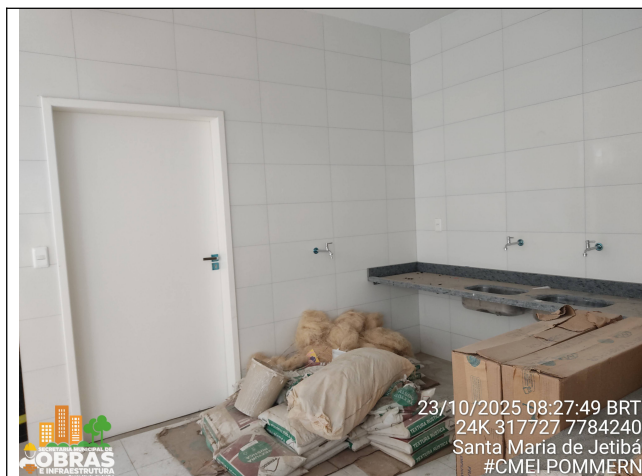
Foto 13: Fornecimento e Instalação de torneiras de parede
