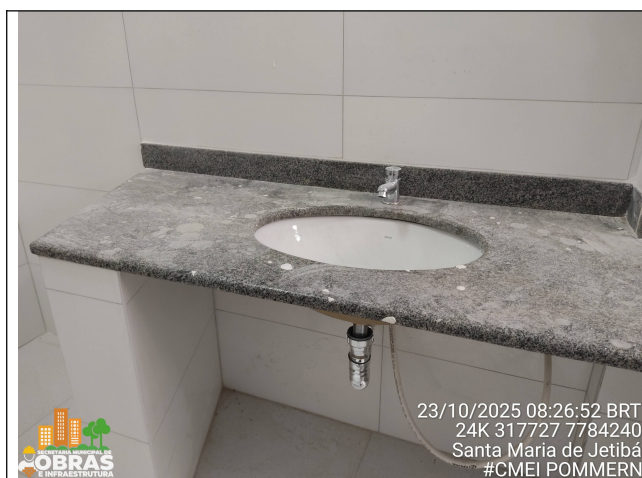
Foto 11: Fornecimento e instalação das cubas.
