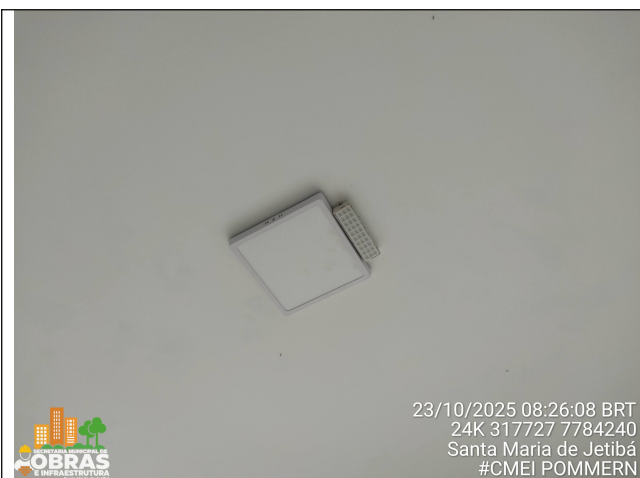
Foto 23: Instalação de luminárias plafon LED 25w, sobrepor.
