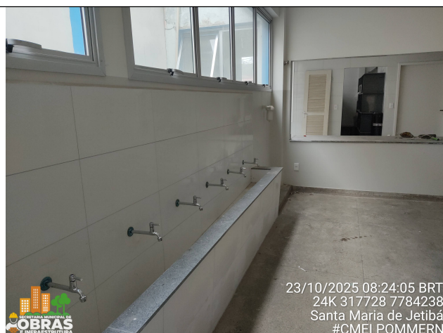
Foto 16: Fornecimento e Instalação de torneiras de parede
