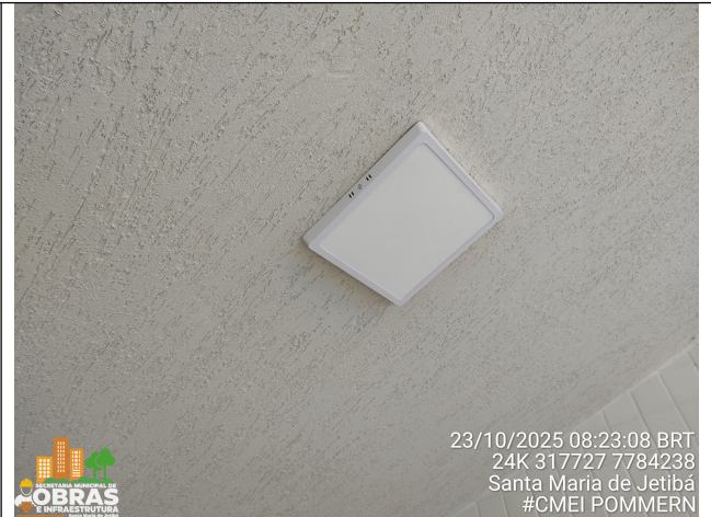
Foto 20: Instalação de luminárias plafon LED 25w, sobrepor.
