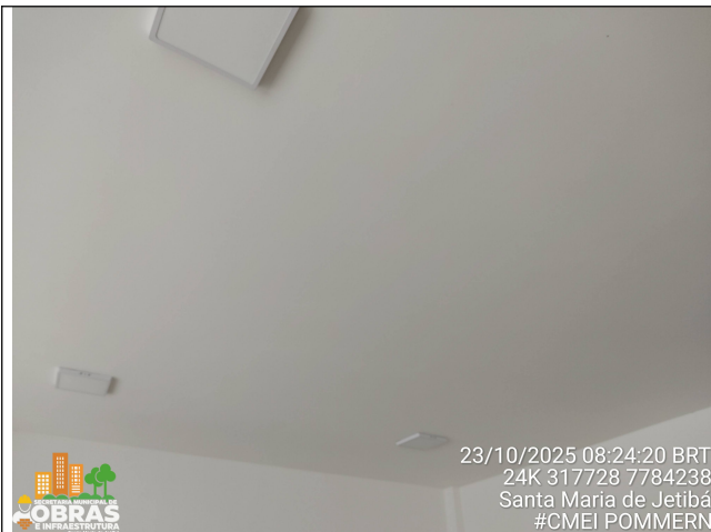
Foto 21: Instalação de luminárias plafon LED 25w, sobrepor.
