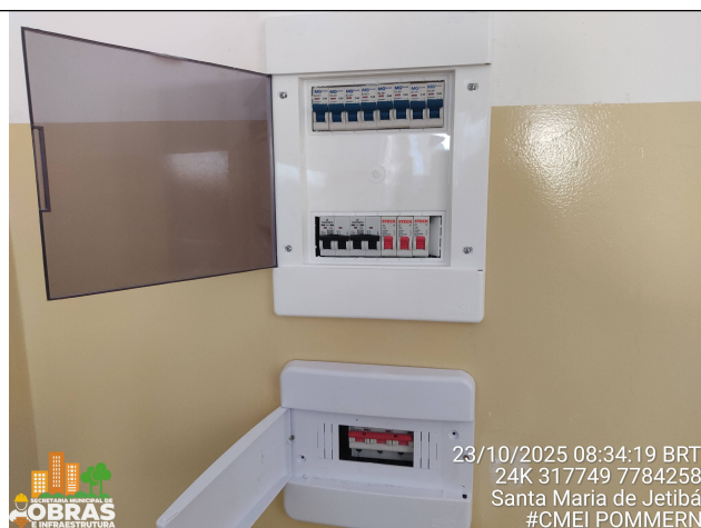
Foto 18: Quadro de distribuição instalado com disjuntores
