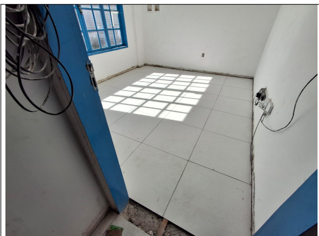
Foto 09: Assentamento de Piso cerâmico no depósito
