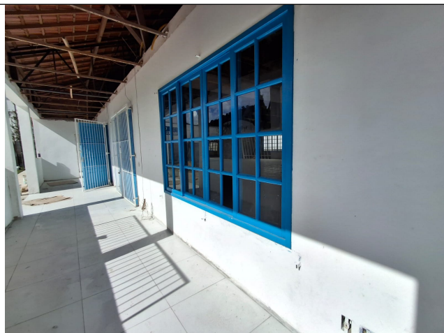
Foto 12: Pintura de Paredes esquadrias e grades
