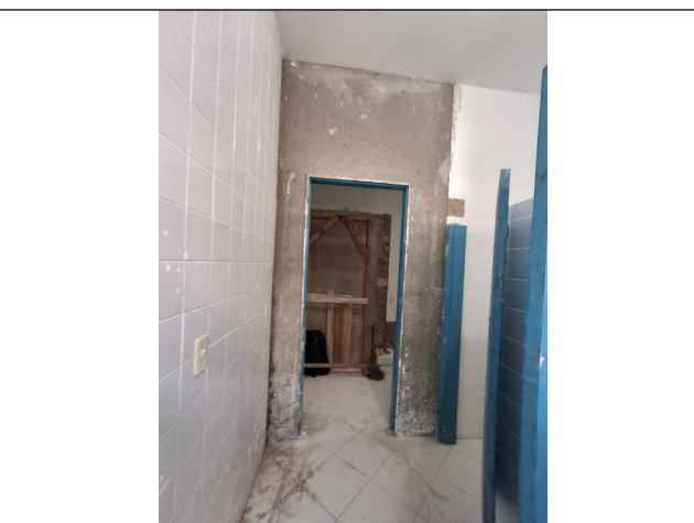
Foto 04: Demolição de revestimento cerâmico para adequação dos banheiros
