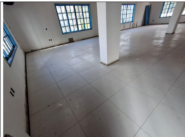
Foto 05: Assentamento de Piso cerâmico no salão
