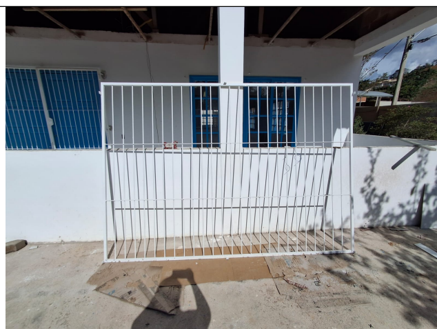
Foto 22: Pintura de Paredes esquadrias e grades
