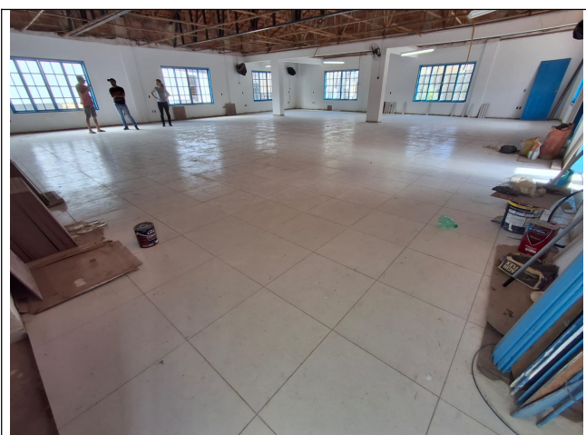
Foto 07: Assentamento de Piso cerâmico no salão
