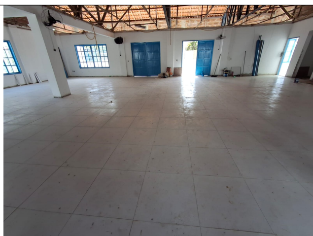
Foto 08: Assentamento de Piso cerâmico no salão
