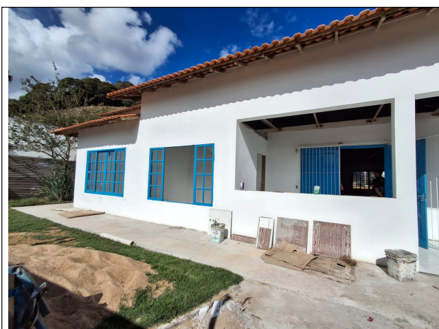
Foto 13: Pintura de Paredes esquadrias e grades
