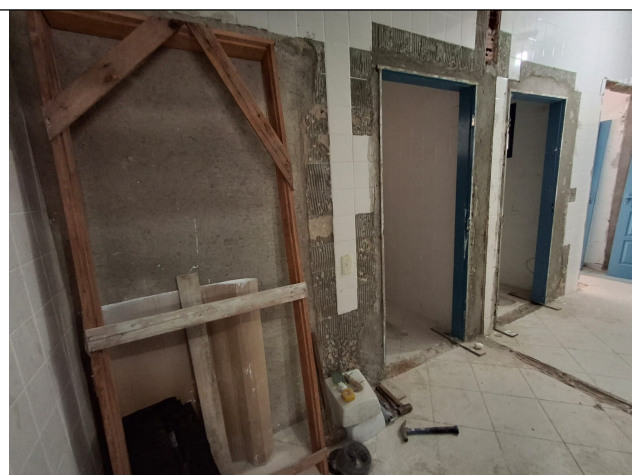
Foto 01: Demolição de revestimento cerâmico para adequação dos banheiros
