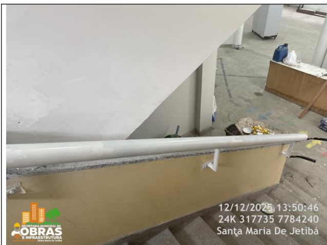
Foto 11: Corrimão de tubo de ferro galvanizado instalado.
