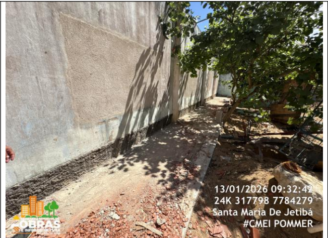
Foto 36: Fechamento do muro lateral e execução do passeio área do parquinho
