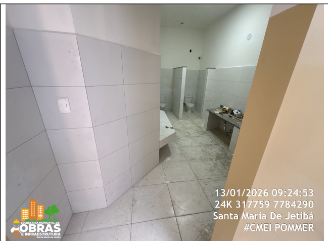
Foto 56: Assentamento de psio cerâmico nos banheiros do 3º pavimento
