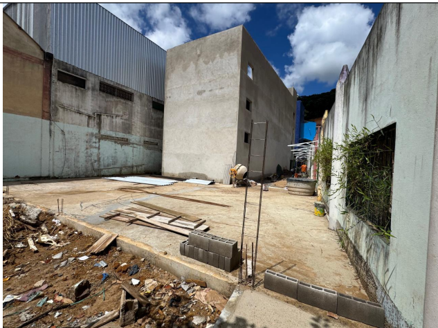
Foto 55: Piso concretado para área coberta do parquinho
