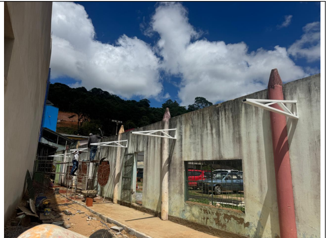
Foto 42: Execução da calçada e preparo para cobertura sobre passeio
