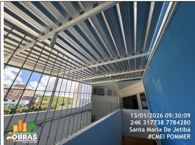
Foto 27: Pintura das grades rampa antiga e cobertura nova
