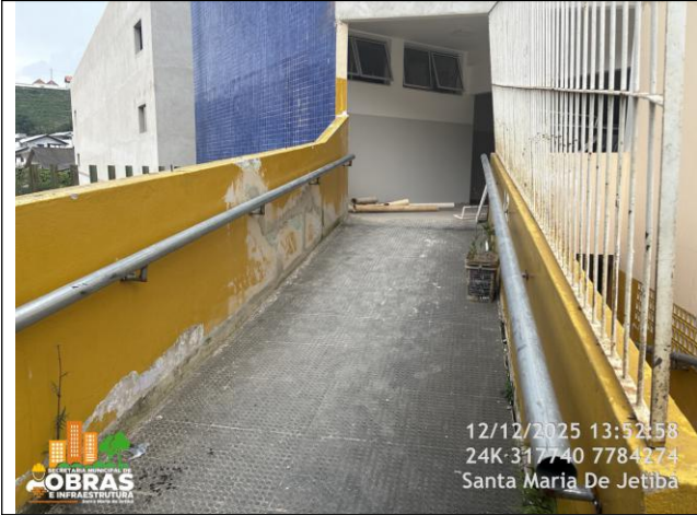
Foto 13: Corrimão de tubo de ferro galvanizado instalado.
