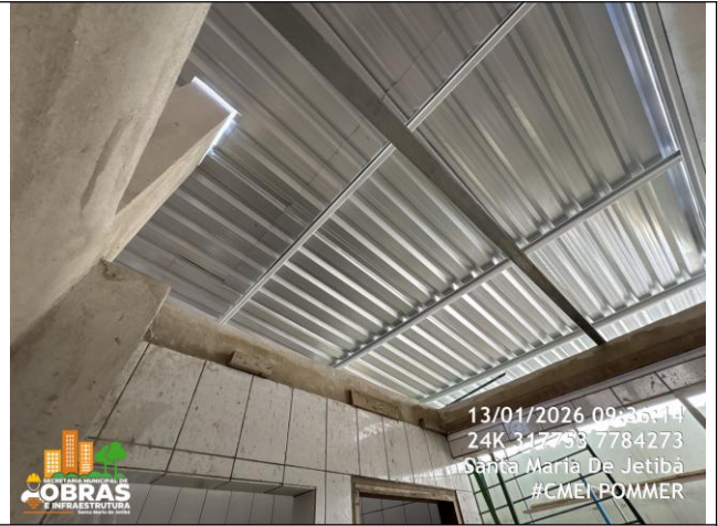
Foto 40: Cobertura nova sobre banheiros do parquinho perfis metálicos e telhas metálicas
