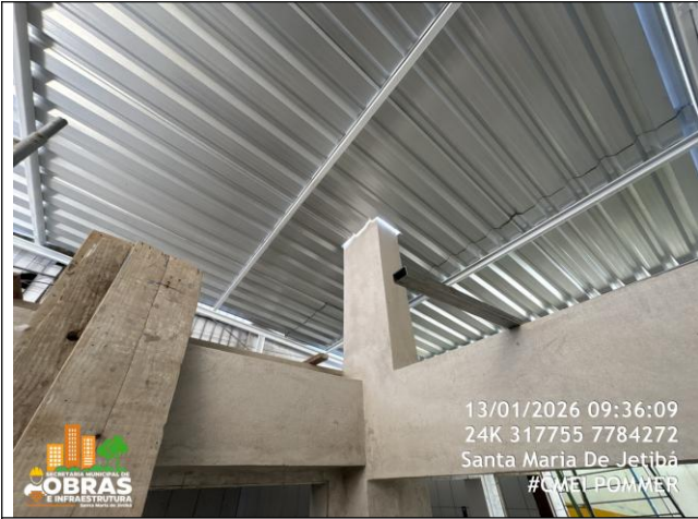
Foto 39: Cobertura nova sobre banheiros do parquinho perfis metálicos e telhas metálicas
