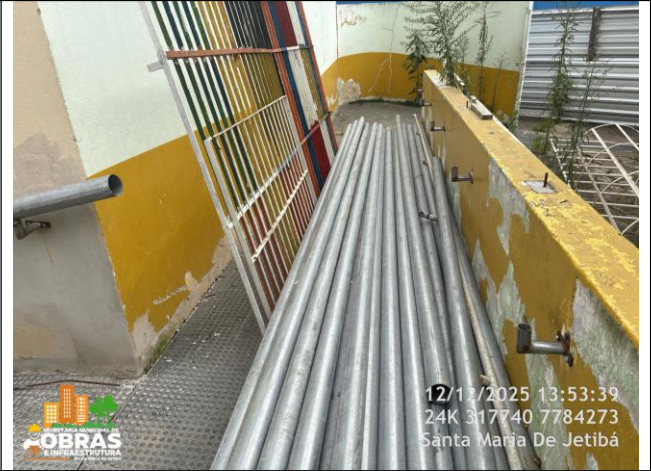
Foto 14: Corrimão de tubo de ferro galvanizado.
