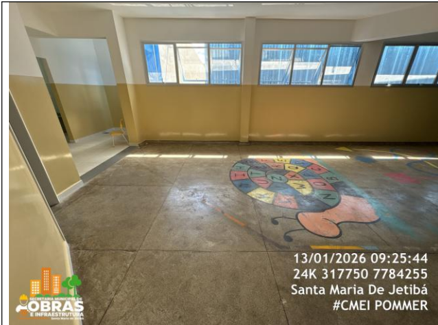
Foto 53: Polimento e aplicação de resina sobre piso granilite do 3º e 2º Pavimento
