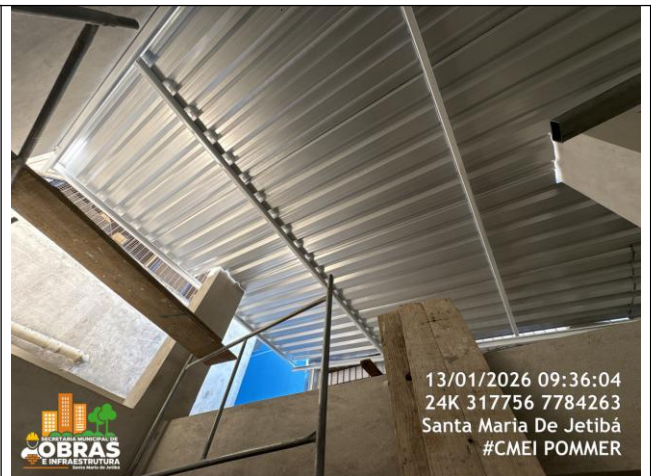
Foto 38: Cobertura nova sobre banheiros do parquinho perfis metálicos e telhas metálicas
