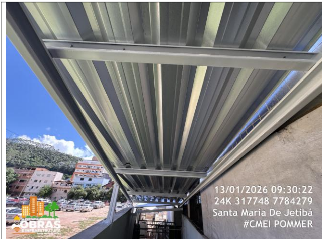
Foto 31: Cobertura nova de telhas de aço acesso ao parqueinho
