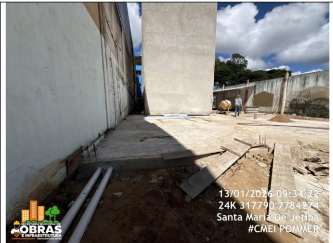
Foto 56: Piso concretado para área coberta do parquinho
