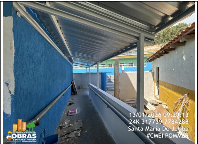
Foto 28: Instalação de corrimão e cobertura nova
