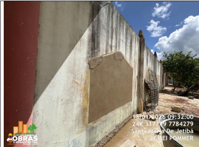
Foto 35: Fechamento do muro lateral e execução do passeio área do parquinho
