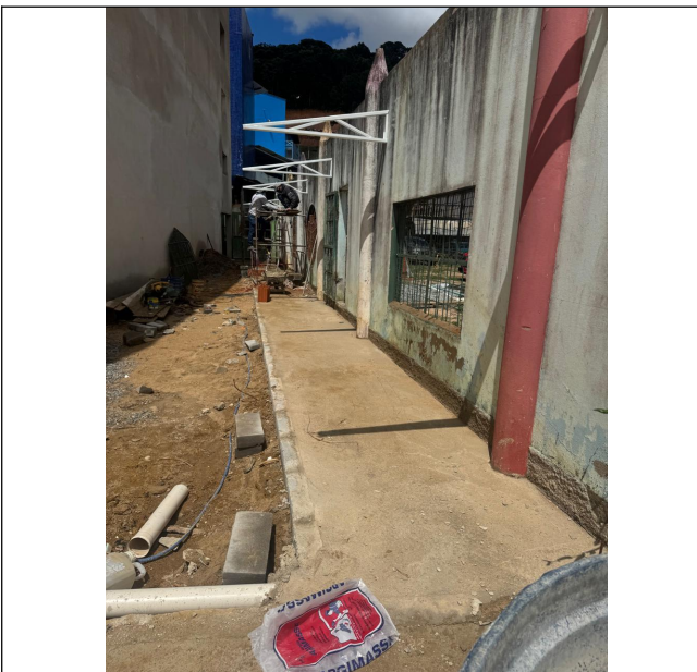
Foto 43: Execução da calçada e preparo para cobertura sobre passeio
