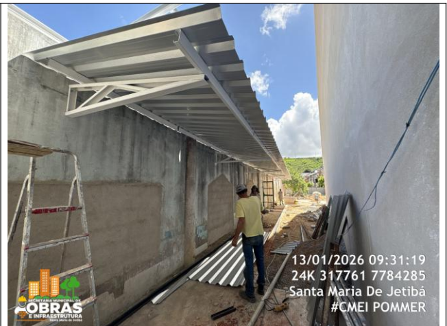
Foto 32: Fechamento do muro lateral e cobertura sobre passeio área do parqueinho
