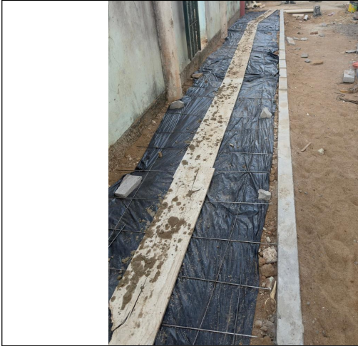
Foto 45: Execução do passeio acesso ao parquinho
