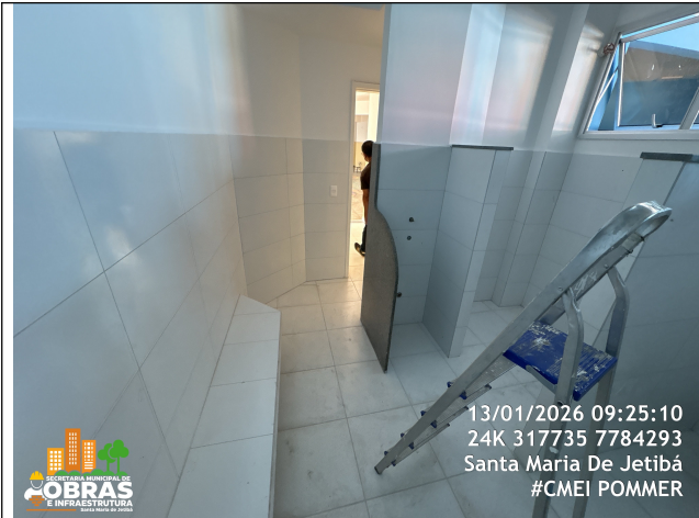
Foto 53: Assentamento de psio cerâmico nos banheiros do 3º pavimento
