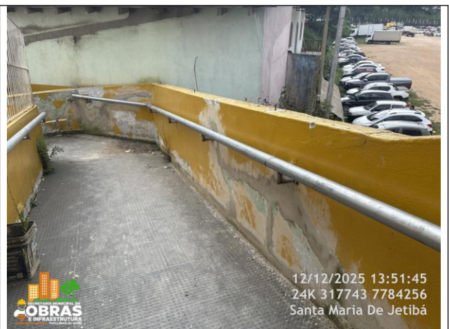
Foto 12: Corrimão de tubo de ferro galvanizado instalado.
