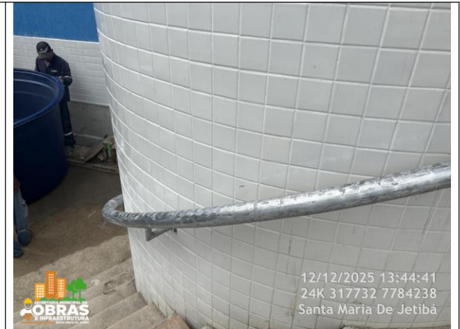
Foto 04: Corrimão de tubo de ferro galvanizado instalado.
