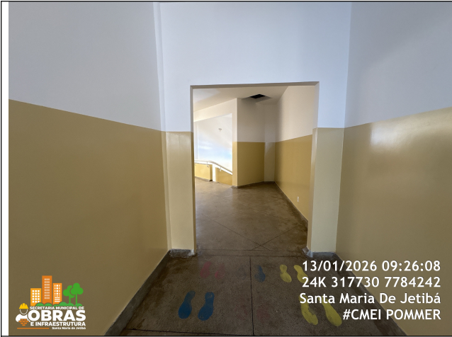
Foto 57: Polimento e aplicação de resina sobre piso granilite do 3º e 2º Pavimento
