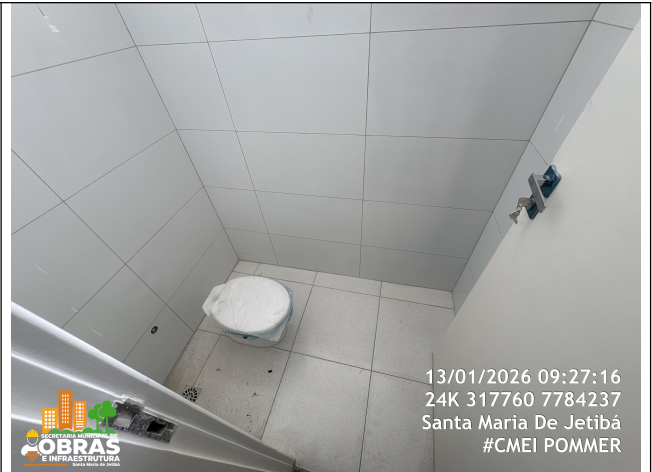
Foto 54: Assentamento de psio cerâmico nos banheiros do 3º pavimento
