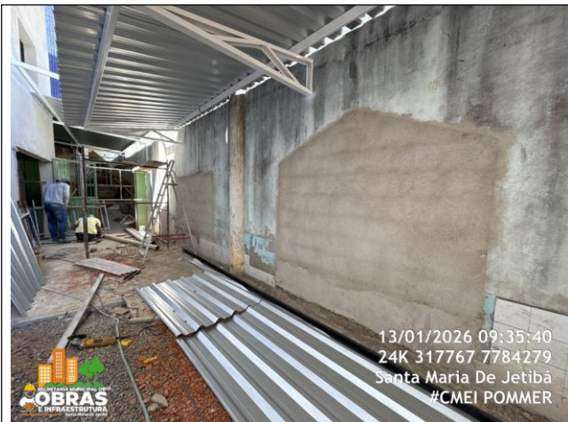
Foto 37: Fechamento do muro lateral e cobertura sobre passeio área do parquinho
