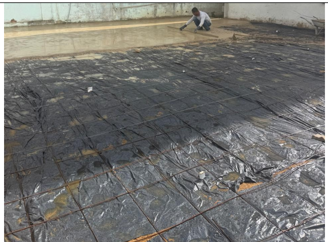
Foto 50: Execução do piso concretado na área do parquinho para atividades em área coberta
