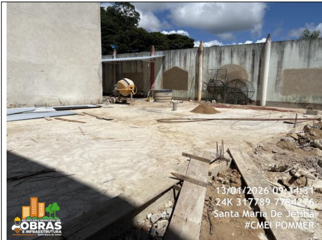
Foto 51: Piso concretado para área coberta do parquinho
