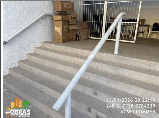
Foto 15: Corrimão de tubo de ferro galvanizado instalado.
