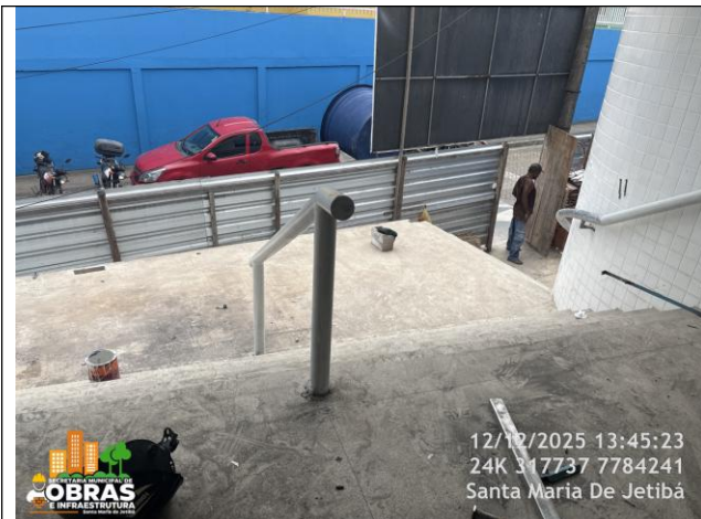
Foto 05: Corrimão de tubo de ferro galvanizado instalado.
