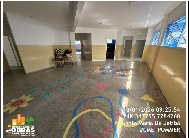
Foto 54: Polimento e aplicação de resina sobre piso granilite do 3º e 2º Pavimento
