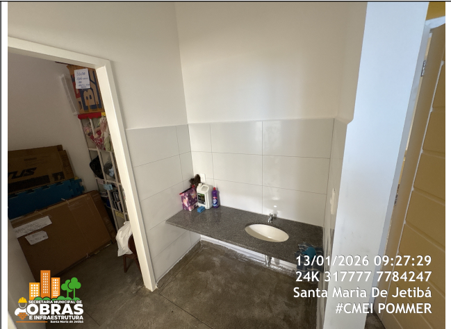
Foto 62: Assentamento de piso cerâmico e troca de cuba da bancada lavatório 3º pavimento
