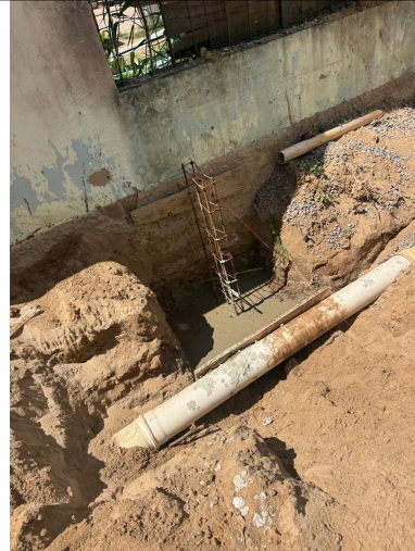
Foto 52: Execução de sapatas para fundação do piso concretado da área coberta parquinho
