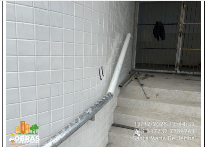
Foto 02: Corrimão de tubo de ferro galvanizado instalado.
