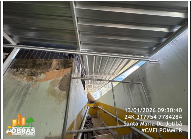
Foto 32: Cobertura nova de telhas de aço acesso ao parqueinho
