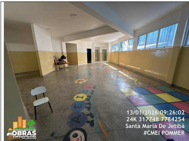
Foto 55: Polimento e aplicação de resina sobre piso granilite do 3º e 2º Pavimento
