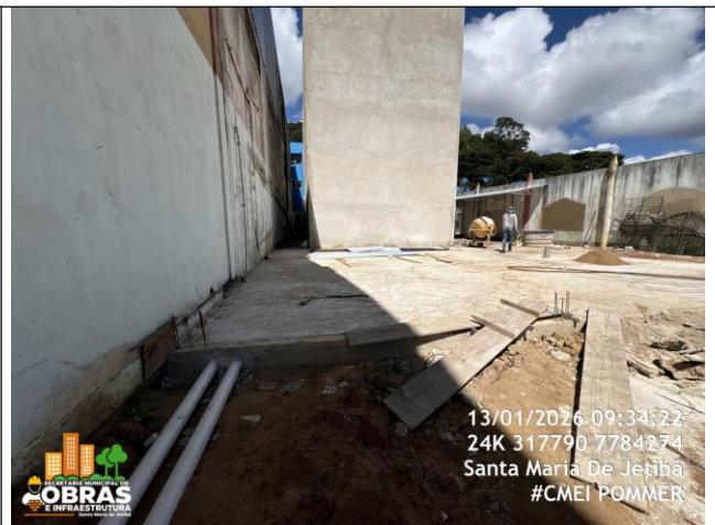
Foto 54: Piso concretado para área coberta do parquinho
