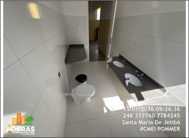
Foto 52: Assentamento de psio cerâmico nos banheiros do 3º pavimento
