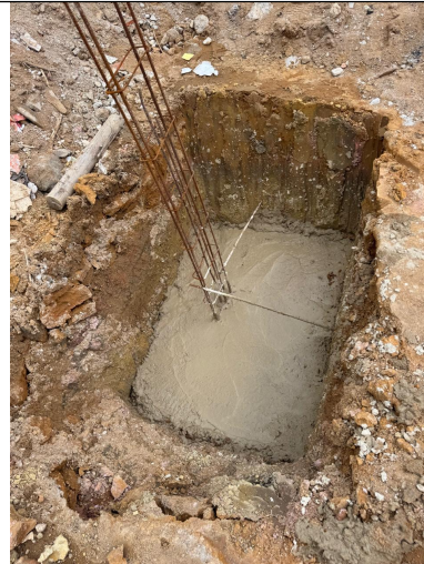
Foto 54: Execução de sapatas para fundação do piso concretado da área coberta parquinho
