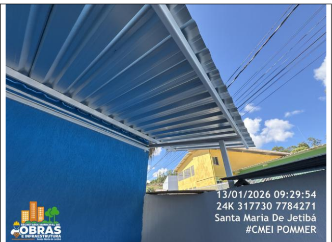
Foto 30: Pintura e cobertura nova acesso secundário a rampa antiga
