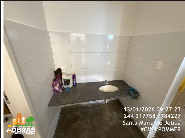
Foto 61: Assentamento de piso cerâmico e troca de cuba da bancada lavatório 3º pavimento
