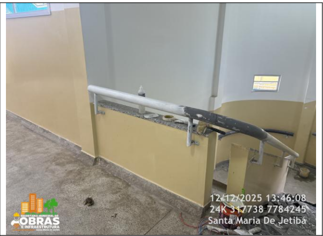
Foto 10: Corrimão de tubo de ferro galvanizado instalado.
