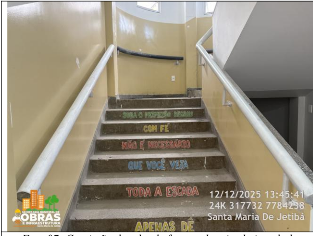
Foto 07: Corrimão de tubo de ferro galvanizado instalado.
