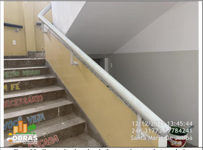
Foto 08: Corrimão de tubo de ferro galvanizado instalado.
