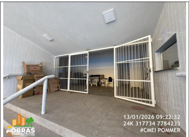
Foto 18: Portão de Ferro da entrada principal
