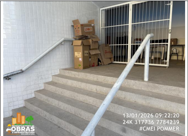
Foto 16: Corrimão de tubo de ferro galvanizado instalado.
