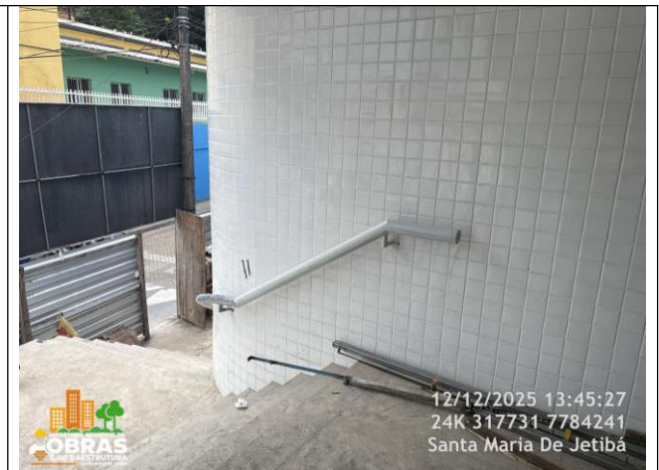
Foto 06: Corrimão de tubo de ferro galvanizado instalado.
