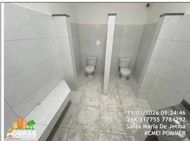
Foto 55: Assentamento de psio cerâmico nos banheiros do 3º pavimento
