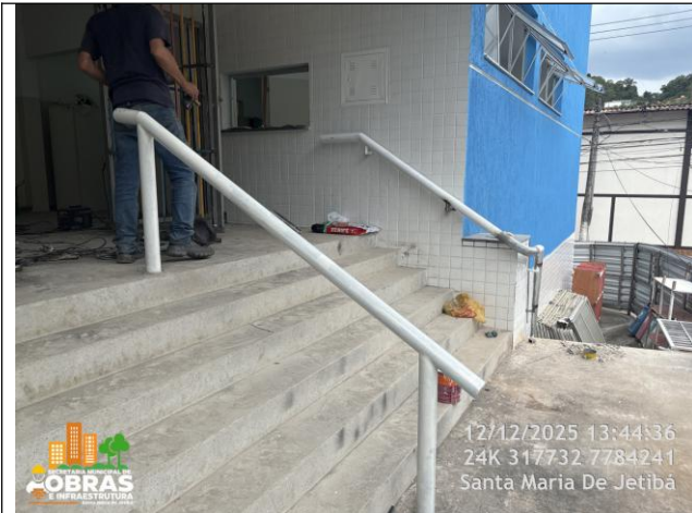
Foto 03: Corrimão de tubo de ferro galvanizado instalado.
