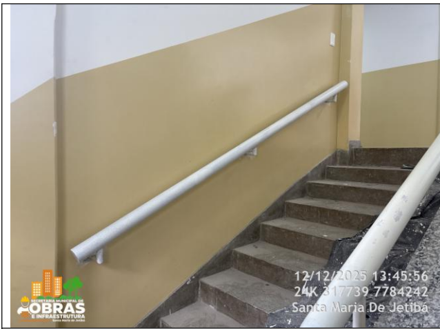
Foto 09: Corrimão de tubo de ferro galvanizado instalado.
