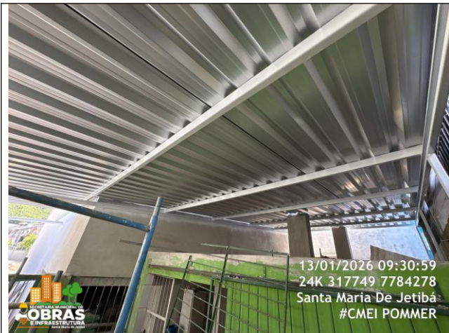
Foto 31: Cobertura nova de telhas de aço acesso ao parqueinho e banheiros do parqueinho
