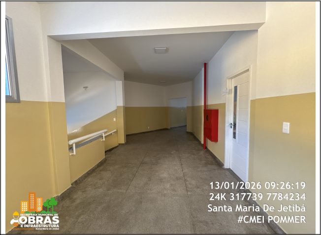
Foto 58: Polimento e aplicação de resina sobre piso granilite do 3º e 2º Pavimento
