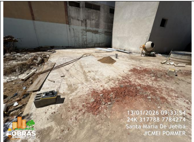
Foto 52: Piso concretado para área coberta do parquinho
