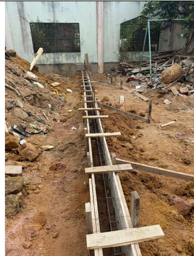
Foto 48: Execução da fundação para execução do piso
