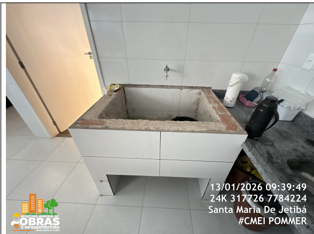
Foto 63: Execução de base de alvenaria para instalação de cuba de inox para panelão
