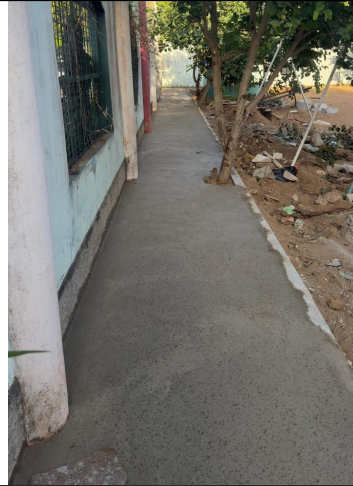
Foto 46: Execução do passeio acesso ao parquinho
