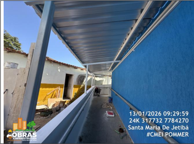
Foto 31: Instalação de corrimão e cobertura nova Pintura da fachada lateral
