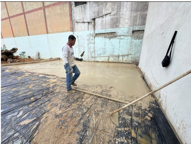
Foto 49: Execução do piso concretado na área do parquinho para atividades em área coberta
