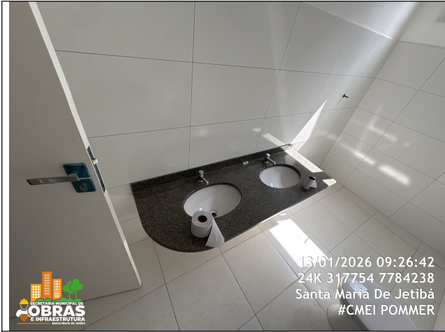
Foto 51: Assentamento de psio cerâmico nos banheiros do 3º pavimento
