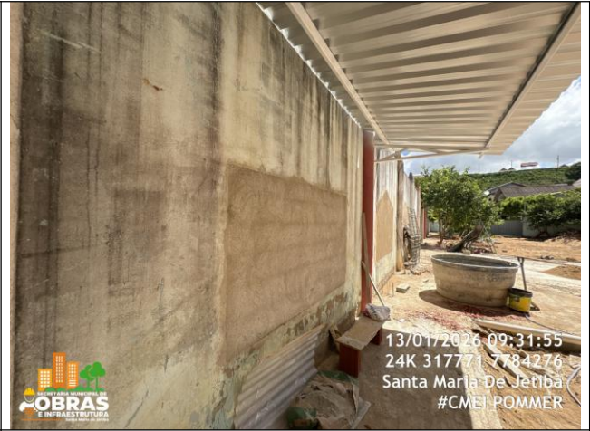
Foto 34: Fechamento do muro lateral e cobertura sobre passeio área do parquinho
