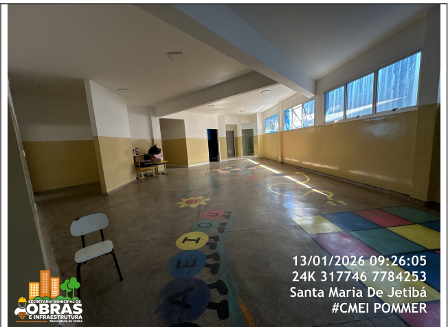
Foto 56: Polimento e aplicação de resina sobre piso granilite do 3º e 2º Pavimento
