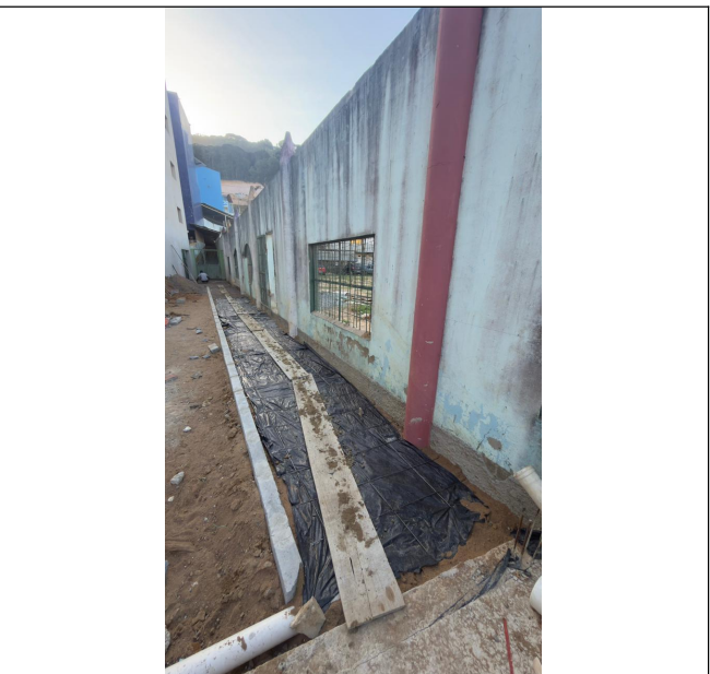
Foto 44: Execução da calçada e preparo para cobertura sobre passeio
