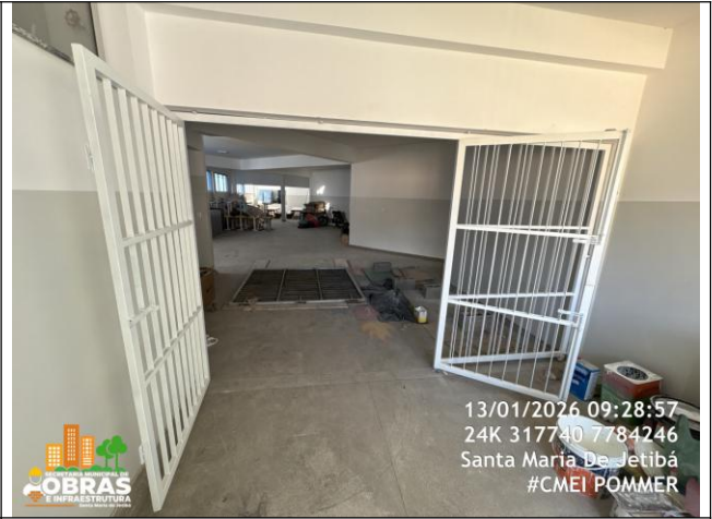
Foto 26: Portão de ferro do acesso lateral e rampa antiga
