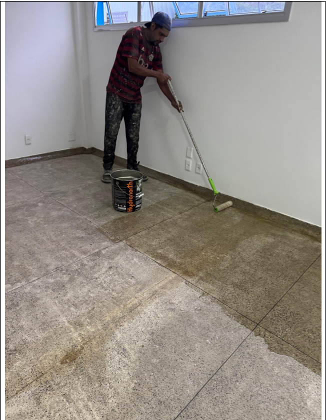
Foto 60: Polimento e aplicação de resina sobre piso granilite do 3º e 2º Pavimento
