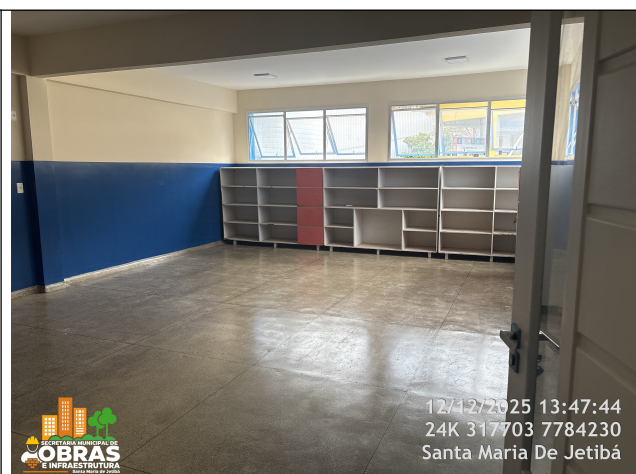
Foto 22: Pintura completa das salas de aula, piso paredes e tetos
