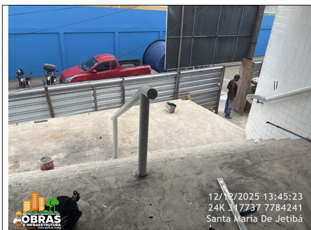
Foto 05: Corrimão de tubo de ferro galvanizado instalado.
