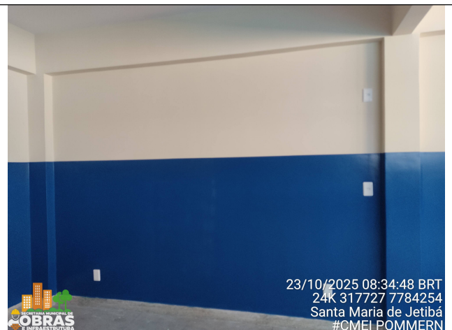
Foto 28: Pintura completa das salas de aula, piso paredes e tetos
