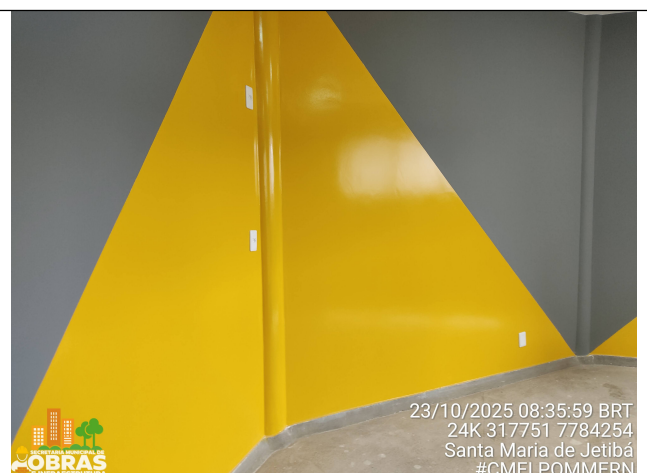
Foto 30: Pintura completa da biblioteca, piso paredes e tetos
