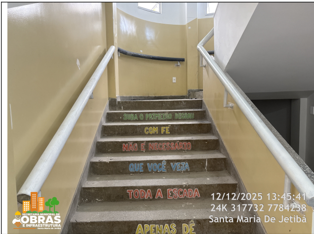
Foto 07: Corrimão de tubo de ferro galvanizado instalado.
