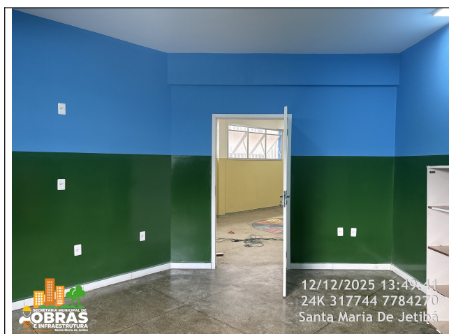
Foto 23: Pintura completa das salas de aula, piso paredes e tetos
