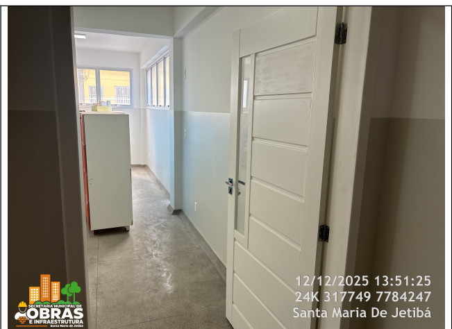
Foto 32: Lixamento e Pintura das portas
