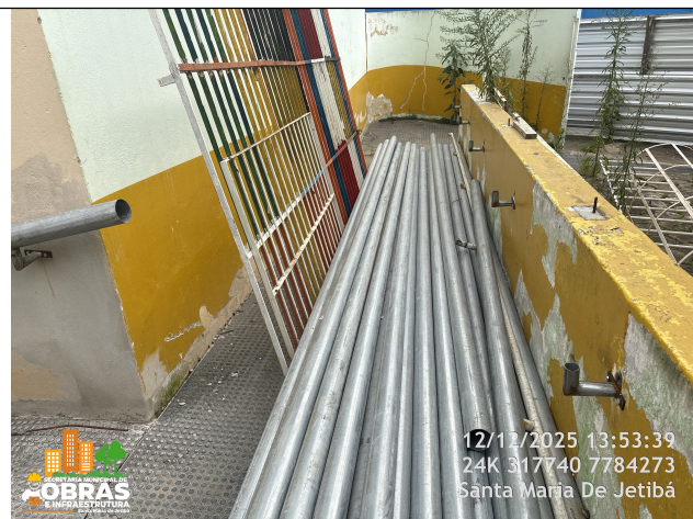
Foto 14: Corrimão de tubo de ferro galvanizado.
