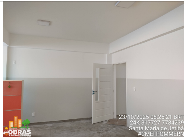
Foto 25: Pintura completa das salas de aula, piso paredes e tetos
