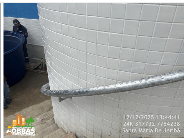
Foto 04: Corrimão de tubo de ferro galvanizado instalado.
