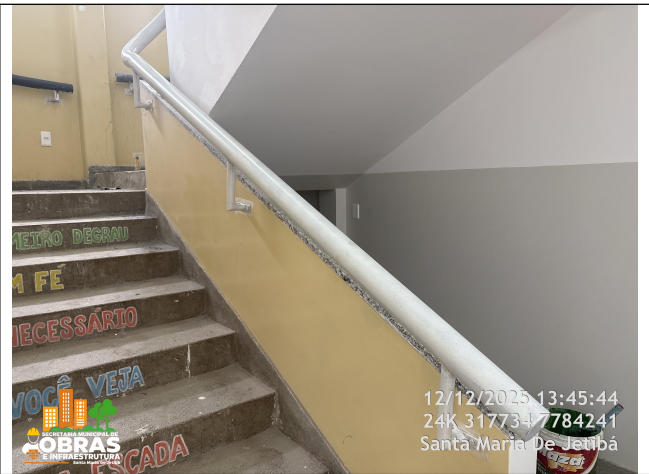
Foto 08: Corrimão de tubo de ferro galvanizado instalado.
