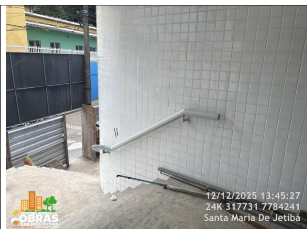
Foto 06: Corrimão de tubo de ferro galvanizado instalado.
