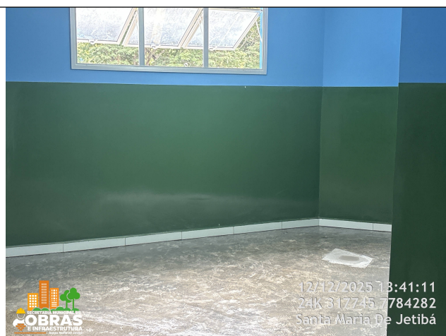
Foto 18: Pintura completa das salas de aula, piso paredes e tetos
