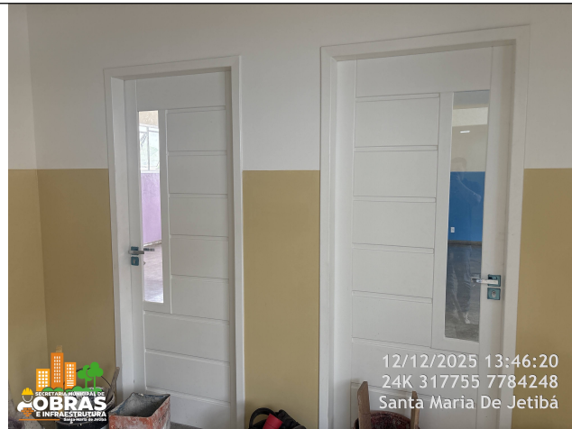
Foto 31: Lixamento e Pintura das portas
