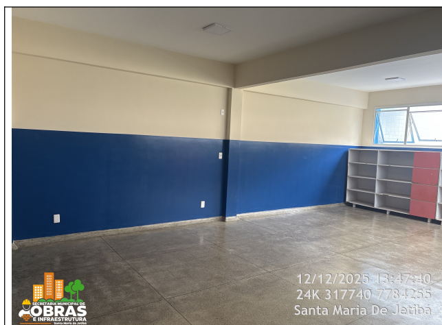
Foto 21: Pintura completa das salas de aula, piso paredes e tetos
