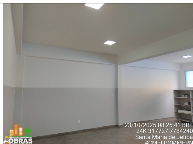
Foto 29: Pintura completa das salas de aula, piso paredes e tetos
