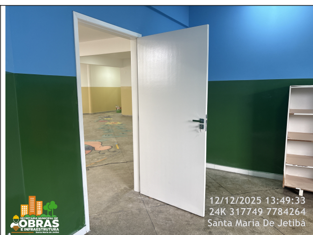
Foto 24: Pintura completa das salas de aula, piso paredes e tetos
