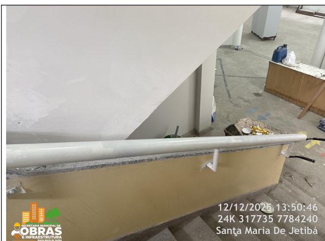
Foto 11: Corrimão de tubo de ferro galvanizado instalado.
