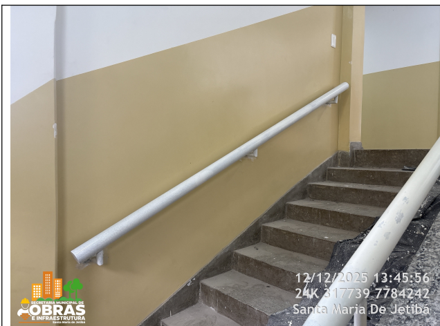
Foto 09: Corrimão de tubo de ferro galvanizado instalado.
