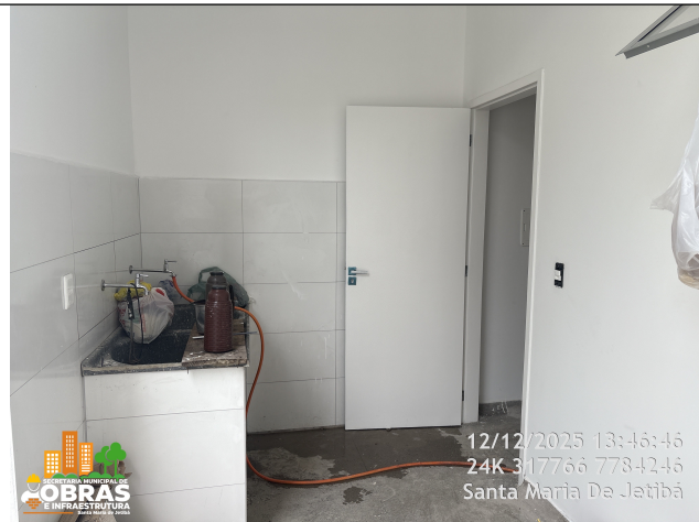
Foto 31: Lixamento e Pintura das portas
