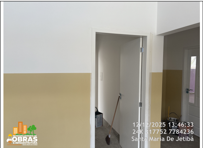
Foto 32: Lixamento e Pintura das portas
