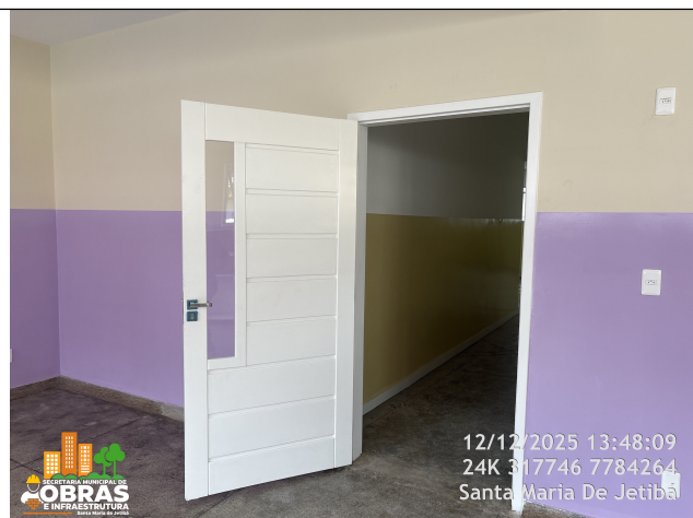
Foto 31: Lixamento e Pintura das portas
