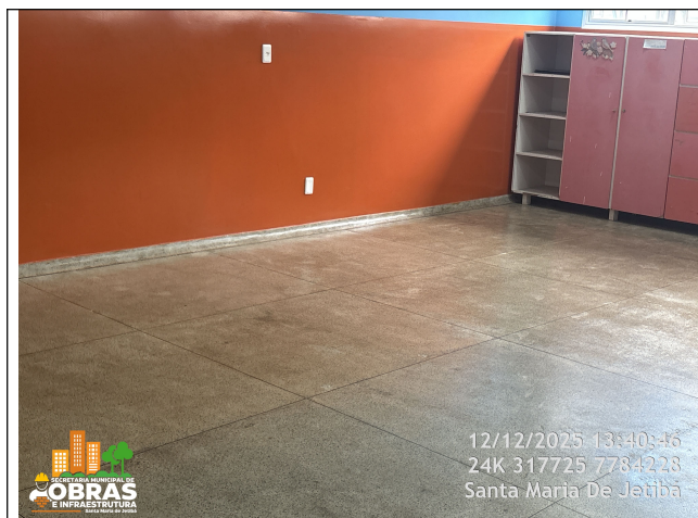
Foto 15: Pintura das paredes e piso resinado
