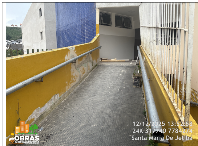
Foto 13: Corrimão de tubo de ferro galvanizado instalado.
