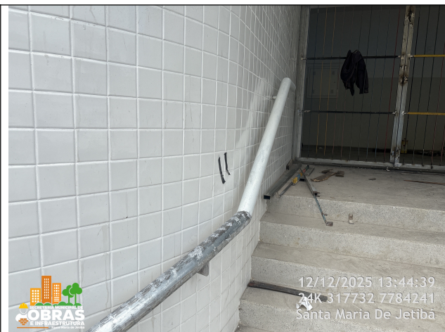
Foto 02: Corrimão de tubo de ferro galvanizado instalado.
