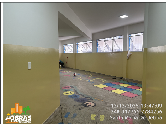
Foto 20: Pintura dos corredores e pátio interno da escola.
