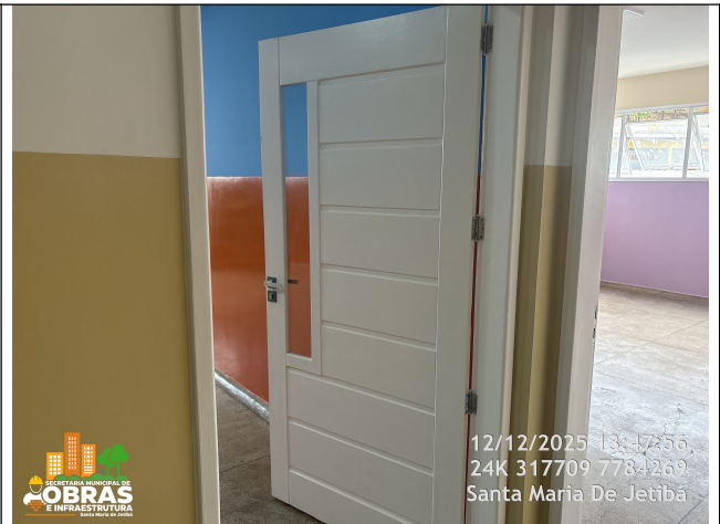
Foto 32: Lixamento e Pintura das portas
