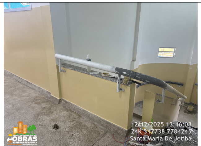
Foto 10: Corrimão de tubo de ferro galvanizado instalado.
