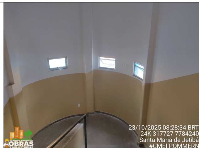
Foto 27: Pintura completa das salas de aula, piso paredes e tetos
