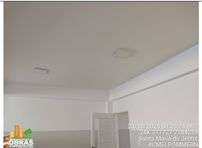
Foto 26: Pintura completa das salas de aula, piso paredes e tetos
