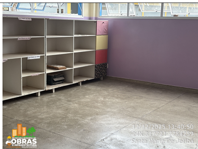
Foto 16: Pintura das paredes e piso resinado
