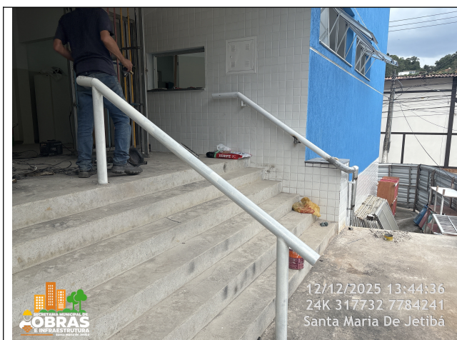
Foto 03: Corrimão de tubo de ferro galvanizado instalado.
