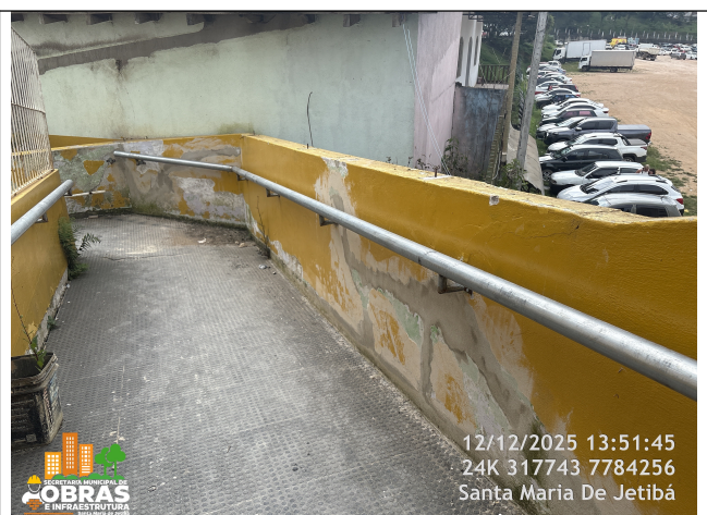
Foto 12: Corrimão de tubo de ferro galvanizado instalado.
