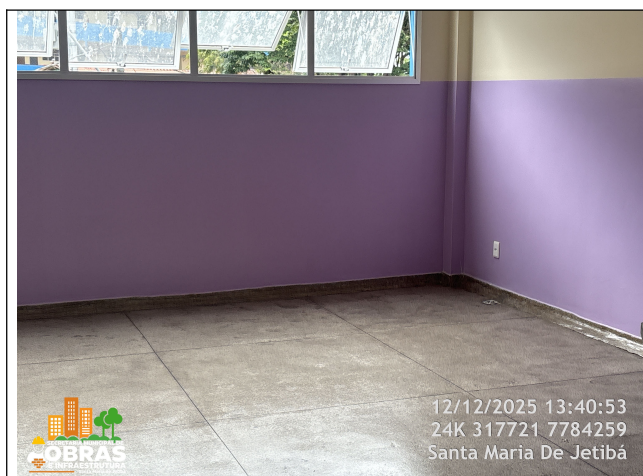
Foto 17: Pintura completa das salas de aula, piso paredes e tetos
