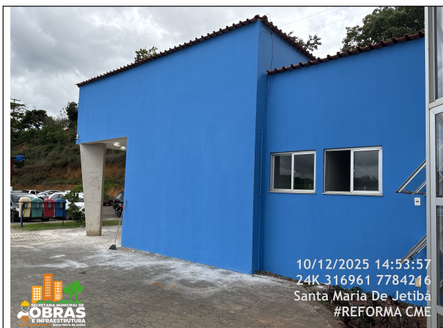
Foto 13: Pintura nova das paredes externas.
