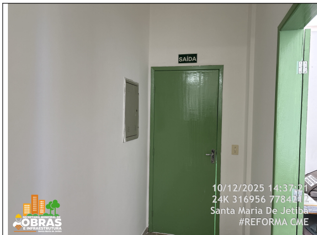
Foto 35: Pintura nova das parede e portas Internas.
