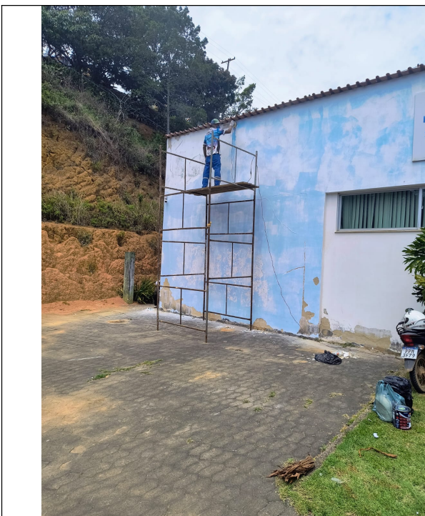
Foto 03: Lixamento e remoção de pintura antiga das paredes, reparo de trincas.
