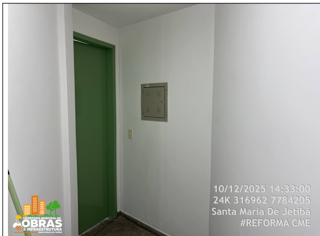
Foto 29: Pintura nova das paredes e Portas Internas - Hall -.
