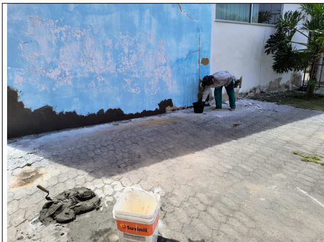
Foto 51: Tratamento e Reparo de Trincas
