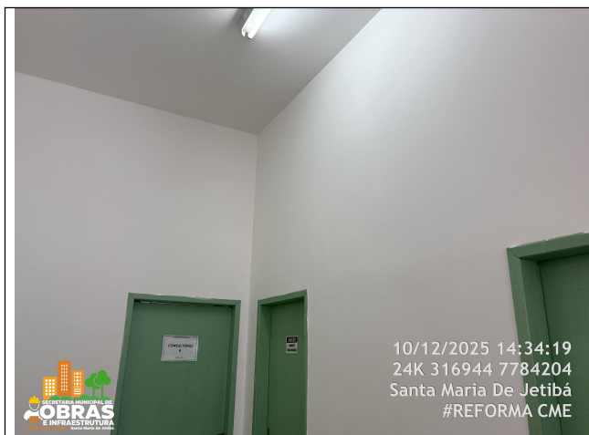
Foto 31: Pintura nova das paredes, teto e Portas Internas - Recepção -.
