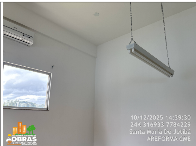
Foto 42: Pintura nova das paredes e teto Internas - Consultório -
