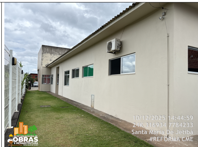
Foto 18: Pintura nova das paredes externas.
