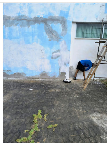
Foto 08: Lixamento e remoção de pintura antiga das paredes, reparo de trincas.
