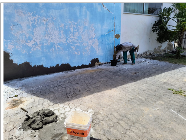
Foto 01: Lixamento e remoção de pintura antiga das paredes, reparo de trincas.
