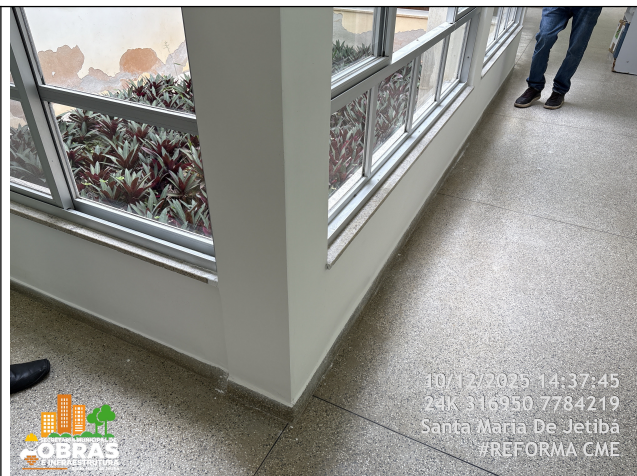
Foto 36: Pintura nova das paredes internas dos corredores de acesso aos consultórios.
