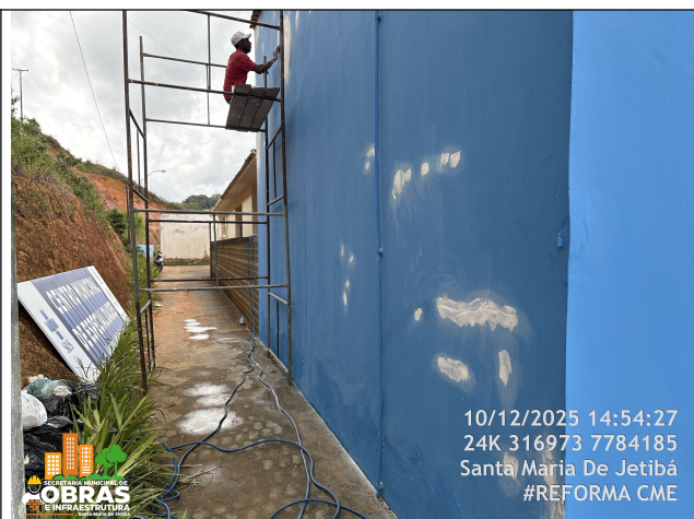
Foto 14: Pintura nova das paredes externas.
