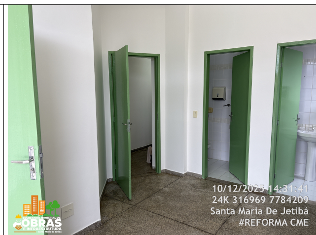
Foto 26: Pintura nova das paredes e Portas Internas - Hall e Banheiros -.
