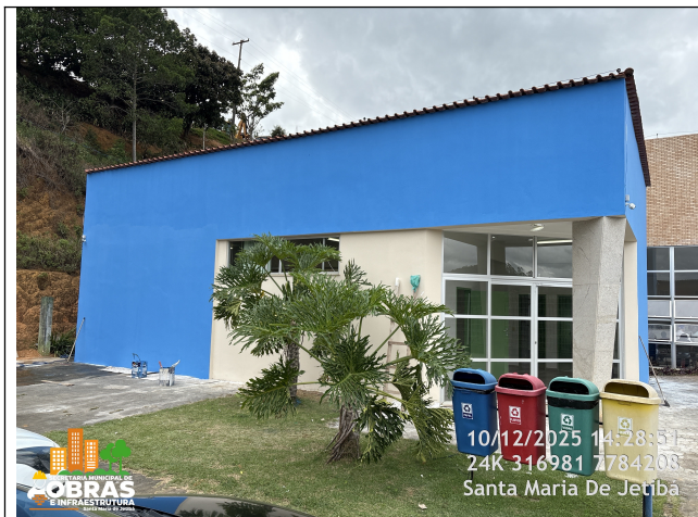
Foto 11: Pintura nova das paredes externas.
