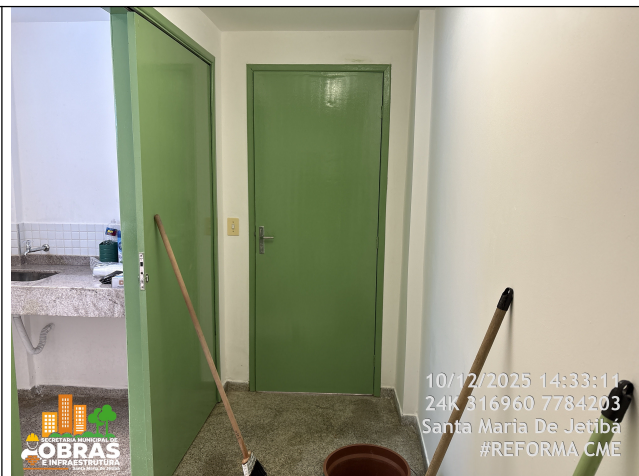
Foto 30: Pintura nova das paredes e Portas Internas - Depósito e Hall -.
