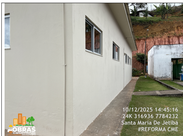
Foto 19: Pintura nova das paredes externas.
