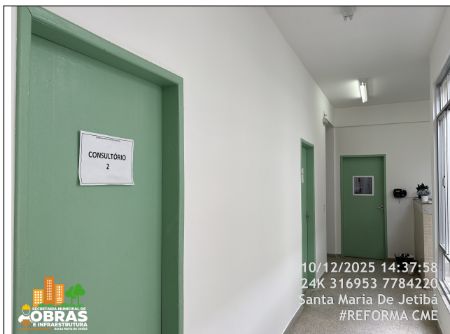
Foto 37: Pintura nova das parede e portas Internas.
