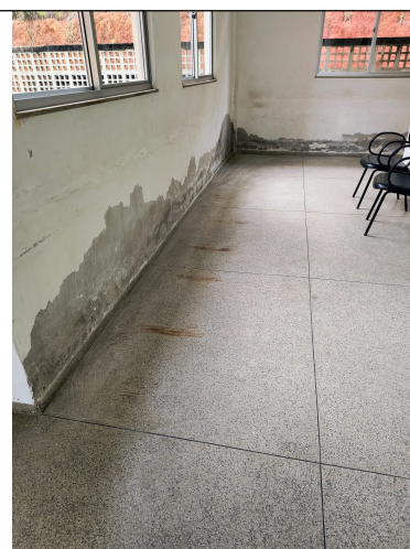
Foto 10: Lixamento e remoção de pintura antiga das paredes, reparo de trincas.
