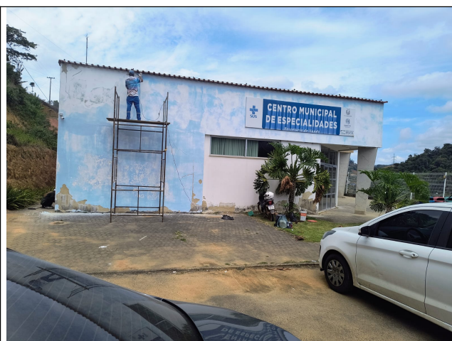
Foto 02: Lixamento e remoção de pintura antiga das paredes, reparo de trincas.
