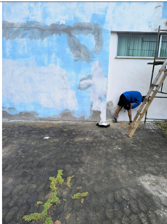
Foto 48: Tratamento e Reparo de Trincas
