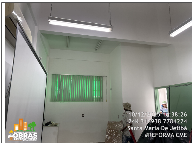
Foto 39: Pintura nova das parede e portas Internas - Consultório
