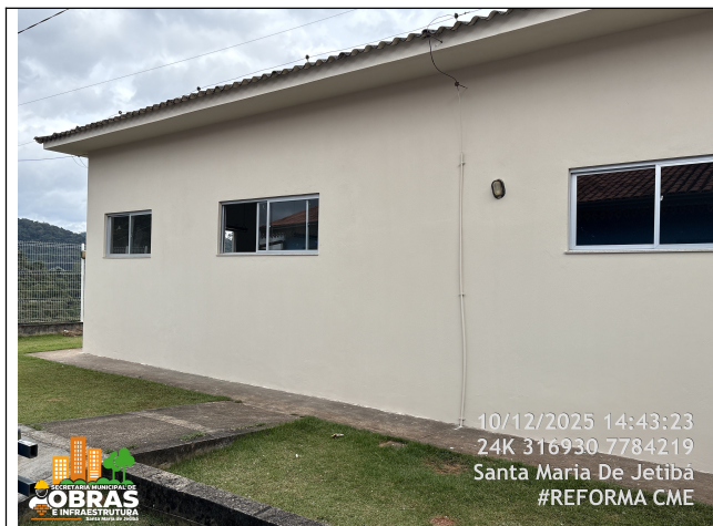
Foto 17: Pintura nova das paredes externas.
