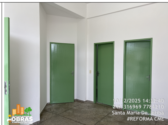
Foto 28: Pintura nova das paredes e Portas Internas - Hall e Banheiros -.
