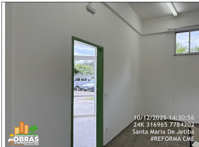
Foto 23: Pintura nova das paredes Internas - Auditório -.
