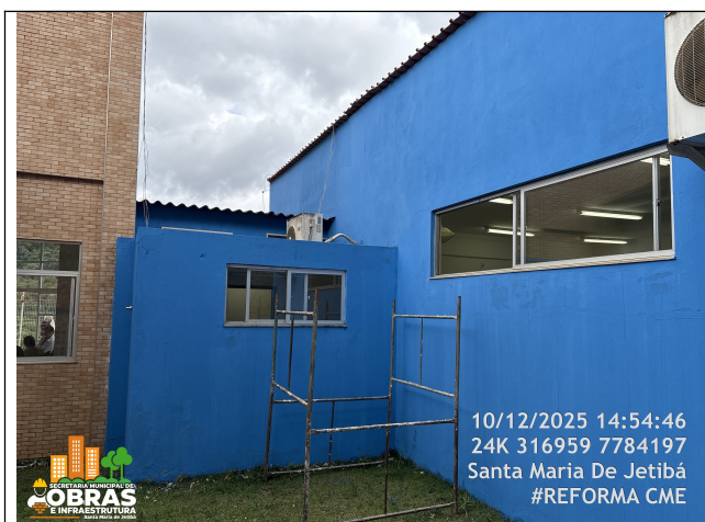
Foto 15: Pintura nova das paredes externas.
