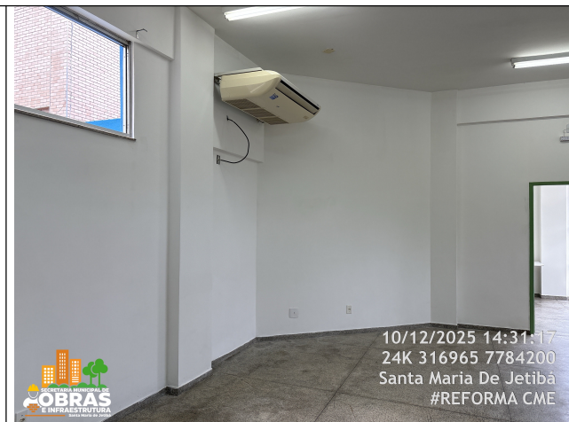
Foto 24: Pintura nova das paredes Internas - Auditório -.
