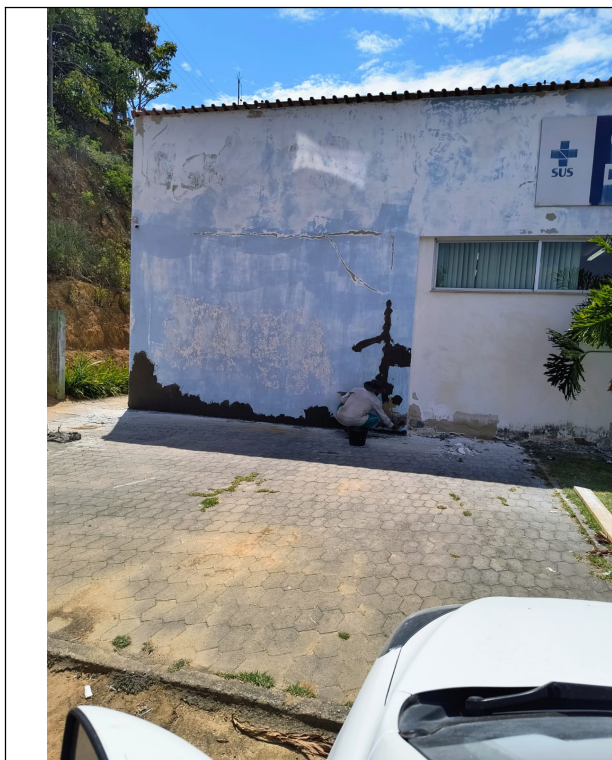
Foto 49: Tratamento e Reparo de Trincas
