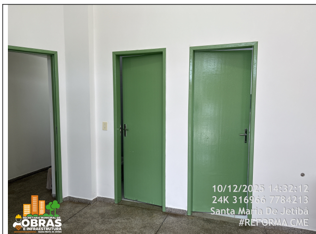
Foto 27: Pintura nova das paredes e Portas Internas - Hall e Banheiros -.
