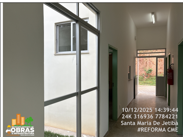
Foto 44: Pintura nova das paredes, teto e portas Internas - Corredor -
