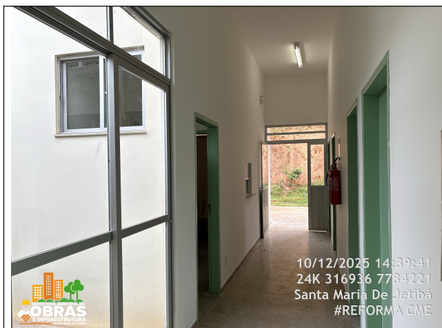
Foto 43: Pintura nova das paredes, teto e portas Internas - Corredor -
