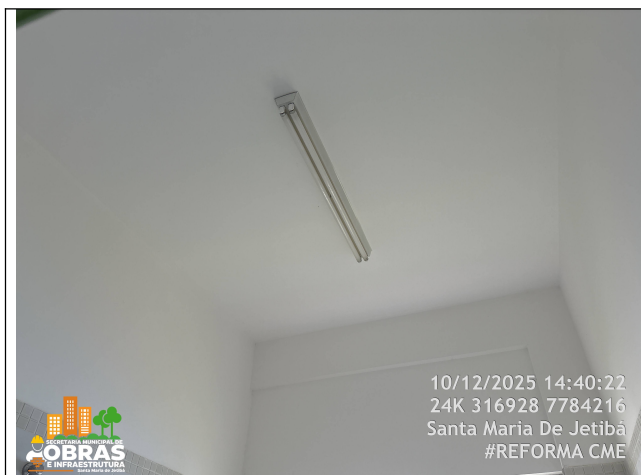
Foto 45: Pintura nova do Teto - Consultórios -
