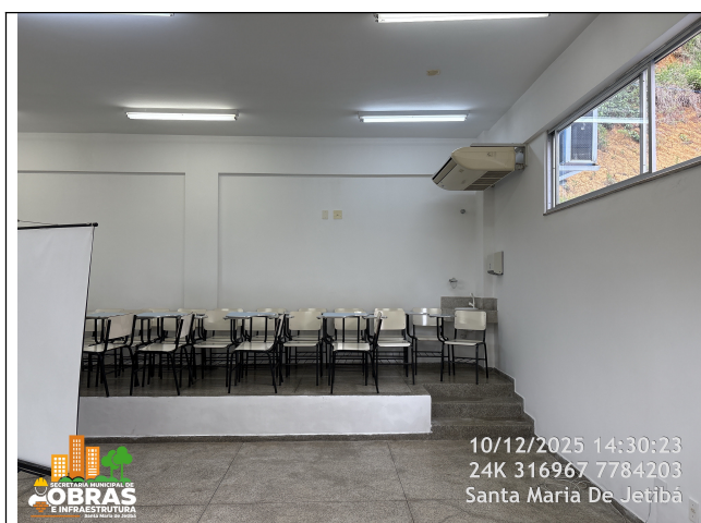
Foto 21: Pintura nova das paredes Internas - Auditório -.
