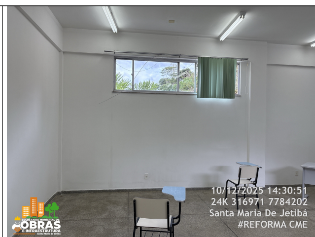
Foto 22: Pintura nova das paredes Internas - Auditório -.
