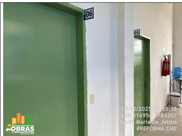
Foto 32: Pintura nova das paredes e Portas Internas - Consultórios -.
