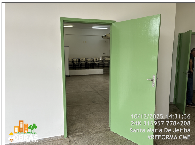
Foto 25: Pintura nova das Portas Internas - Auditório -.
