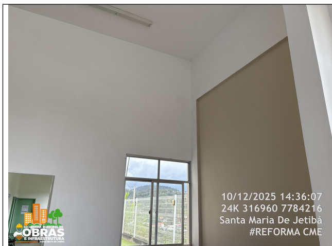
Foto 33: Pintura nova das parede e teto Internas - Recepção -.
