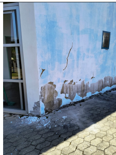
Foto 06: Lixamento e remoção de pintura antiga das paredes, reparo de trincas.
