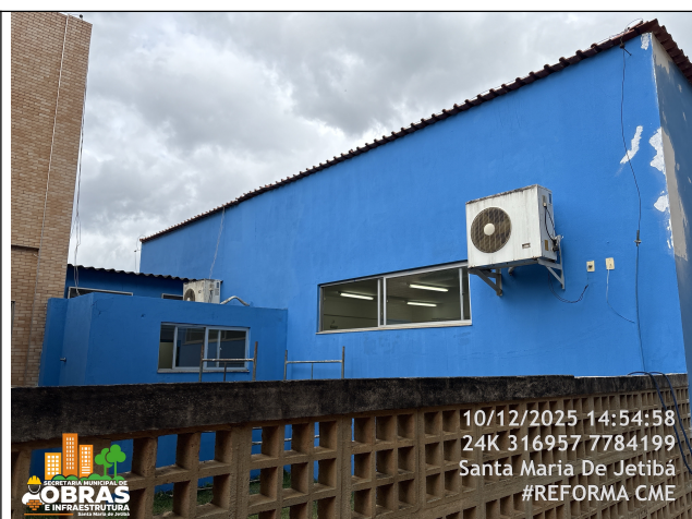
Foto 16: Pintura nova das paredes externas.
