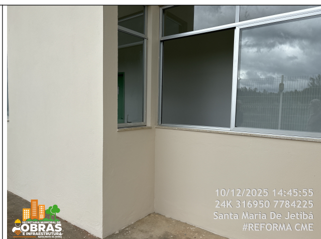
Foto 20: Pintura nova das paredes externas.
