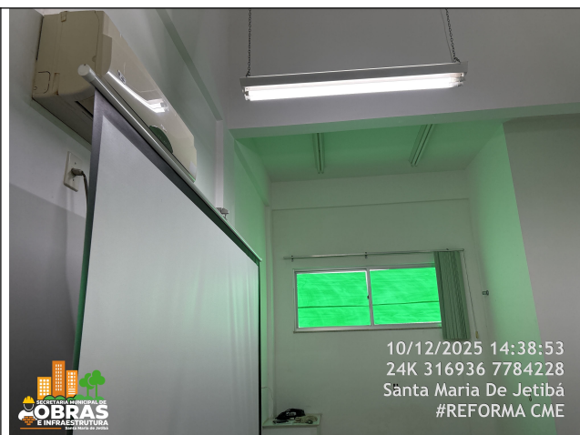
Foto 40: Pintura nova das parede e portas Internas - Consultório
