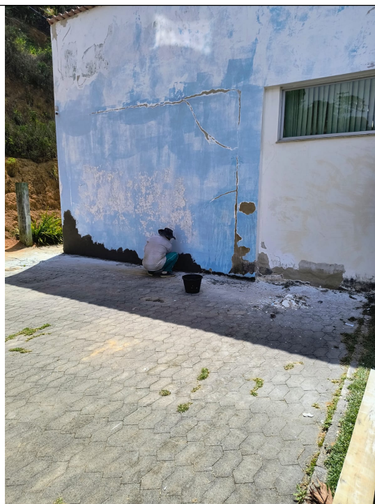
Foto 04: Lixamento e remoção de pintura antiga das paredes, reparo de trincas.
