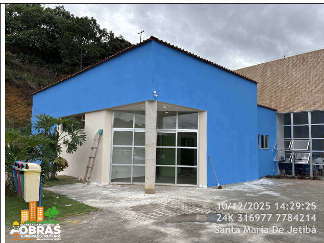
Foto 12: Pintura nova das paredes externas.
