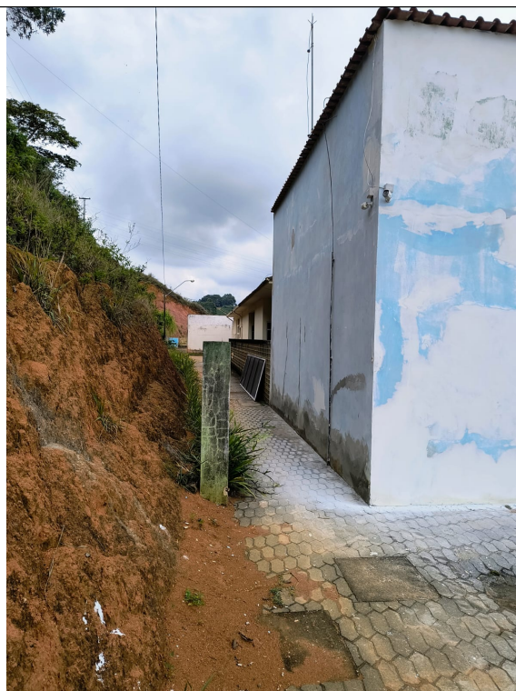
Foto 50: Tratamento e Reparo de Trincas
