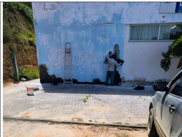
Foto 52: Tratamento e Reparo de Trincas
