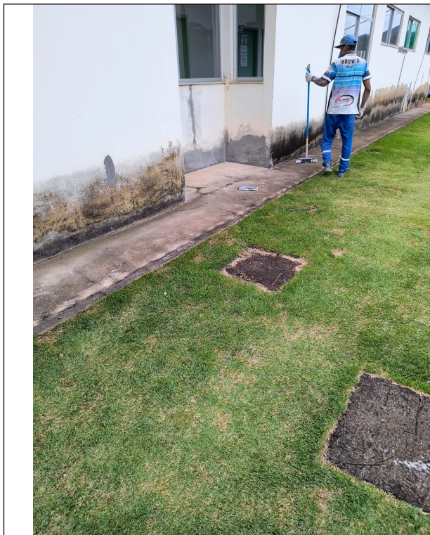
Foto 47: Tratamento e Reparo de Trincas
