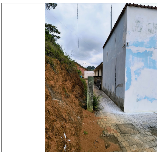
Foto 07: Lixamento e remoção de pintura antiga das paredes, reparo de trincas.
