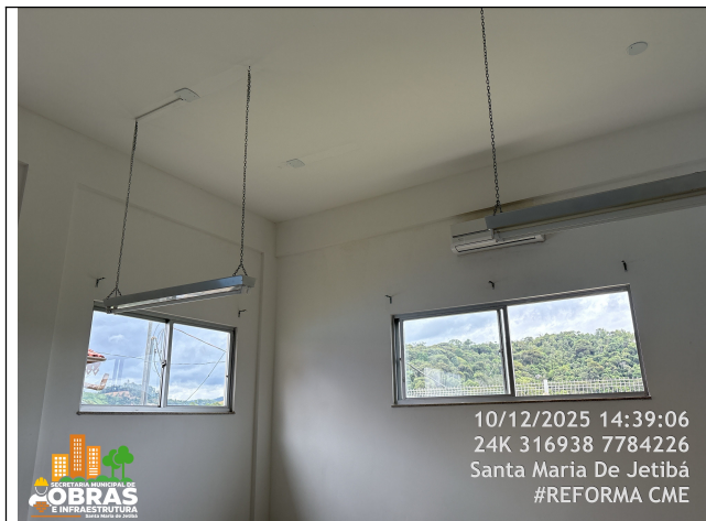
Foto 41: Pintura nova das paredes e teto Internas - Consultório -
