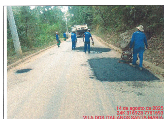
Foto 05: Serviço de tapa buraco no Trecho 2
