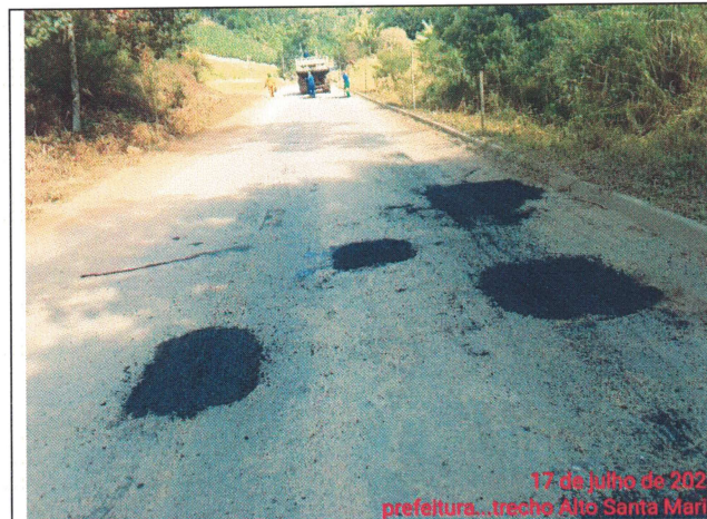
Foto 45: Serviço de tapa buraco no Trecho 06
