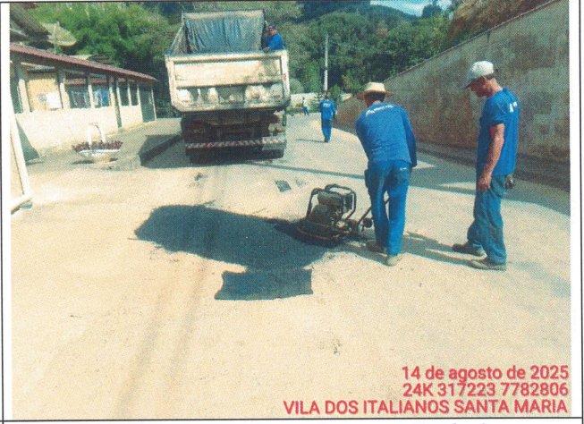
Foto 02: Serviço de tapa buraco no Trecho 2
