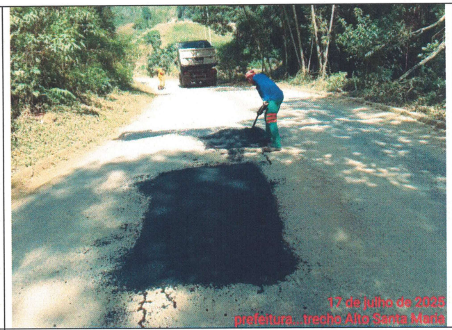
Foto 40: Serviço de tapa buraco no Trecho 06
