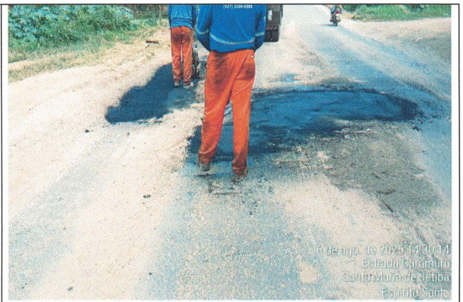
Foto 18: Serviço de tapa buraco no Trecho 15
