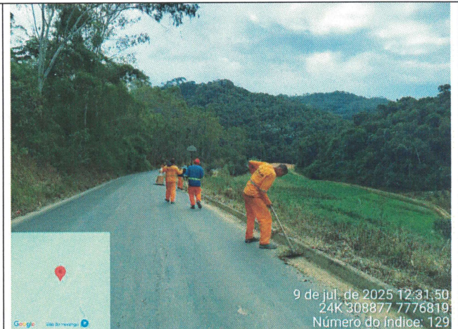
Foto 14: Serviço de roçagem e limpeza no Trecho 6
