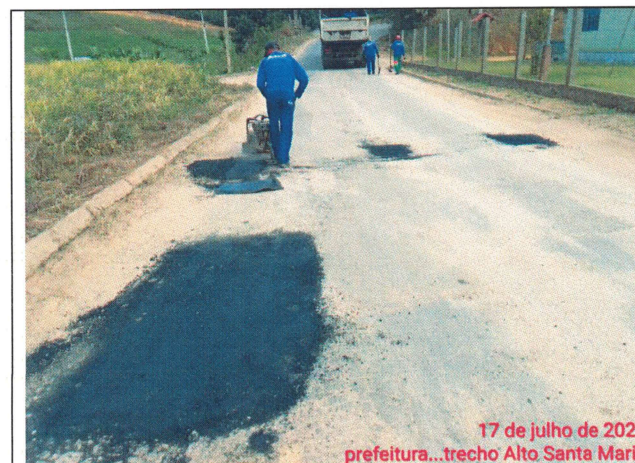
Foto 47: Serviço de tapa buraco no Trecho 06
