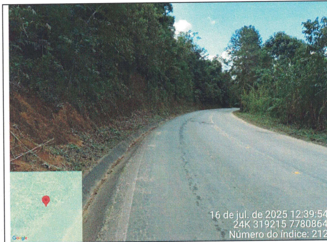
Foto 05: Serviço de roçagem e limpeza no Trecho 5
