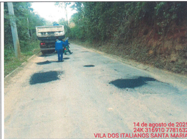
Foto 10: Serviço de tapa buraco no Trecho 2
