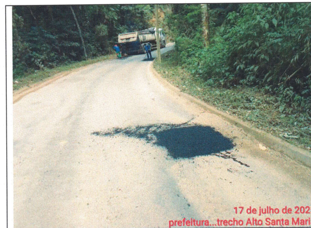
Foto 39: Serviço de tapa buraco no Trecho 06
