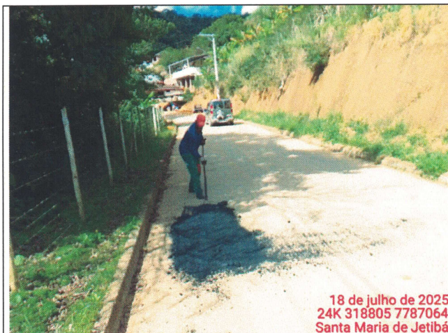
Foto 55: Serviço de tapa buraco no Trecho 11
