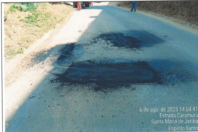
Foto 19: Serviço de tapa buraco no Trecho 15
