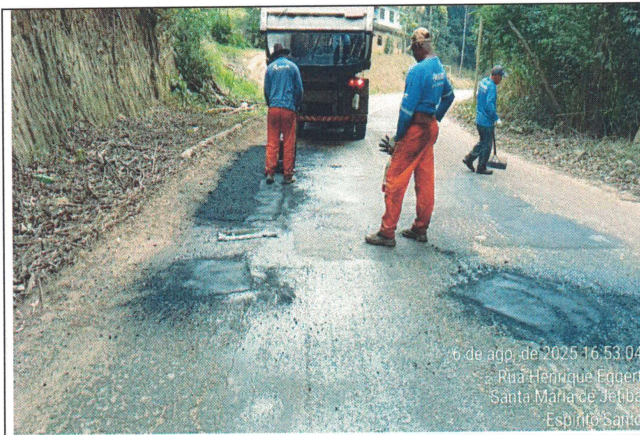
Foto 33: Serviço de tapa buraco no Trecho 13
