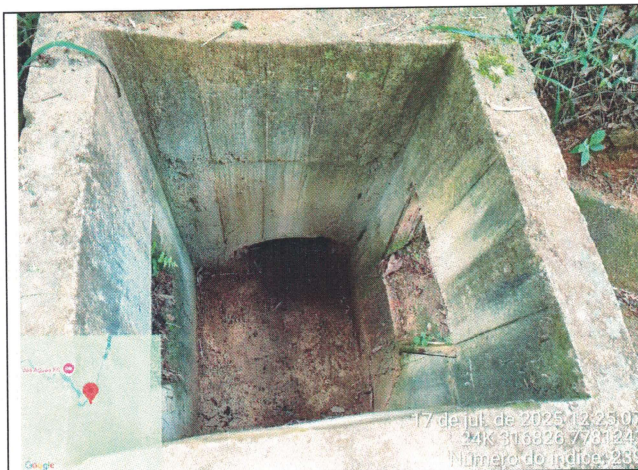
Foto 25: Serviço de roçagem e limpeza no Trecho 2
