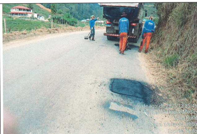
Foto 22: Serviço de tapa buraco no Trecho 15
