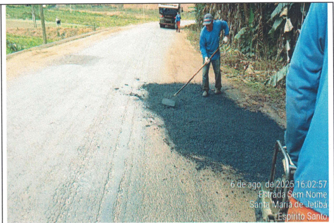
Foto 34: Serviço de tapa buraco no Trecho 13
