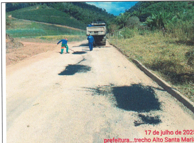
Foto 43: Serviço de tapa buraco no Trecho 06
