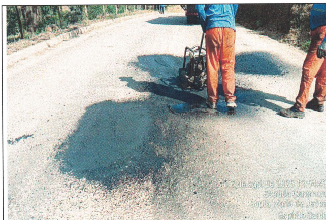
Foto 23: Serviço de tapa buraco no Trecho 15
