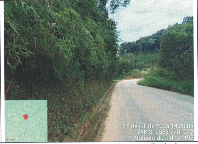
Foto 06: Serviço de roçagem e limpeza no Trecho 5
