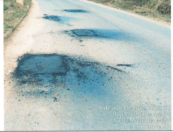
Foto 14: Serviço de tapa buraco no Trecho 15
