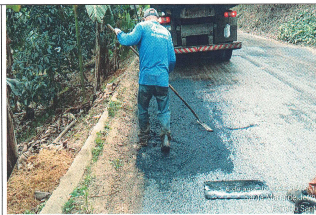
Foto 30: Serviço de tapa buraco no Trecho 13
