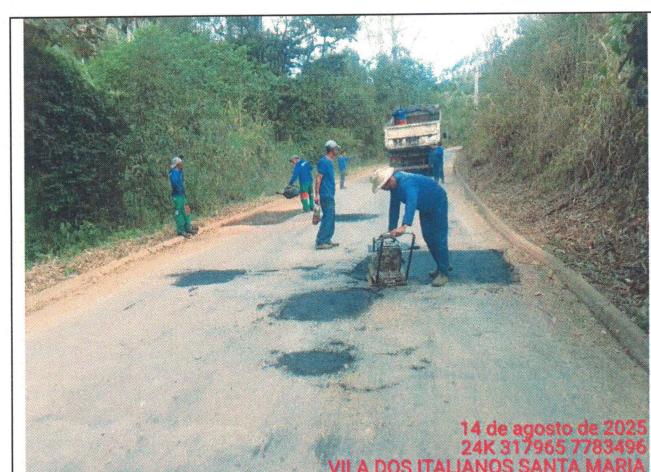
Foto 03: Serviço de tapa buraco no Trecho 2
