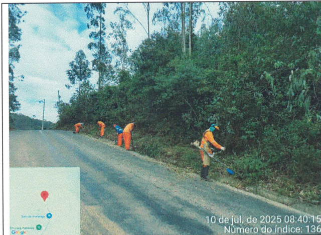
Foto 11: Serviço de roçagem e limpeza no Trecho 6
