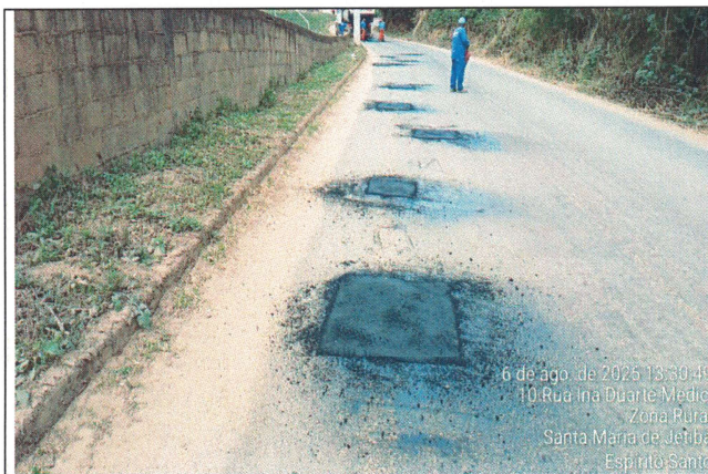
Foto 17: Serviço de tapa buraco no Trecho 15
