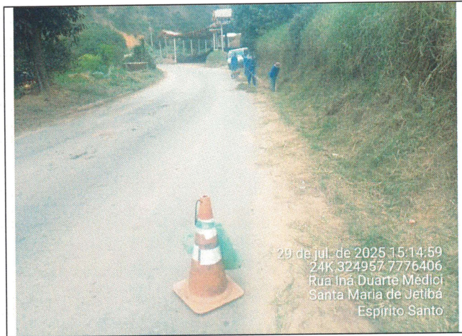
Foto 47: Serviço de roçagem e limpeza no Trecho 15
