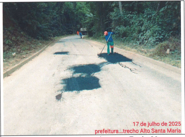
Foto 38: Serviço de tapa buraco no Trecho 06
