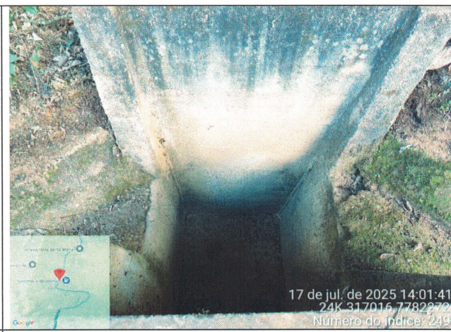
Foto 34: Serviço de roçagem e limpeza no Trecho 2
