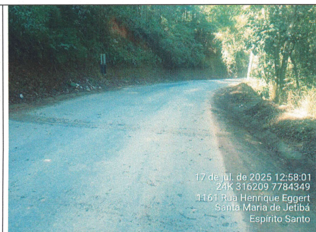
Foto 46: Serviço de roçagem e limpeza no Trecho 13
