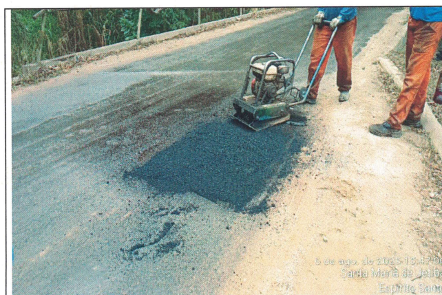
Foto 29: Serviço de tapa buraco no Trecho 13
