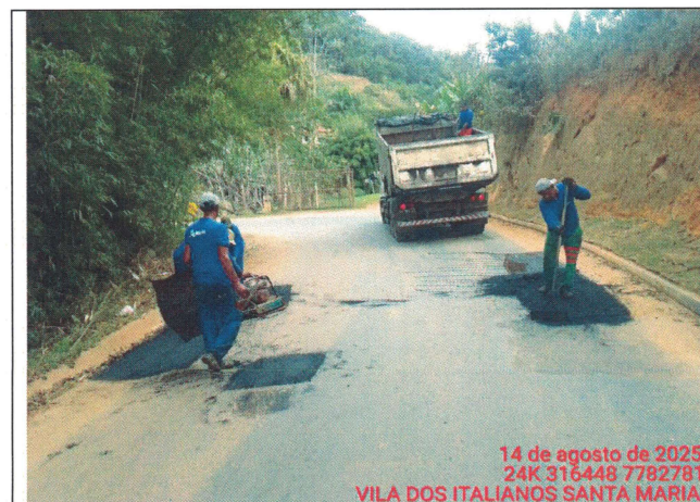
Foto 11: Serviço de tapa buraco no Trecho 2
