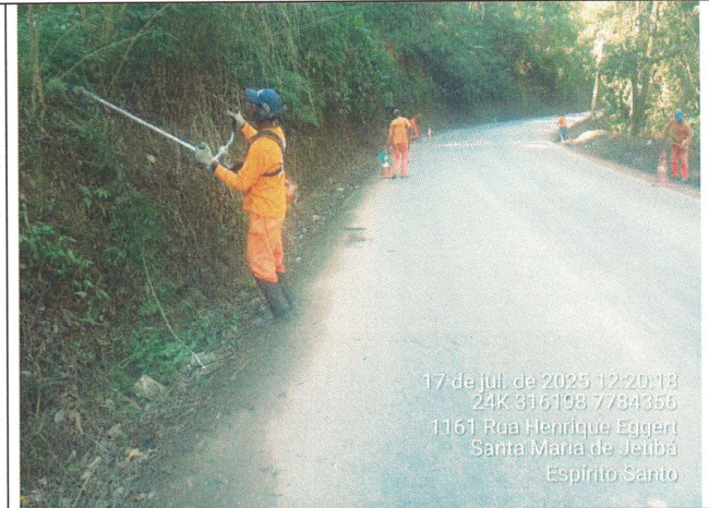
Foto 38: Serviço de roçagem e limpeza no Trecho 13
