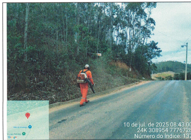
Foto 15: Serviço de roçagem e limpeza no Trecho 6
