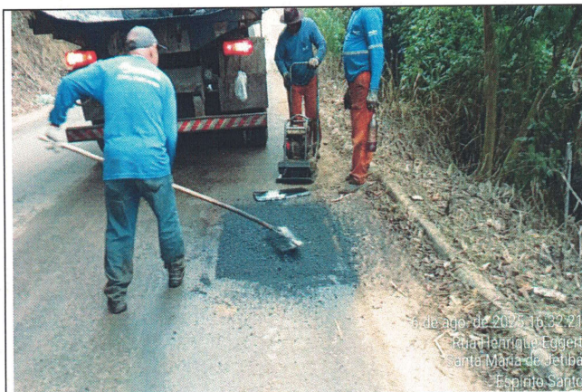
Foto 25: Serviço de tapa buraco no Trecho 13
