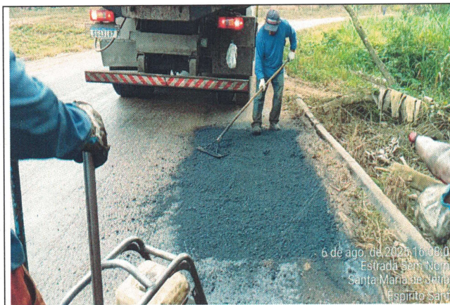
Foto 35: Serviço de tapa buraco no Trecho 13
