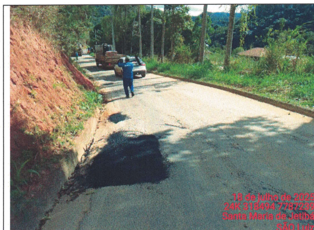
Foto 51: Serviço de tapa buraco no Trecho 11
