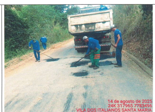
Foto 06: Serviço de tapa buraco no Trecho 2
