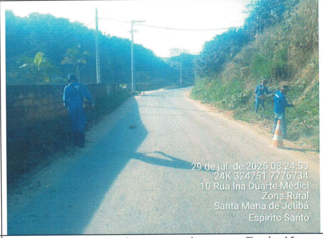
Foto 48: Serviço de roçagem e limpeza no Trecho 15
