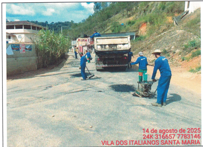
Foto 01: Serviço de tapa buraco no Trecho 2
