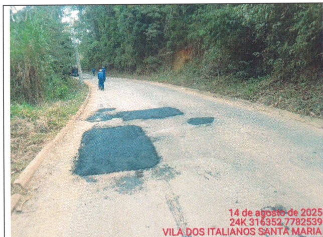
Foto 07: Serviço de tapa buraco no Trecho 2
