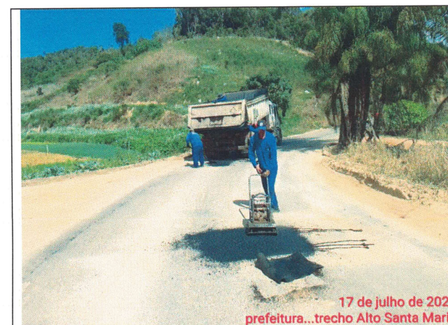
Foto 41: Serviço de tapa buraco no Trecho 06
