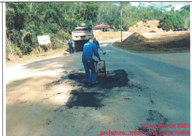
Foto 48: Serviço de tapa buraco no Trecho 06
