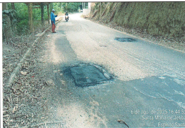
Foto 26: Serviço de tapa buraco no Trecho 13
