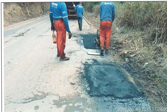
Foto 27: Serviço de tapa buraco no Trecho 13
