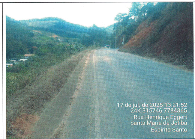
Foto 40: Serviço de roçagem e limpeza no Trecho 13
