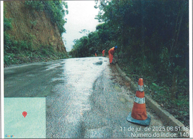
Foto 12: Serviço de roçagem e limpeza no Trecho 6
