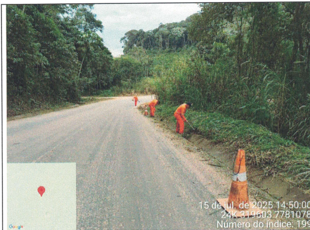
Foto 01: Serviço de roçagem e limpeza no Trecho 5
