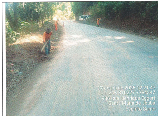
Foto 37: Serviço de roçagem e limpeza no Trecho 13
