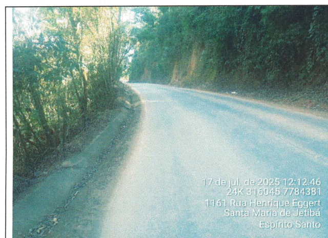
Foto 45: Serviço de roçagem e limpeza no Trecho 13
