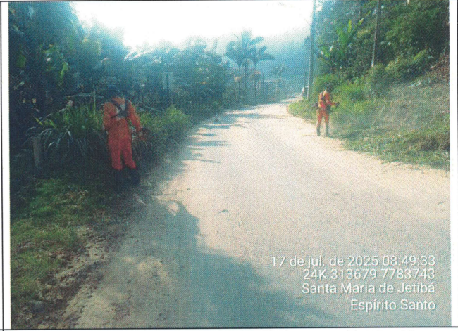
Foto 36: Serviço de roçagem e limpeza no Trecho 13
