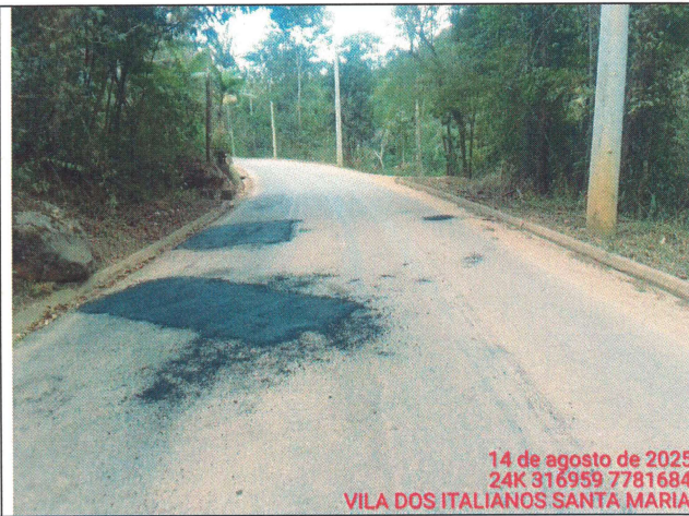
Foto 08: Serviço de tapa buraco no Trecho 2
