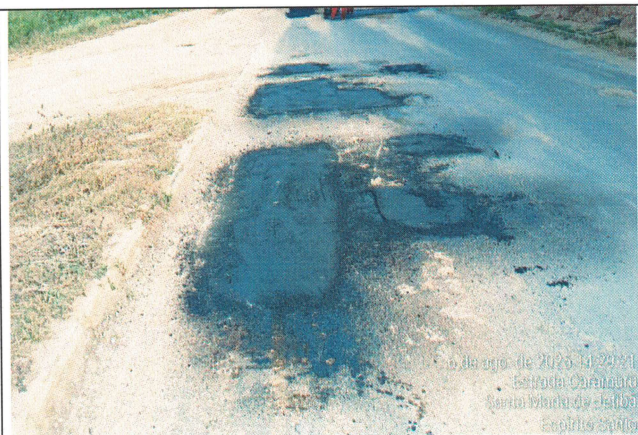
Foto 20: Serviço de tapa buraco no Trecho 15
