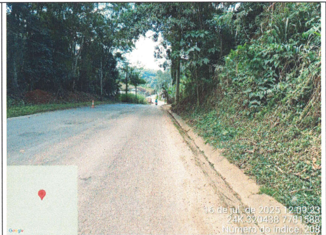
Foto 04: Serviço de roçagem e limpeza no Trecho 5
