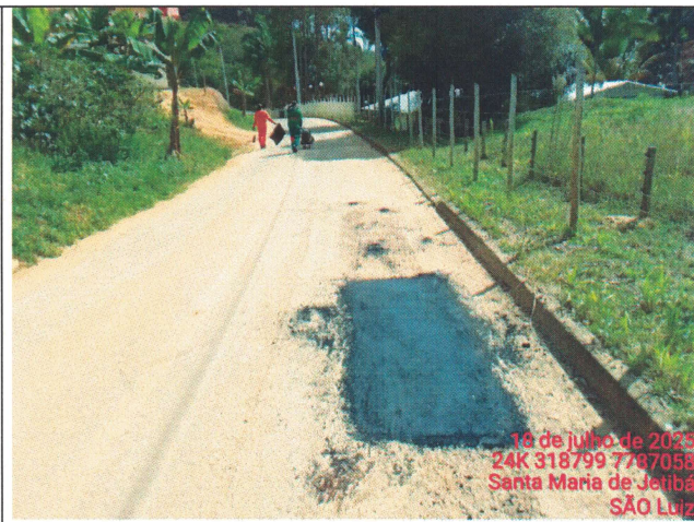
Foto 56: Serviço de tapa buraco no Trecho 11
