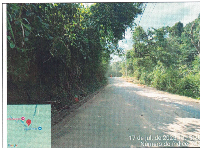
Foto 31: Serviço de roçagem e limpeza no Trecho 2
