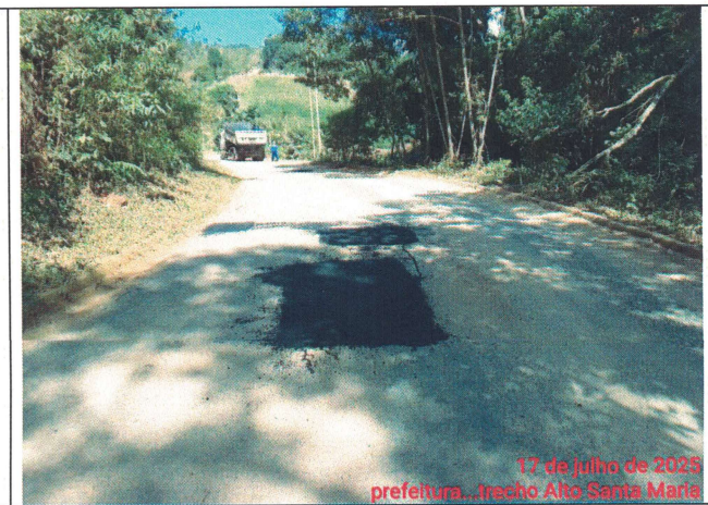
Foto 42: Serviço de tapa buraco no Trecho 06
