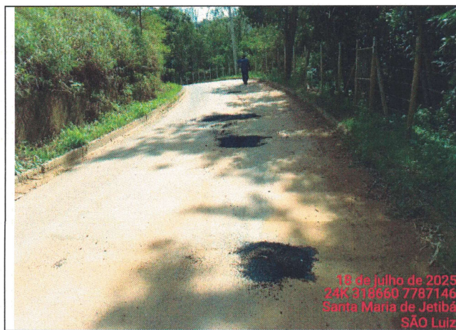
Foto 53: Serviço de tapa buraco no Trecho 11
