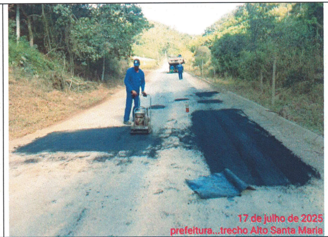
Foto 46: Serviço de tapa buraco no Trecho 06
