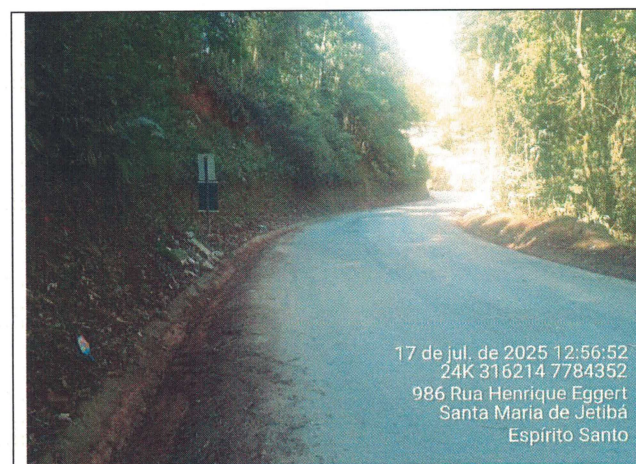
Foto 39: Serviço de roçagem e limpeza no Trecho 13
