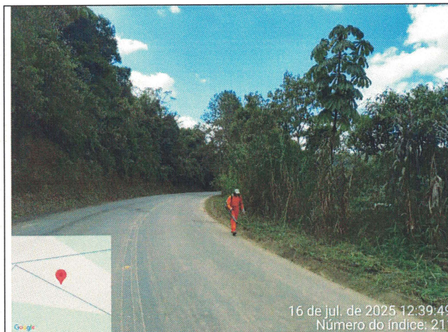
Foto 03: Serviço de roçagem e limpeza no Trecho 5
