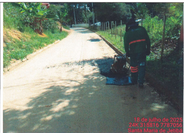
Foto 54: Serviço de tapa buraco no Trecho 11
