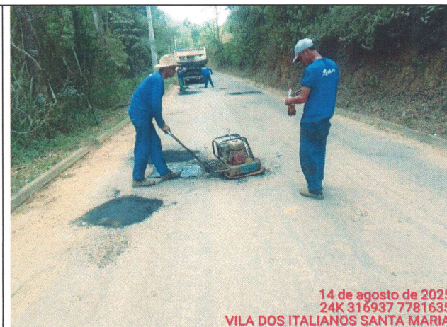
Foto 12: Serviço de tapa buraco no Trecho 2
