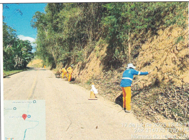
Foto 24: Serviço de roçagem e limpeza no Trecho 2
