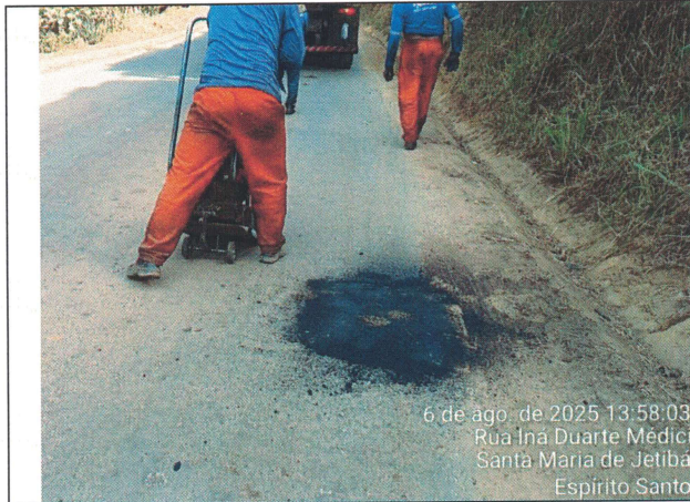
Foto 13: Serviço de tapa buraco no Trecho 15
