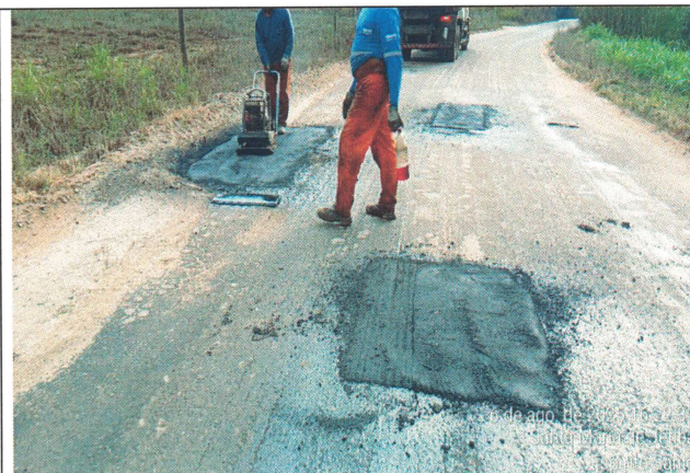
Foto 28: Serviço de tapa buraco no Trecho 13
