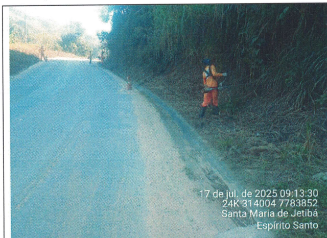
Foto 41: Serviço de roçagem e limpeza no Trecho 13
