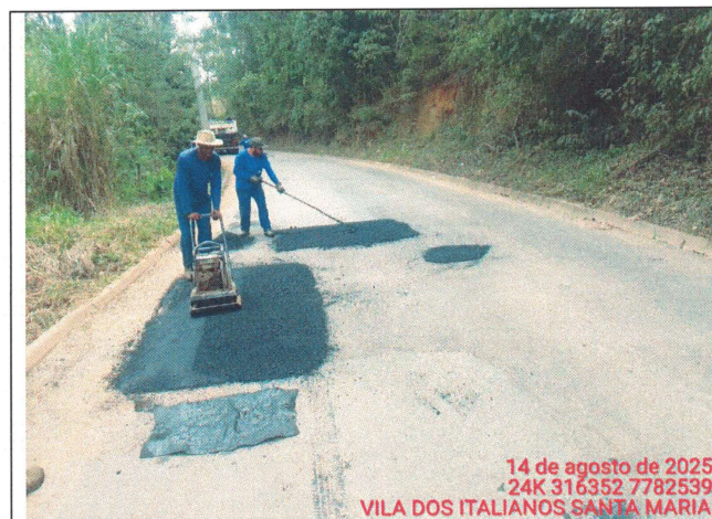
Foto 09: Serviço de tapa buraco no Trecho 2
