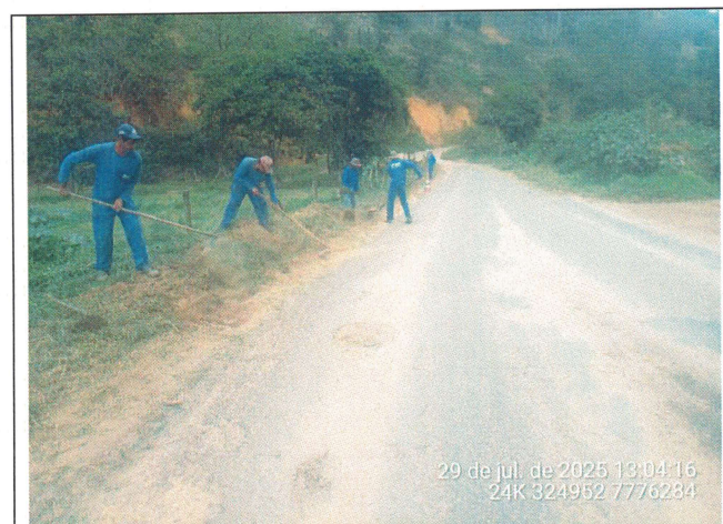
Foto 49: Serviço de roçagem e limpeza no Trecho 15
