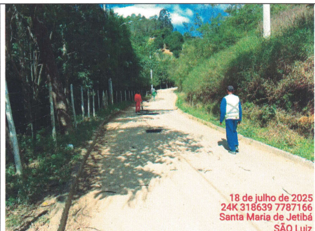
Foto 52: Serviço de tapa buraco no Trecho 11
