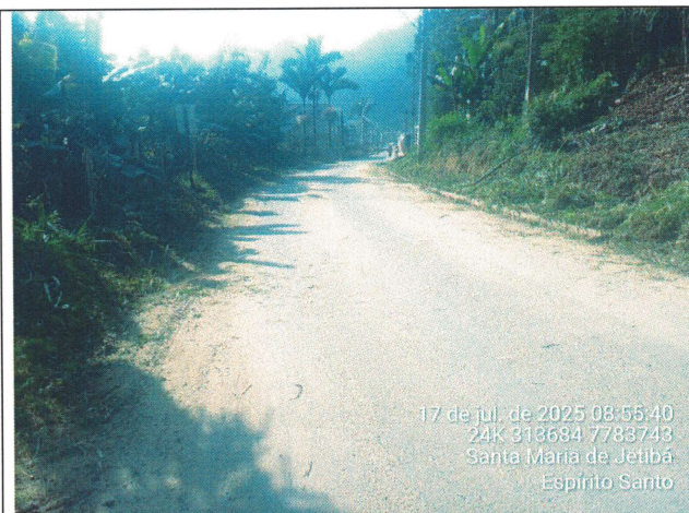
Foto 42: Serviço de roçagem e limpeza no Trecho 13
