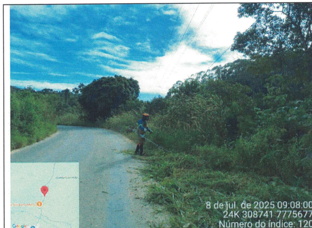
Foto 13: Serviço de roçagem e limpeza no Trecho 6
