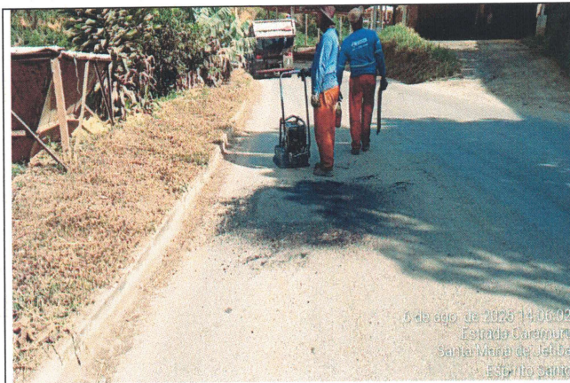
Foto 21: Serviço de tapa buraco no Trecho 15
