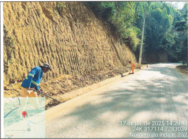
Foto 32: Serviço de roçagem e limpeza no Trecho 2
