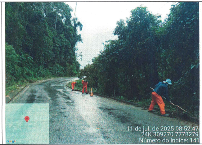
Foto 16: Serviço de roçagem e limpeza no Trecho 6
