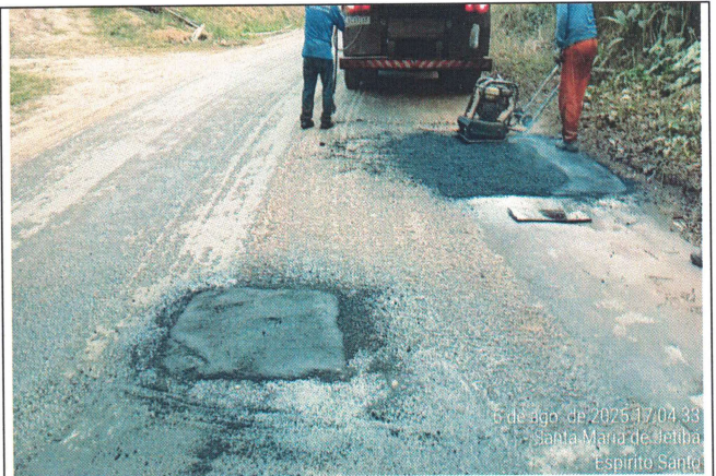
Foto 32: Serviço de tapa buraco no Trecho 13
