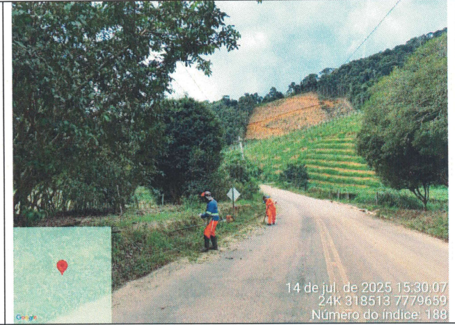
Foto 08: Serviço de roçagem e limpeza no Trecho 5
