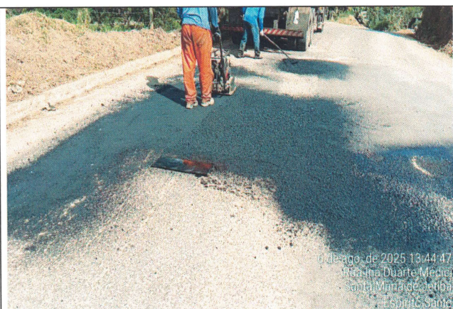
Foto 24: Serviço de tapa buraco no Trecho 15
