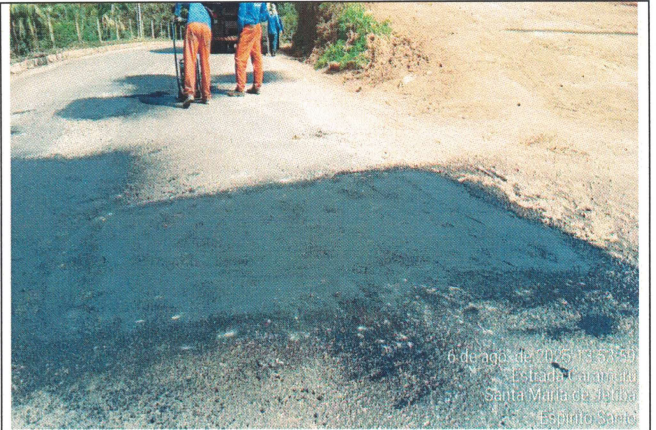
Foto 16: Serviço de tapa buraco no Trecho 15
