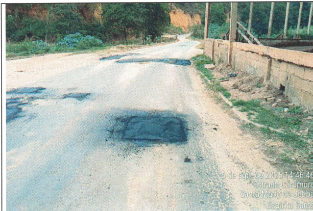
Foto 15: Serviço de tapa buraco no Trecho 15
