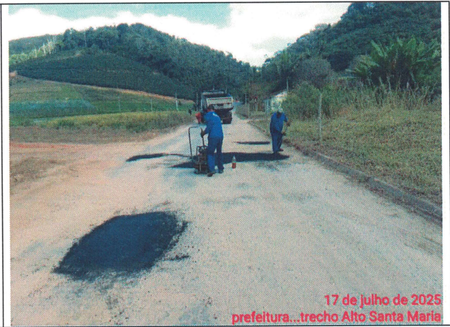
Foto 44: Serviço de tapa buraco no Trecho 06
