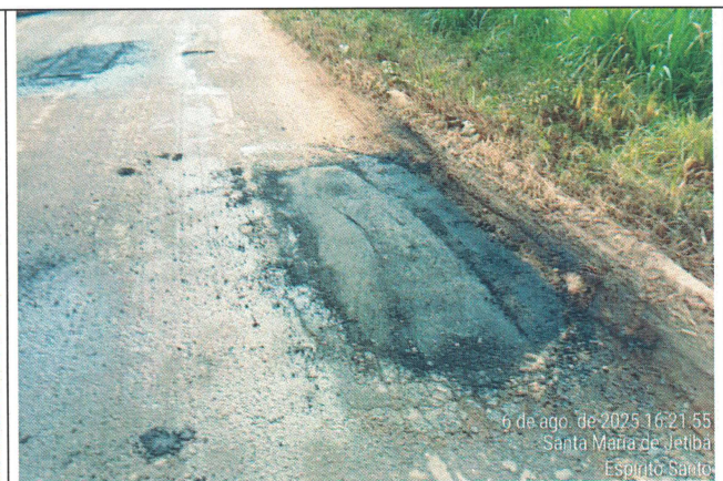
Foto 36: Serviço de tapa buraco no Trecho 13
