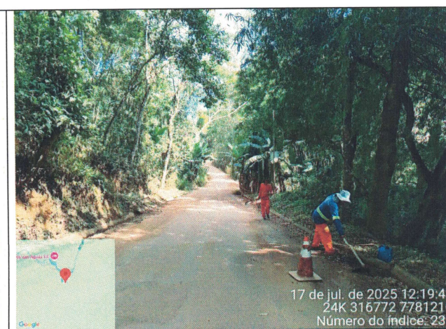
Foto 28: Serviço de roçagem e limpeza no Trecho 2
