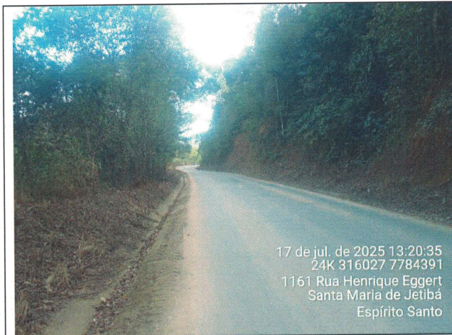
Foto 35: Serviço de roçagem e limpeza no Trecho 13
