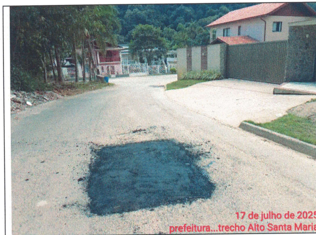
Foto 37: Serviço de tapa buraco no Trecho 06
