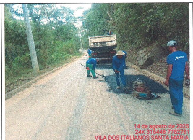
Foto 04: Serviço de tapa buraco no Trecho 2
