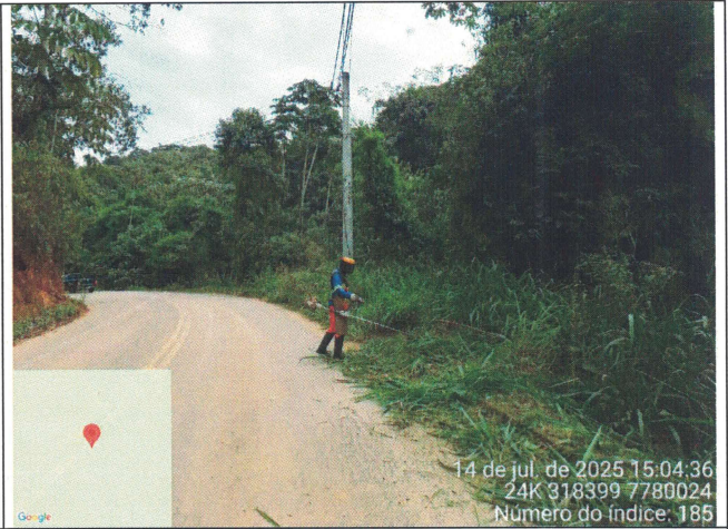
Foto 02: Serviço de roçagem e limpeza no Trecho 5
