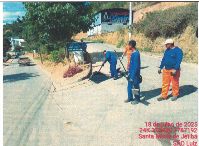
Foto 50: Serviço de tapa buraco no Trecho 11
