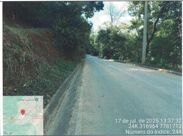
Foto 30: Serviço de roçagem e limpeza no Trecho 2
