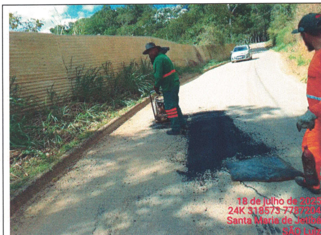
Foto 49: Serviço de tapa buraco no Trecho 11
