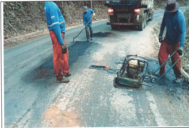
Foto 31: Serviço de tapa buraco no Trecho 13
