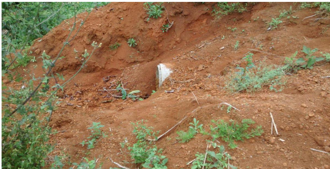
Localização - Saída do bueiro.
