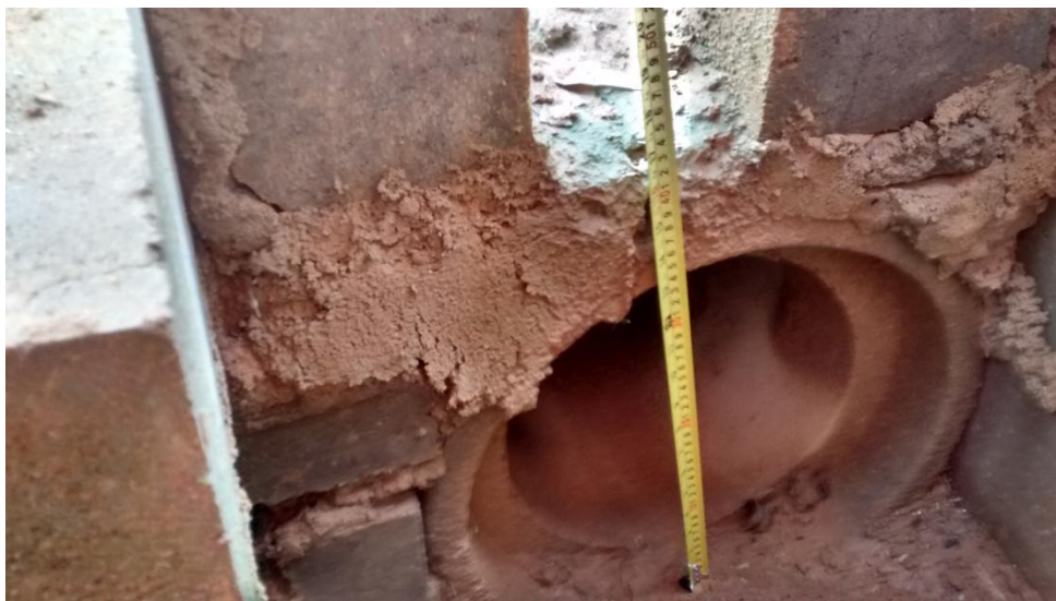
Medição da manilha - diâmetro 0,30.
