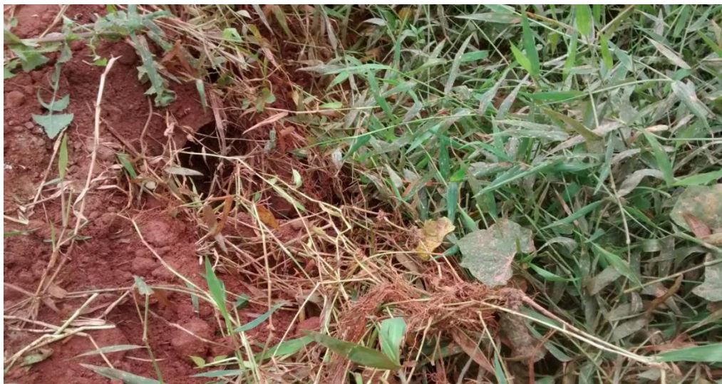
Localização - Saída do bueiro.
