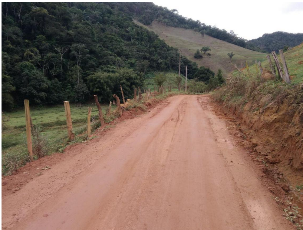
Localização - Instalação das manilhas.
