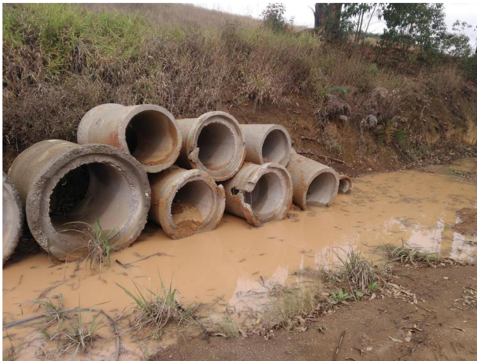
Manilhas no pátio da Sub-Prefeitura - Pedacos quebrados.
