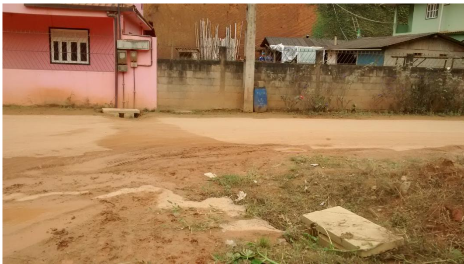
Localização - Instalação das manilhas.
