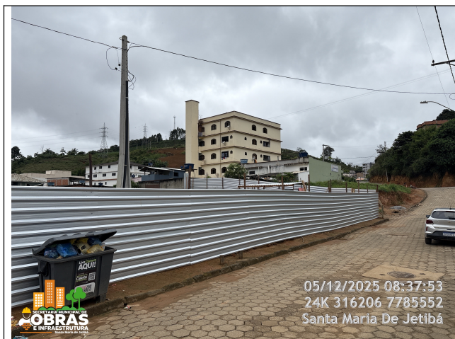
Foto 05: Tapume de fechamento da obra.
