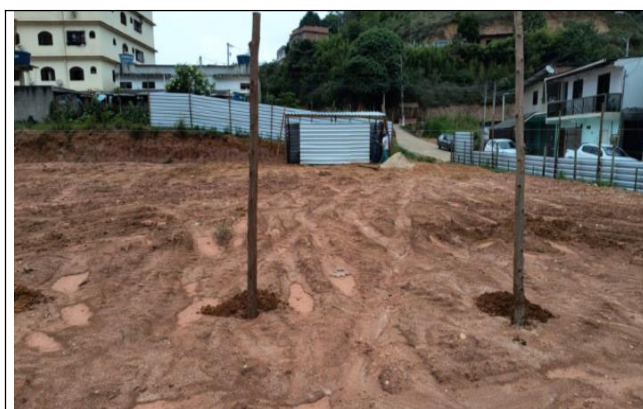
Foto 03: Execução de barracão alboxarifado no canteiro de obra.
