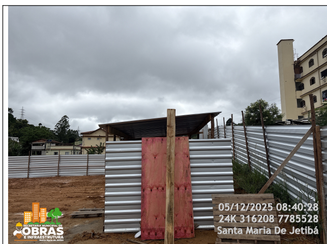
Foto 01: Execução de barracão alboxarifado no canteiro de obra.
