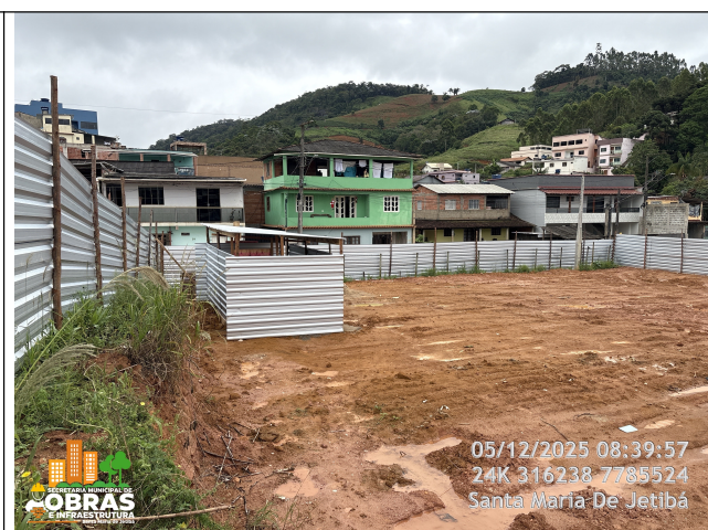
Foto 02: Execução de barracão alboxarifado no canteiro de obra.
