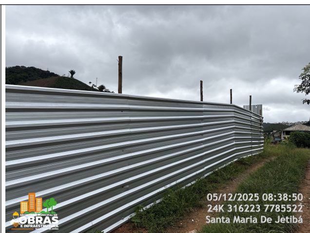
Foto 08: Tapume de fechamento da obra.
