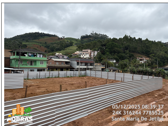
Foto 09: Tapume de fechamento da obra.
