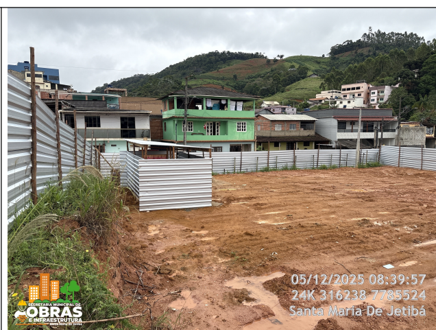
Foto 10: Tapume de fechamento da obra.
