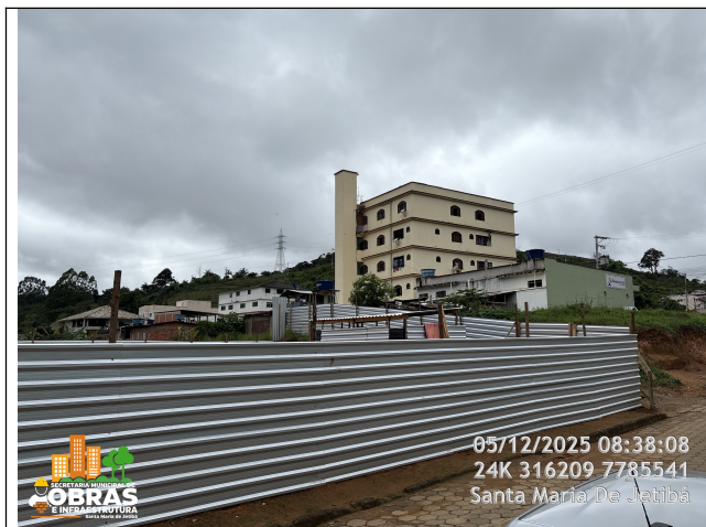
Foto 11: Tapume de fechamento da obra.
