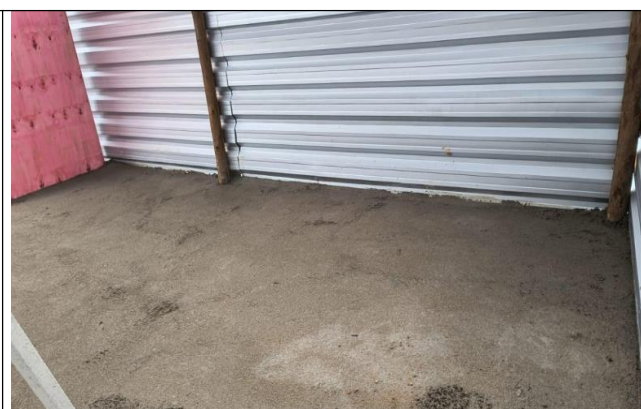
Foto 04: Execução de barracão alboxarifado no canteiro de obra.
