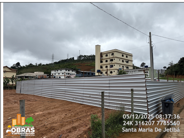
Foto 06: Tapume de fechamento da obra.
