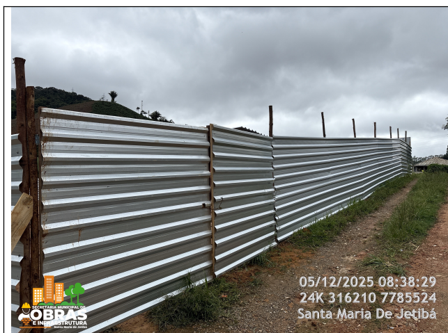
Foto 07: Tapume de fechamento da obra.
