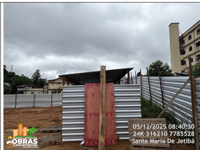
Foto 12: Tapume de fechamento da obra.
