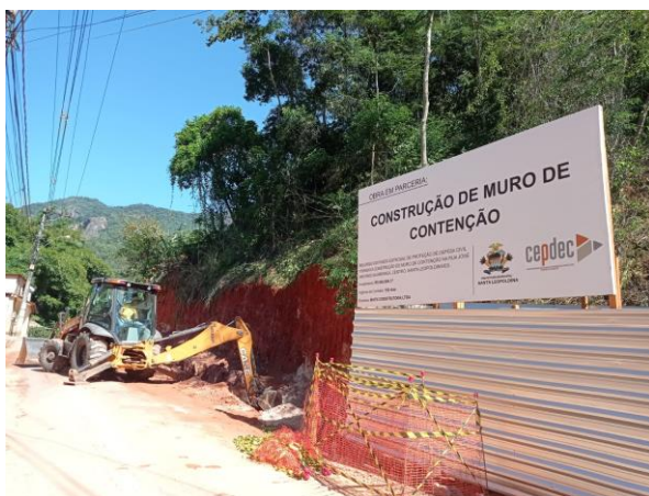
Obra de contenção de encosta em área de risco com recursos do Fundo de Defesa Civil
