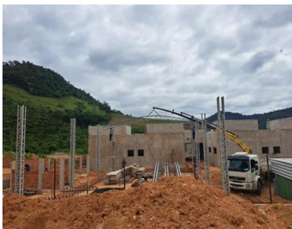
Construção da EMEIEF Santa Leopoldina
