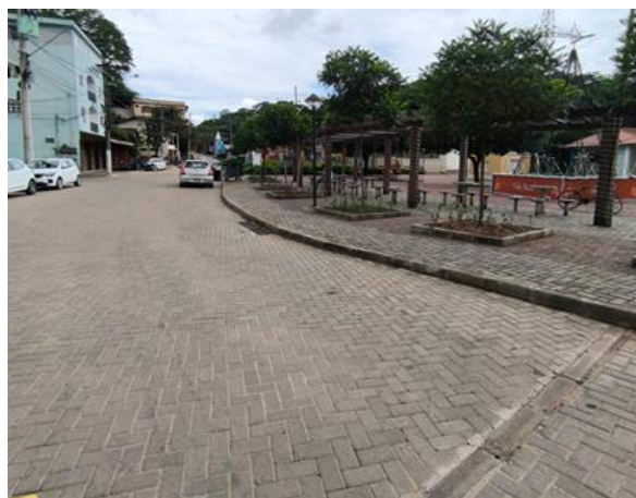
Pavimentação da Rua Bernardino Monteiro (Rua da Praça)
