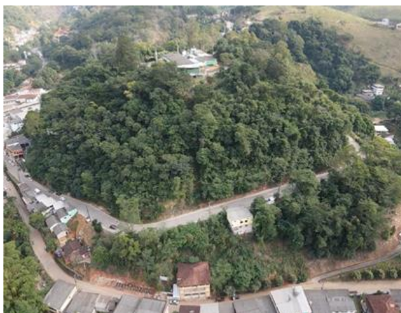
Pavimentação da Ladeira do Hospital Nossa Senhora da Penha
