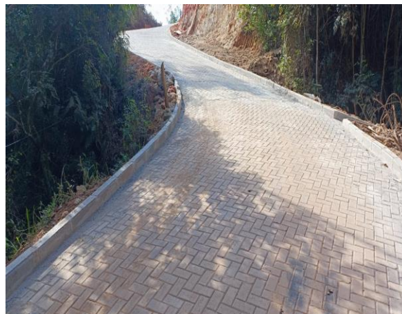
Pavimentação na Comunidade do Rio das Farinhas – Trecho Morro da Madeira
